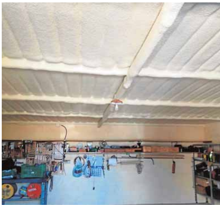
Un techo cubierto de poliuretano de Aispomur. Aispomur
