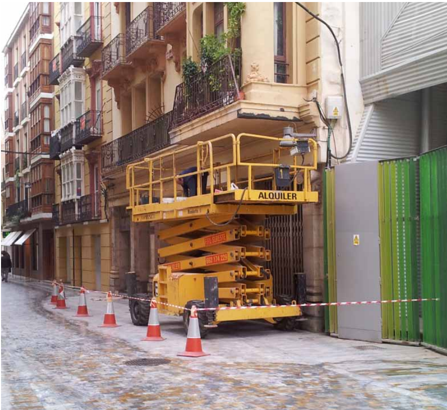
Reparación de fachada en edificio de viviendas
