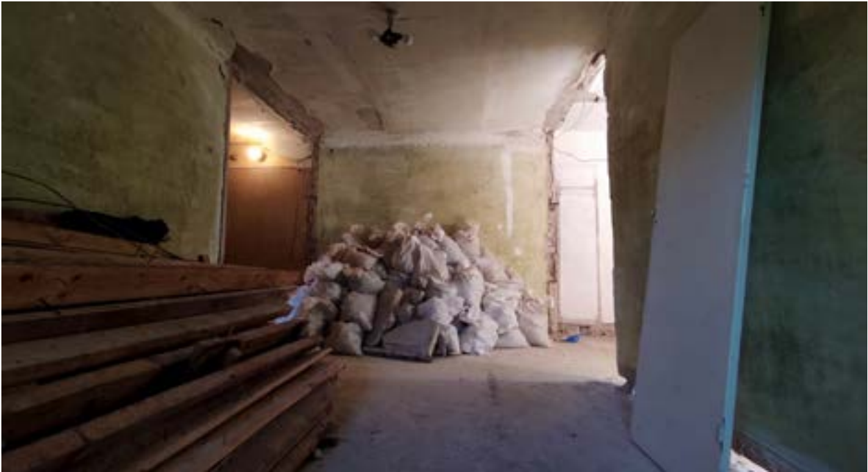
Imagen 13. ..... Acopio de residuos de construcción y demolición
