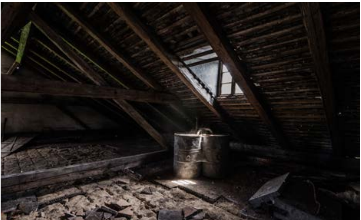
Imagen 14. ..... Demolición parcial bajo cubierta
