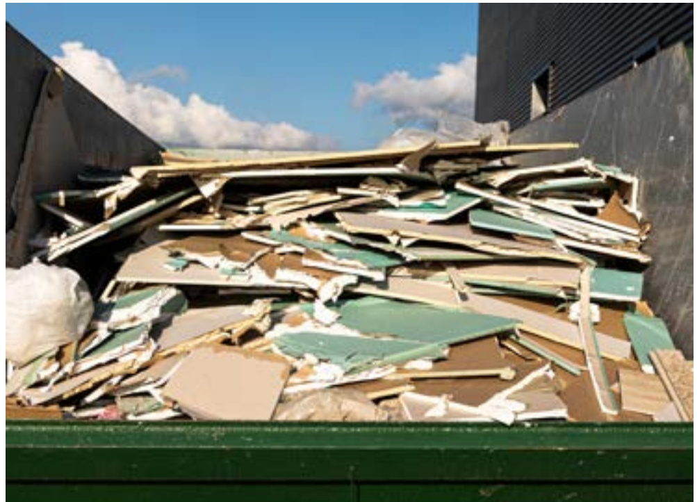
Imagen 16. ..... Reciclaje de paneles de yeso laminado
