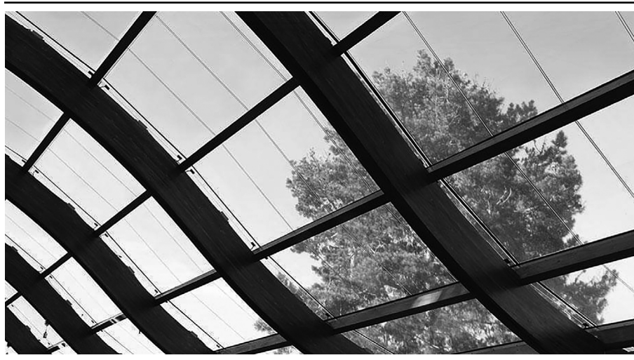
Figura 5.1. Imatge d'un sistema fotovoltaic integrat en un edifici. Font: Onyx Solar.
