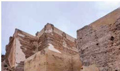
Castillejo de Monteagudo, Murcia. Técnicas constructivas y paramentos ya restaurados. Autor: Evan Guillén.
