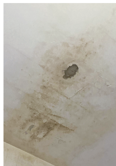
Imagen 17. Filtración.
