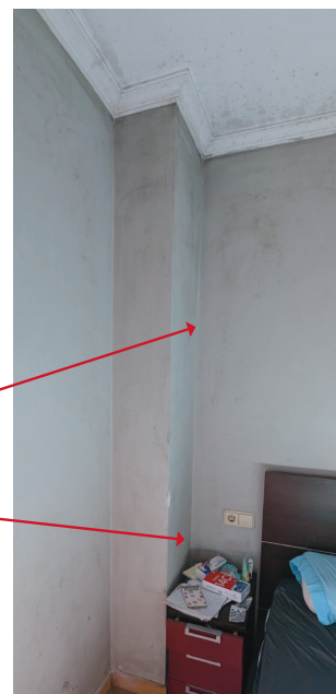
Imagen 86. Humedades en medianera: Deficiencia.
