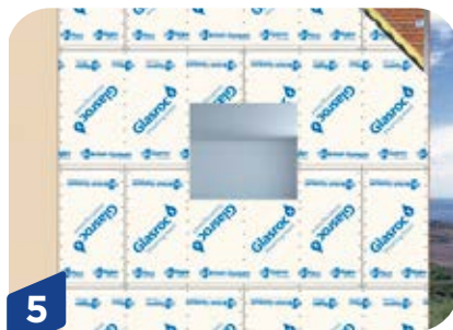
5 Instalación de Glasroc® X
