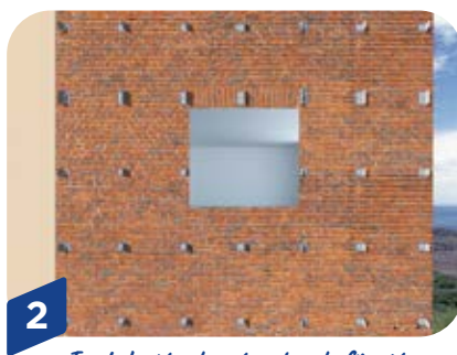
2 Instalación de ménsulas de fijación
