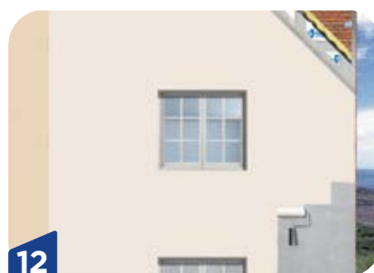
12 Aplicación de imprimación sobre la capa base de mortero
