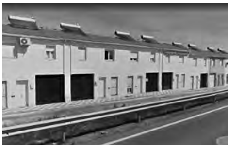
Figura 1. Paneles solares en cubierta sin acceso: Al no taparse se aprecia que todos han reventado por exceso de calor y presión.
