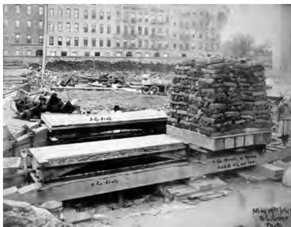
Figura 1: Prueba de carga de una bóveda de Rafael Guastavino.
