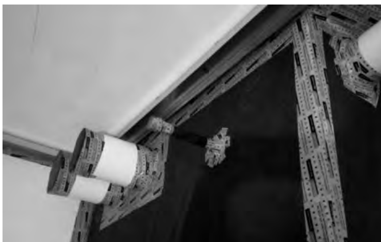
Figura 6: Tratamiento y sellado de paso de instalaciones.
