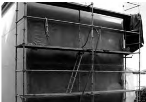
Figura 5: Muro con revoco antiguo revocado proyectado con monocapa.
