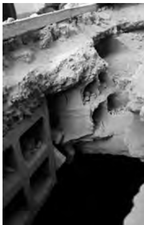
Figura 5: Estado de la capa de compresión forjado.
