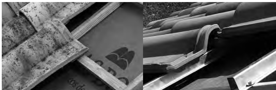
Figura 6.- Colocación de la teja sobre doble rastrel con un espacio para la microventilación de 40 mm.
