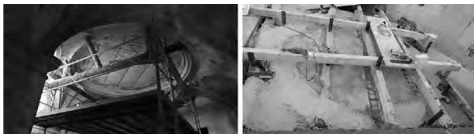
Figura 4: Rehabilitación de plafón nordeste y vista del refuerzo de estructura de la esquina sureste de las galerías del claustro.
