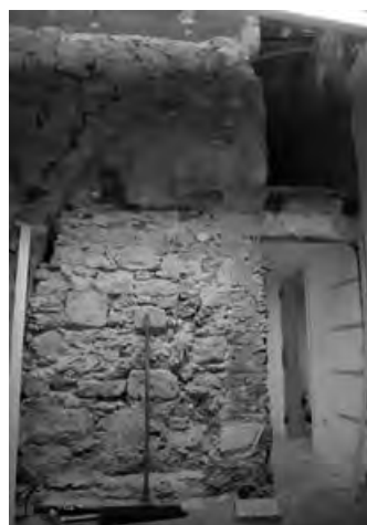
Figura 4: Arco existente a recuperar.
