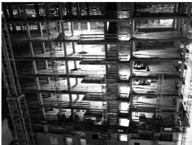
Figura 6: Iluminación de la obra con pantallas LED.
