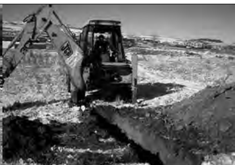
Figura 2. Retroexcavadora durante la excavación de una calicata.
