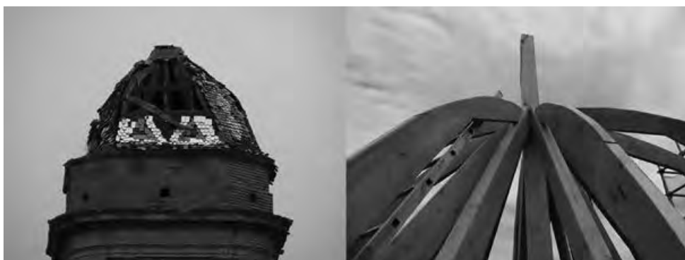
Figura 2. A la izquierda, estado inicial del chapitel; a la derecha, armazón nuevo.
