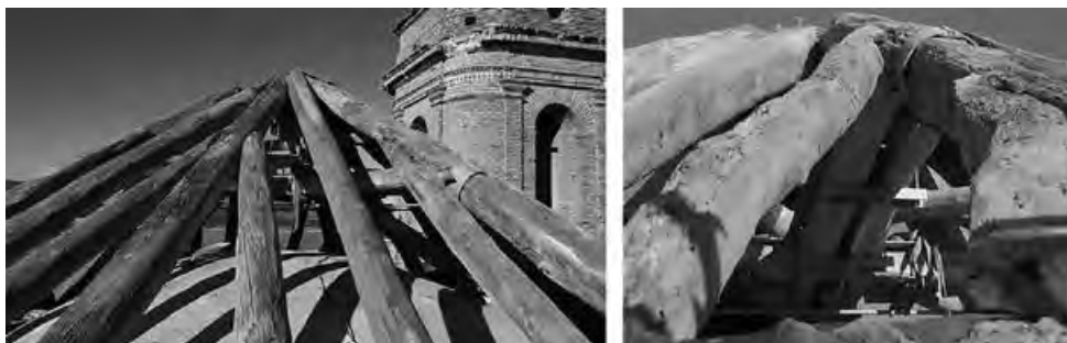
Figura 3: Entramado de cubierta del cimborrio del crucero de la iglesia con refuerzos metálicos.
