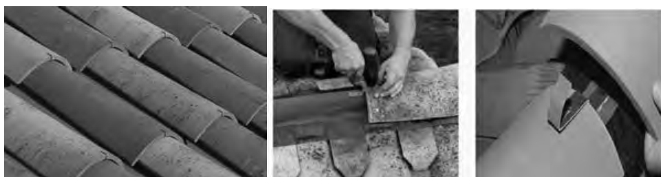
Ganchos de fijación de las tejas curvas
