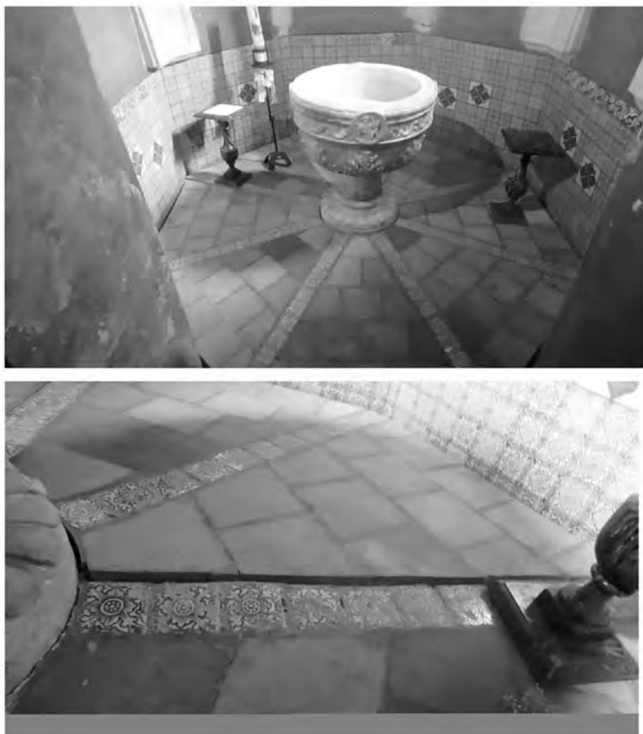
Figura 1. Arriba, aspecto general de la Capilla Bautismal tras la restauración. Abajo, detalle de la solera afectada por expansividad por ataque sulfatado con formación de taumasita.
