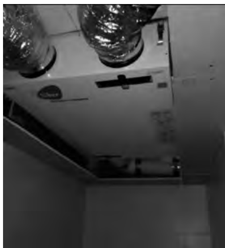
Figura 10: Recuperador de Calor.
