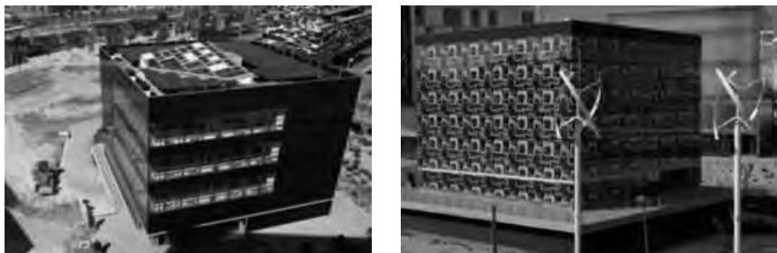
Figura 4 Fachadas Sur y captadores solares fotovoltaicos. Fachadas norte vidrio serigrafiado. M. Sánchez Iturbe.
