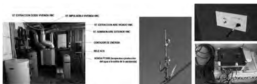
Figura 5. Sistema de monitorización. (Fuente: Elaboración propia).
