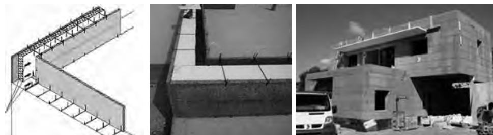
Figura 4. Esquema de montaje y resultado final del proceso de muros. (Fuente: Elaboración propia).
