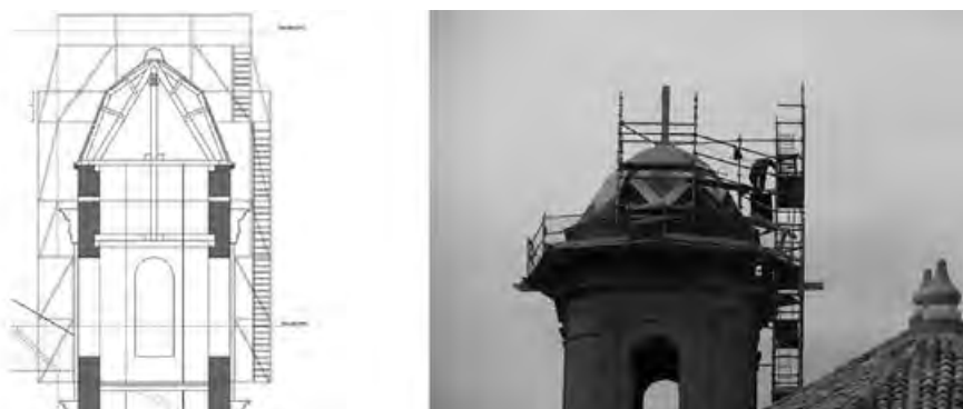
Figura 3: A la izquierda, diseño del andamio del TFG; a la derecha, vista del andamio y plataforma instalados.
