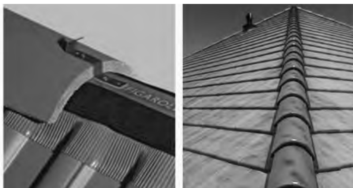
Figura 9.- Colocación de la banda impermeable microperforada y de las piezas de caballete.
