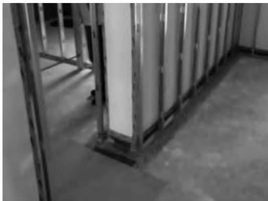
Figura 5: Trasdoso de protección para línea de hermeticidad en muro de carga.
