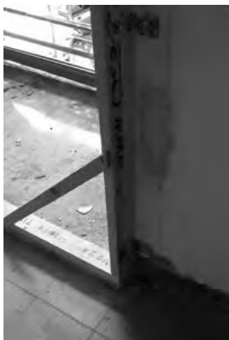
Figura 9: Colocación de premarco de madera.
