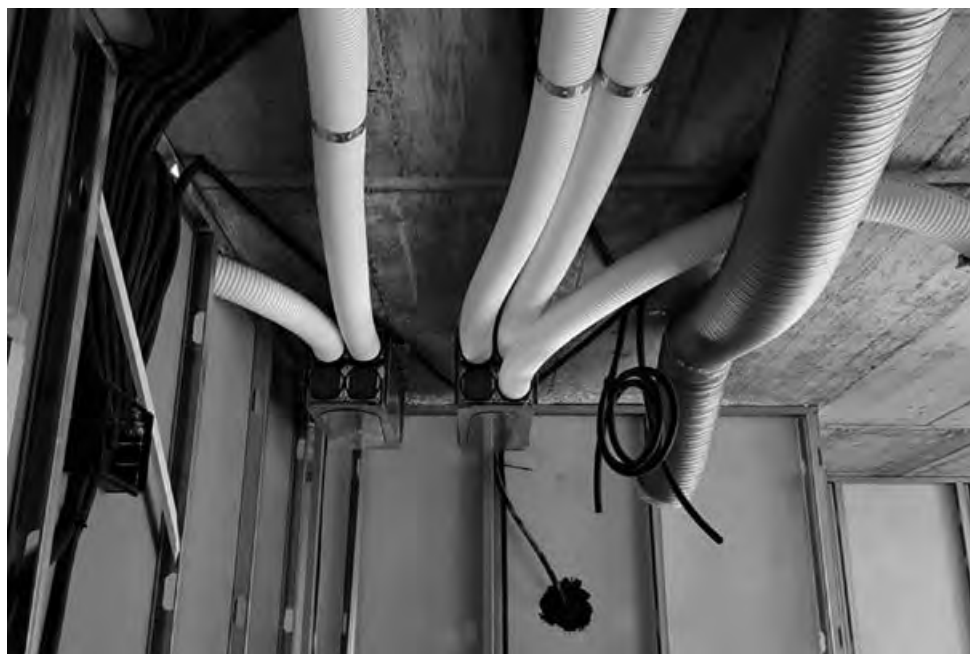
Figura 5. Ventilación de doble flujo con distribución en árbol.
