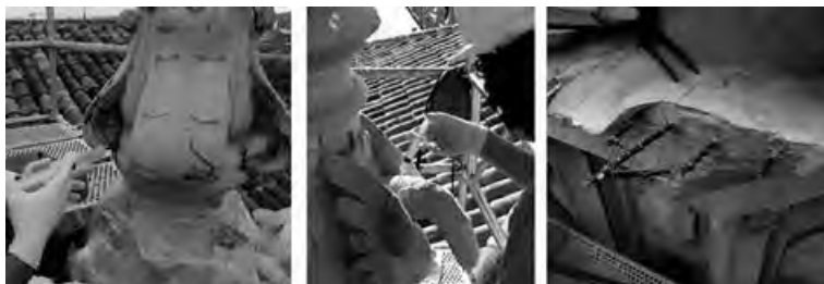
Figura 4. Izquierda Procesos realizados en la Fase IV, de reintegración de piezas dañadas. Izquierda y centro: Relleno de fisuras con inyecciones epoxi. Derecha: Anclajes de varillado. Fuente: Autores.
