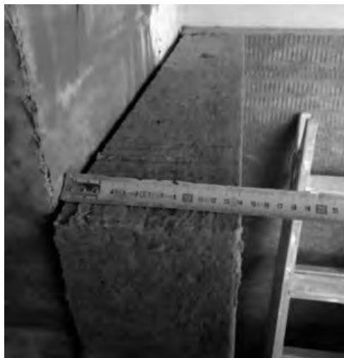
Figura 8: Aislamiento de fachada.
