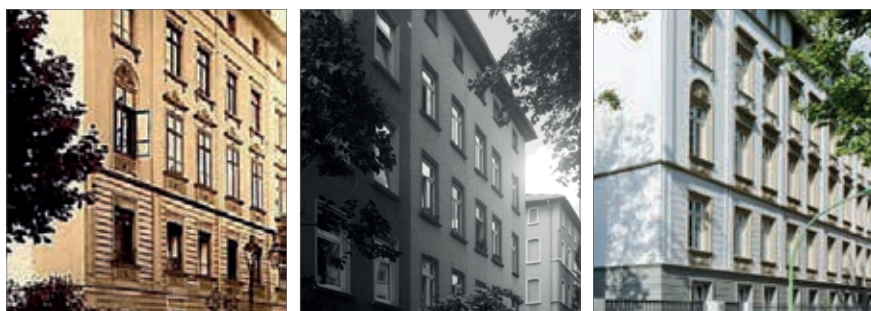
Edificio en Frankfurt, de izquierda a derecha: fachada original, fachada rehabilitada de emergencia con SATE después de la Segunda Guerra Mundial e imagen actual de la fachada en una segunda rehabilitación con SATE, actualizándolo a las normativas de ahorro energético actuales y recuperando su apariencia original.
