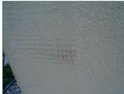
Cubrición insuficiente de la malla de refuerzo.
