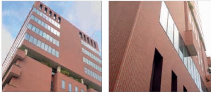
Edificio de FIATC en Barcelona, rehabilitado con SATE acabado con plaquetas cerámicas de ladrillo visto.
