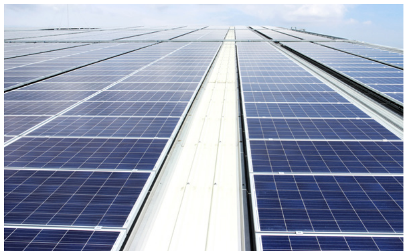
Figura 4.2. Paneles fotovoltaicos sobre cubiertas tipo sándwich
