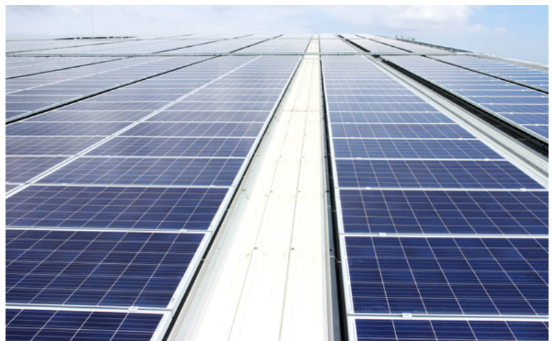
Figura 4.2. Paneles fotovoltaicos sobre cubiertas tipo sándwich
