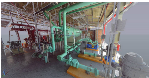
Figura 3.35. Levantamiento 3D de instalación en servicio con escáner digital y nube de puntos
