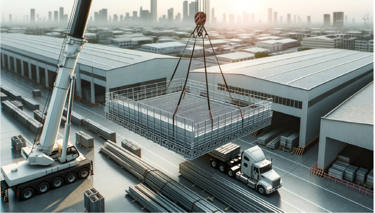
Figura 4.10. Montaje de placas alveolares con barandillas integradas desde el suelo para el montaje. Ficha de procedimiento de montaje incluida en modelo BIM para la fase de construcción. Este sistema permite la protección en avance durante el montaje
