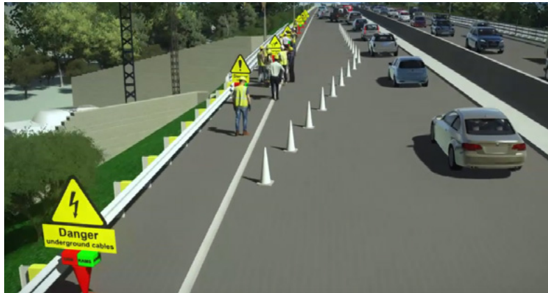
Figura 3.36. Simulación 4D de trabajos de mantenimiento de carretera
