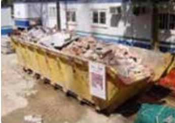
Separación de residuos en obra. Fuente: Ihobe sociedad pública de educación ambiental. Manual Ihobe para redacción e implantación de plan de gestión de residuos de construcción y demolición y buenas prácticas gremiales. 2012
