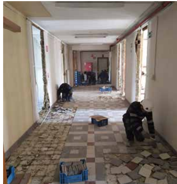
Recuperación de solado hidráulico en una demolición. Fuente: Rotordc www.rotordc.com
