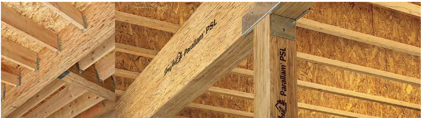
Fig 4. Perfiles de aglomerado de astillas (PSL).
