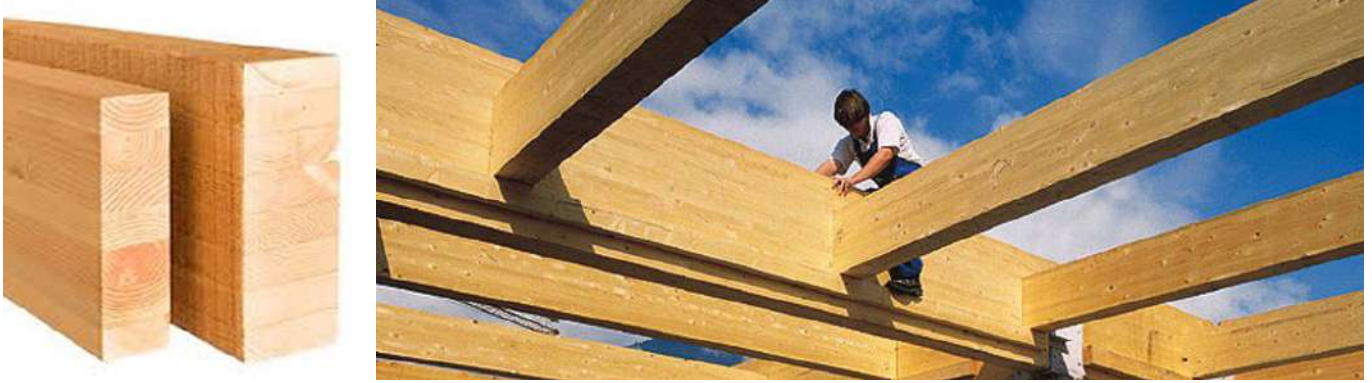
Fig 2. Piezas lineales prefabricadas de madera laminada.
