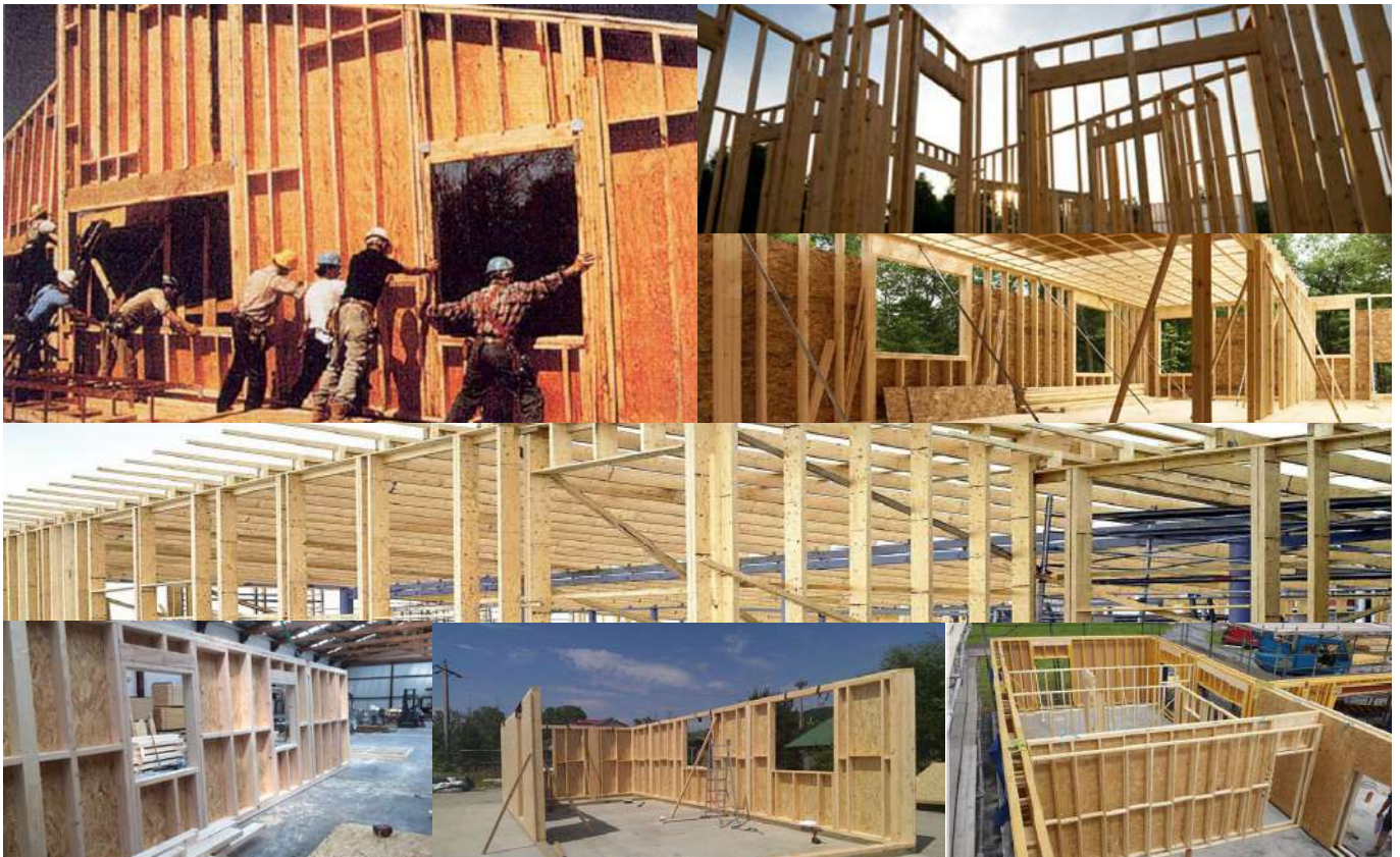
Fig 15. Paneles mediante entramado ligero de madera.
