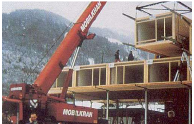
Fig 52. Módulos de madera apoyados sobre un pódium de hormigón.
