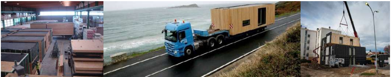
Fig 37. Ejemplos de construcción modular cerrada en madera de la empresa Egoín.
