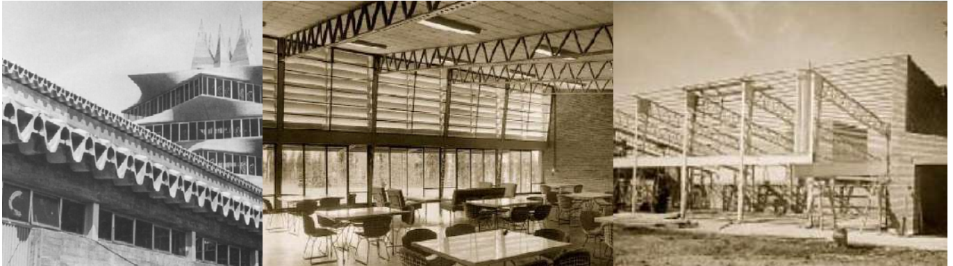
Fig 8. Interior y proceso constructivo de los Comedores de la SEAT.
