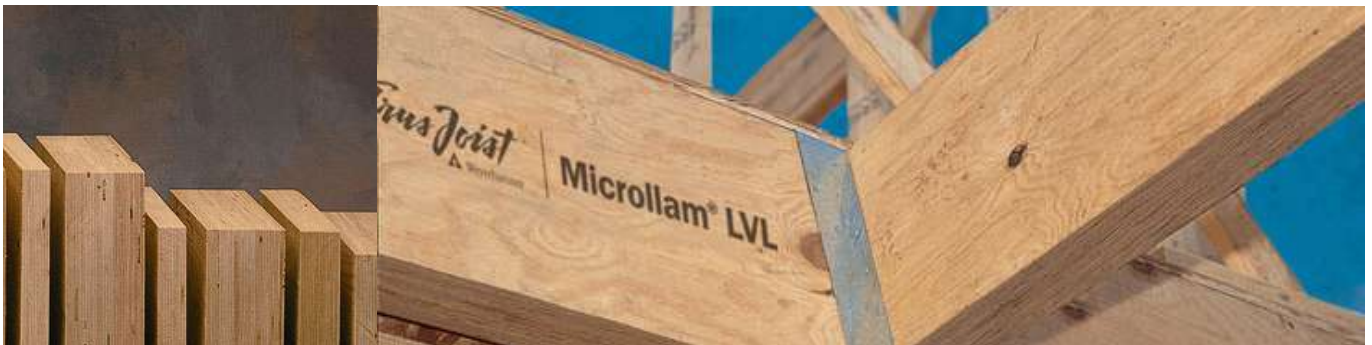
Fig 3. Elementos lineales de madera microlaminada.
