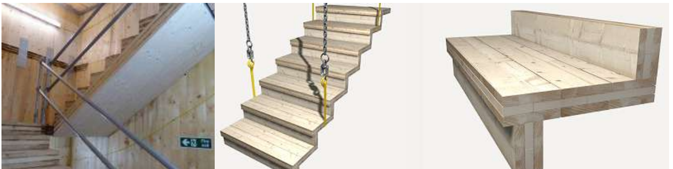
Fig 18. Losas inclinadas y peldaños mediante paneles de CLT.
