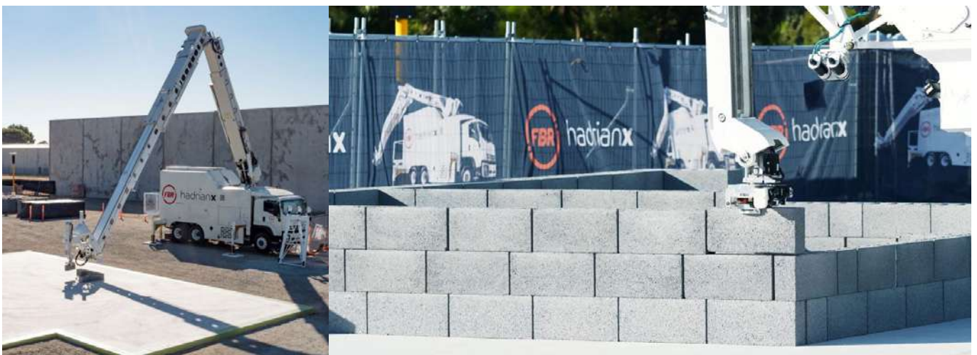
Fig 55. Colocación de bloques y ladrillos por robots por la empresa FastBrick.
