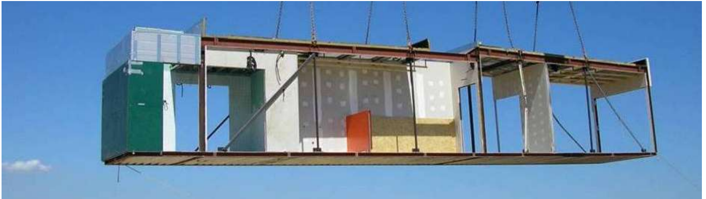
Fig 45. Sistema compuesto de varios módulos abiertos (Modultec).
