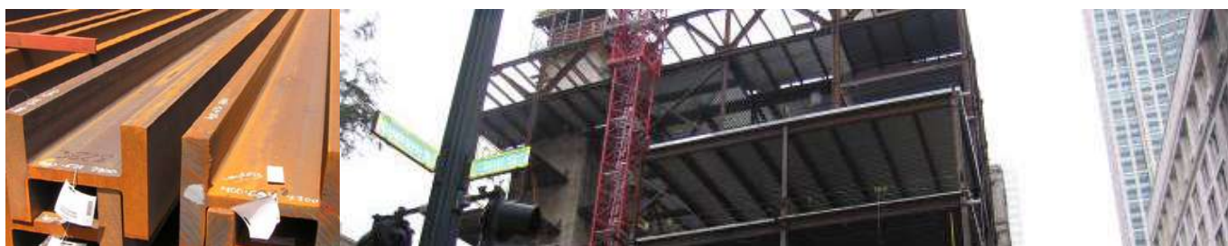
Fig 8. Ejemplo de pilares tipo I. Fuente: Arcelor Mittal ITEA, Juan M º Sansinenea.
