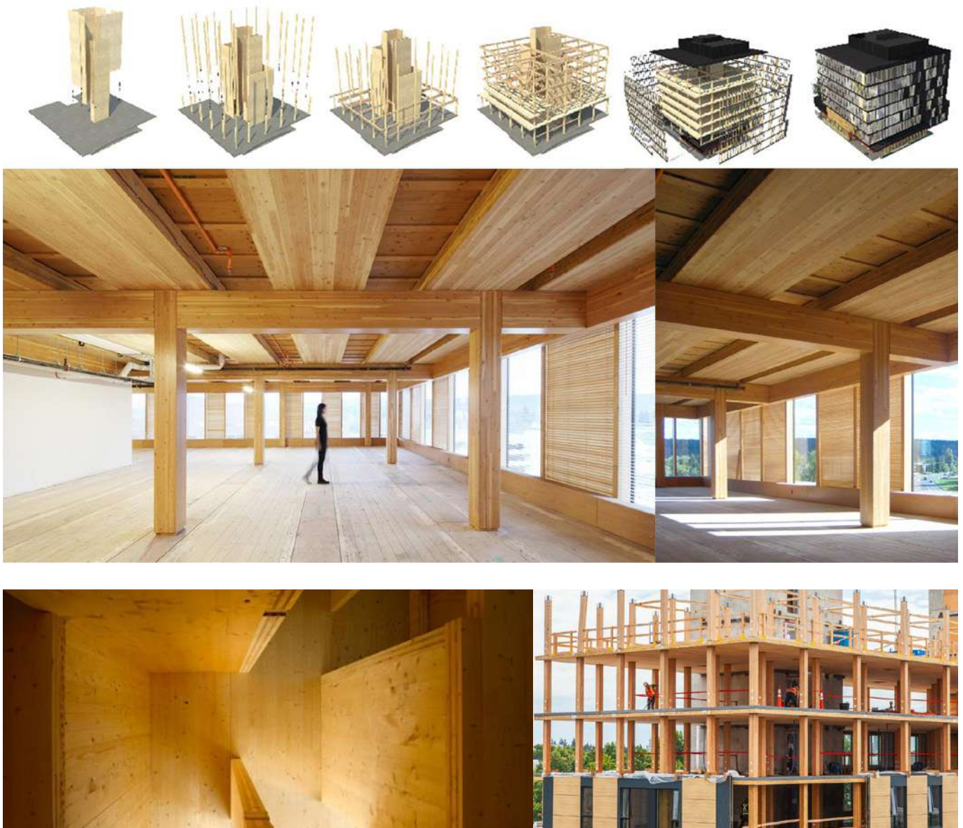
Fig 19. Rascacielos de madera mediante paneles de CLT.
