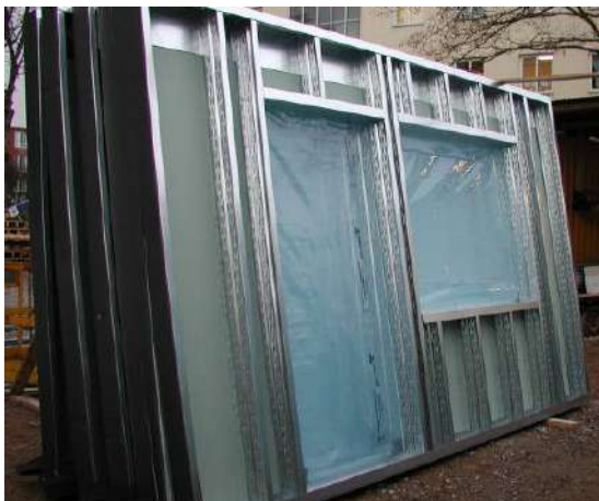
Fig 28. Muro portante utilizando una estructura de acero ligero con montantes ranurados (SCI).
