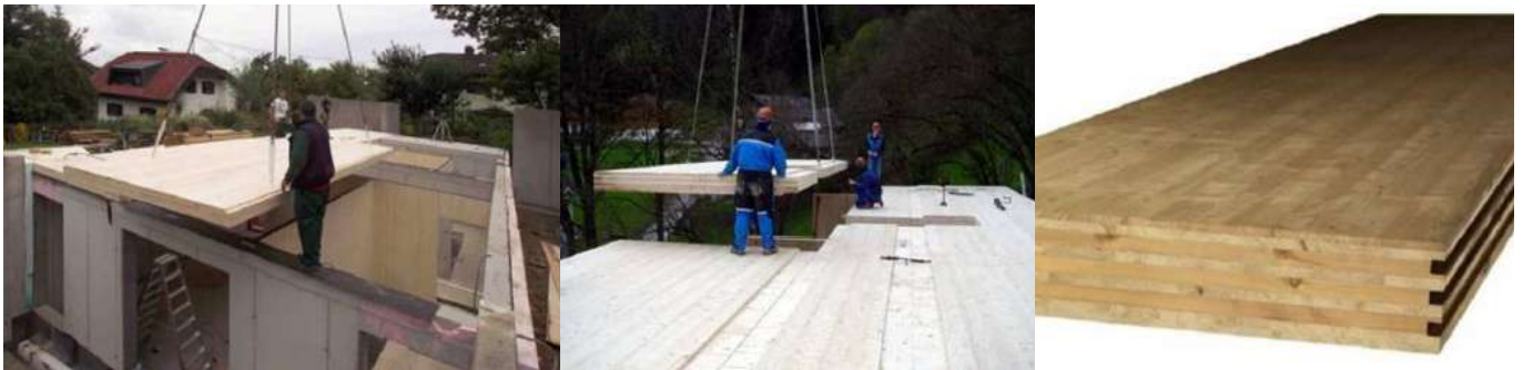
Fig 16. Forjados mediante paneles de contralaminado de madera.
