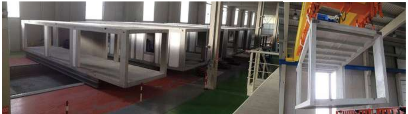
Fig 48. Módulos de hormigón abiertos.
