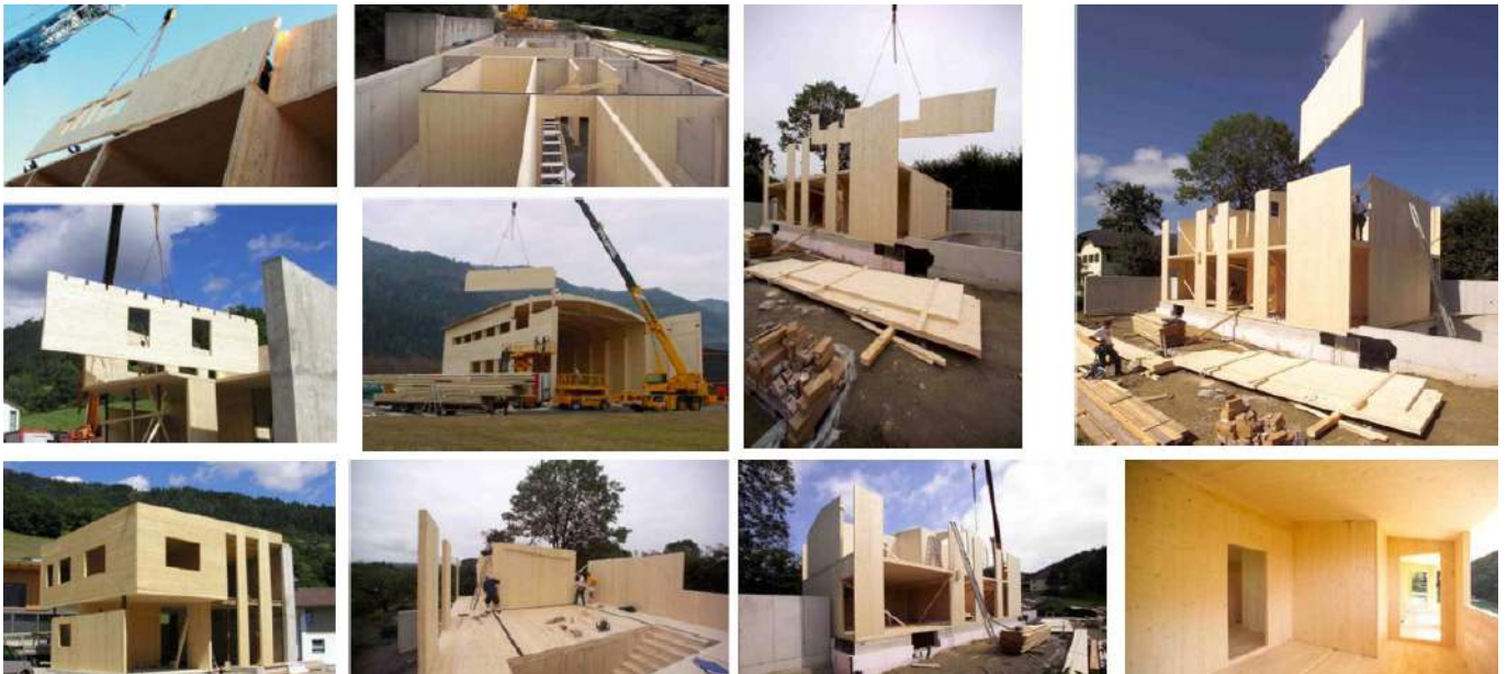
Fig 17. Muros de carga y de fachada mediante paneles de CLT.
