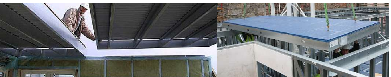
Fig 22. Montaje del elemento de forjado industrializado según el sistema de plataforma (Acces Steel).
