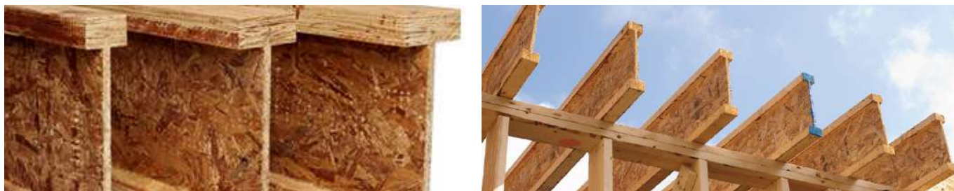
Fig 6. Piezas combinando panel de OSB con madera microlaminada.
