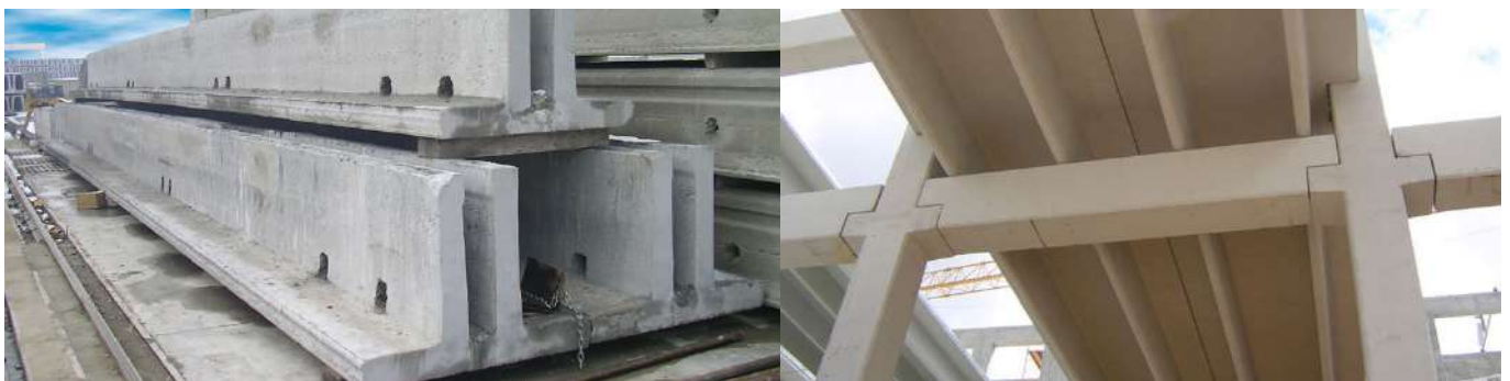
Fig 14. Vigas de doble TT de hormigón prefabricado.
