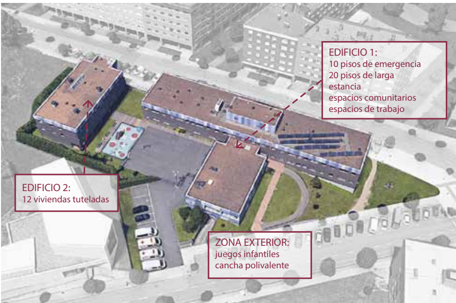
Distribución general de usos en el edificio de La Casa Malva. Fuente: Google Maps.
