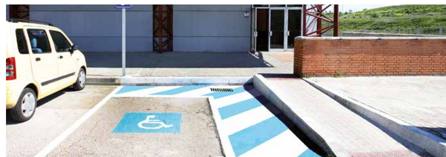
FIG. 01 Ejemplo de buena práctica. Ejemplo de diseño de plaza de aparcamiento accesible.
