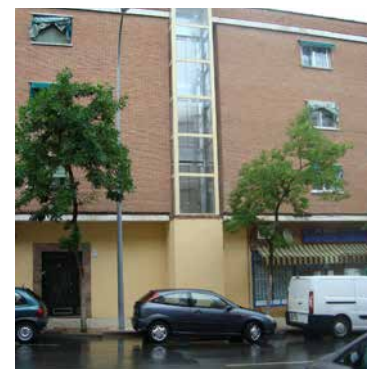
FIG. 01 Ejemplo de buena práctica. Puede apreciarse la instalación del ascensor en fachada, con una buena integración en la misma. Este tipo de actuaciones requiere de coordinación entre el espacio público y privado pues suele necesitar de ocupación de la vía.
