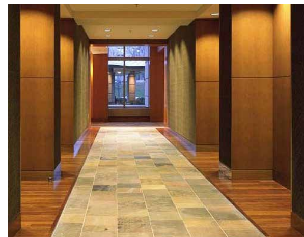
FIG. 05 Ejemplo de buena práctica. Adecuado diseño de suelos, modulación del espacio e iluminación tanto natural como artificial. La disposición de los pilares pediría reforzar el eje de circulación para personas con discapacidad visual mediante encaminamiento, ejecutado parcialmente con el cambio de textura.
