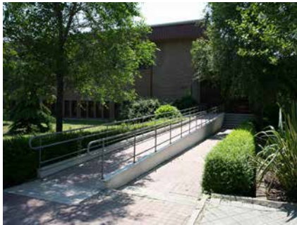
FIG. 01 Ejemplo de buena práctica. La garantía de accesibilidad en los accesos es imprescindible y de utilidad para el conjunto de usuarios. Puede optarse por soluciones sencillas y efectivas.
