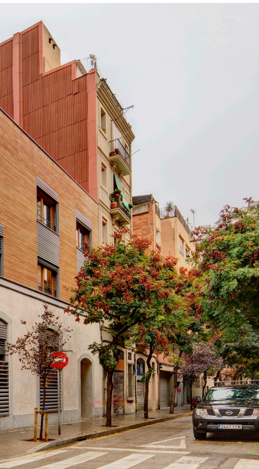
Edificio plurifamiliar viviendas, Barcelona. Certificado VERDE 4 Hojas
