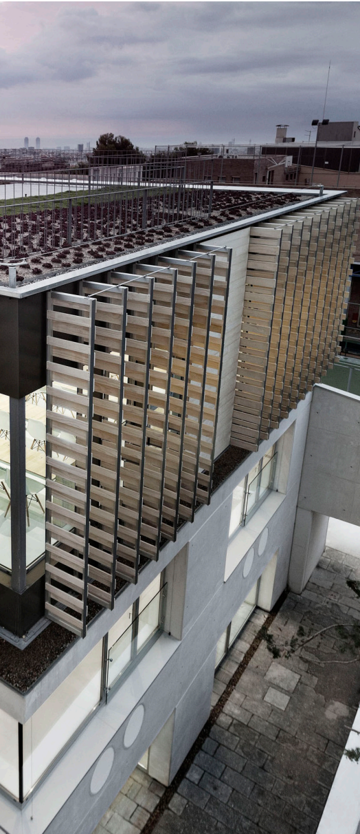
X House School, barcelona Registrado para su certificación con DGNB
