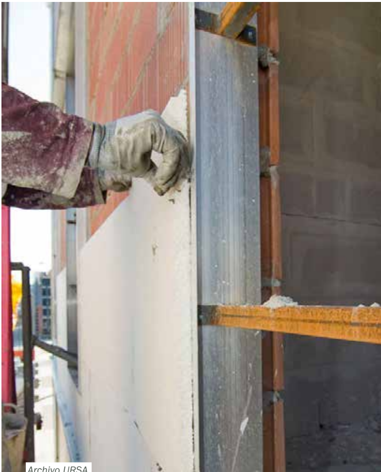
Detalle malla de armadura con esquinero
