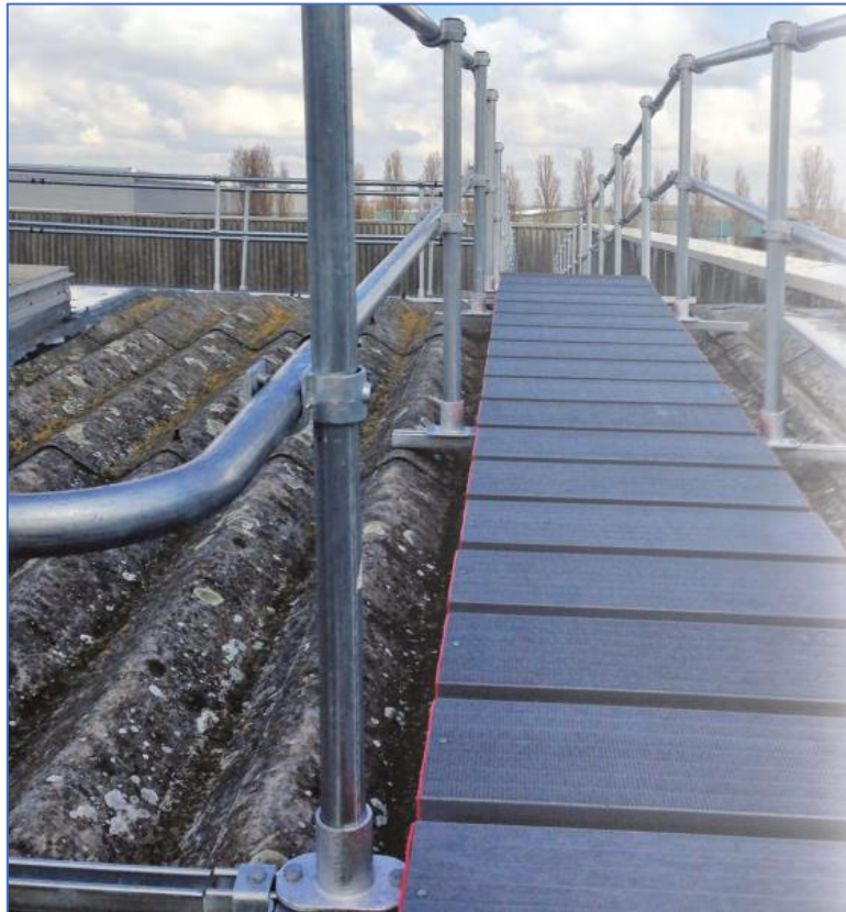
Fotografía 1. Pasarela con barandilla (INSTITUTO NACIONAL DE SEGURIDAD Y SALUD EN EL TRABAJO (España), 2019, pág. 30)
