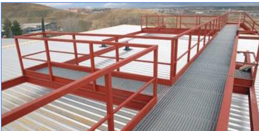
Fotografía 2. Pasarela con barandilla. INVASSAT.
