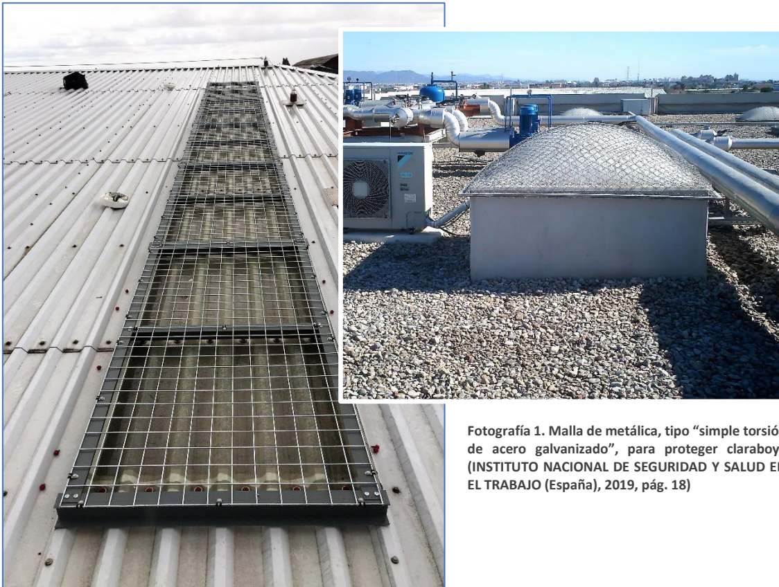
Fotografía 2. Malla metálica, tipo “enrejado de acero galvanizado”, para proteger lucernario (INSTITUTO NACIONAL DE SEGURIDAD Y SALUD EN EL TRABAJO (España), 2019, pág. 25)
