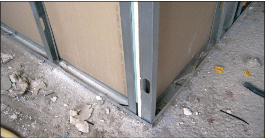
-Imagen H- Vista de la colocación de un montante de arranque y de un montaje fijo en la esquina de un tabique. Se aprecia que entre ambos deben ir las placas de una cara.
