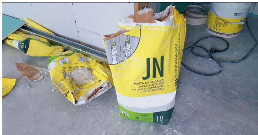
-Imagen D- Es conveniente tener claro en obra qué tipo de pasta utilizamos para cada cometido.
