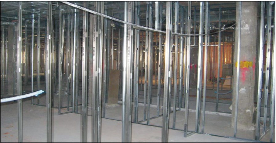
-Imagen G- Vista de toda la subestructura de una tabiquería de vivienda, antes de colocar las placas.
