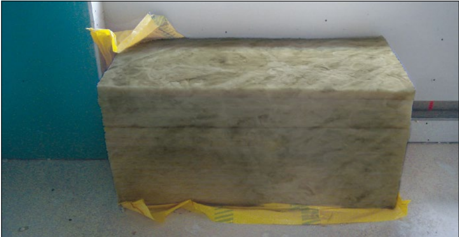
-Imagen C- Distribución en planta de paquetes con paneles de lana de roca.
