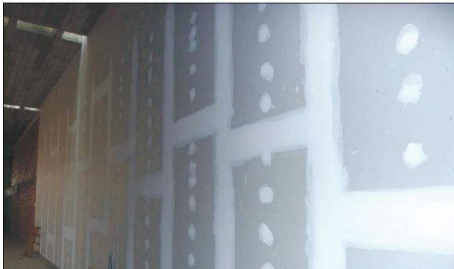
-Imagen P. Vista del paramento de una tabiquería de placas de yeso laminado, en donde se aprecia el plastecido de las cabezas de los tornillos y de la unión entre placas.
