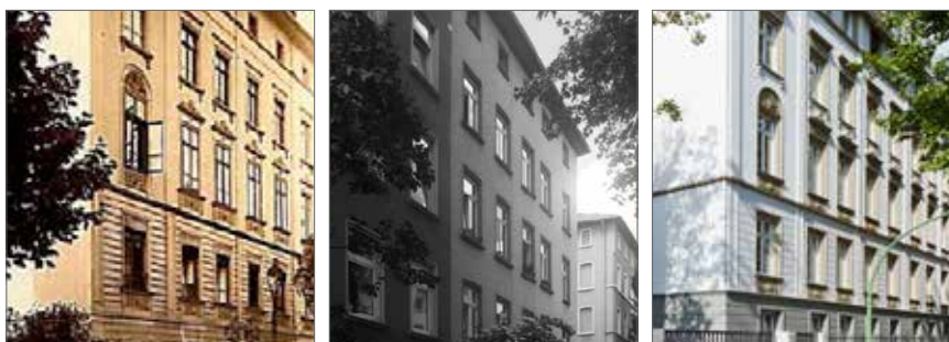
Edificio en Frankfurt, de izquierda a derecha: fachada original, fachada rehabilitada de emergencia con SATE después de la Segunda Guerra Mundial e imagen actual de la fachada en una segunda rehabilitación con SATE, actualizándolo a las normativas de ahorro energético actuales y recuperando su apariencia original.
