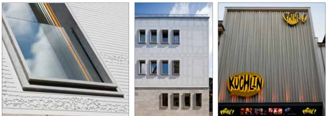
Edificio situado en el casco antiguo de Frankfurt; Cinema Multiplex en Basilea, rehabilitado con SATE usando aislamiento de EPS fresado en fábrica.
