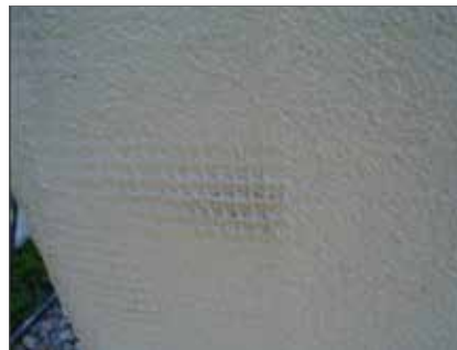
Cubrición insuficiente de la malla de refuerzo.
