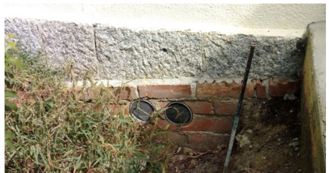
Figura 7 - Aberturas de ventilación finalizadas con rejillas
