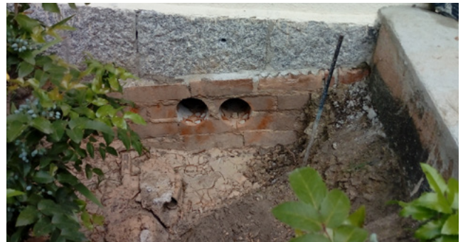
Figura 6 - Perforaciones para una de las nuevas aberturas de ventilación
