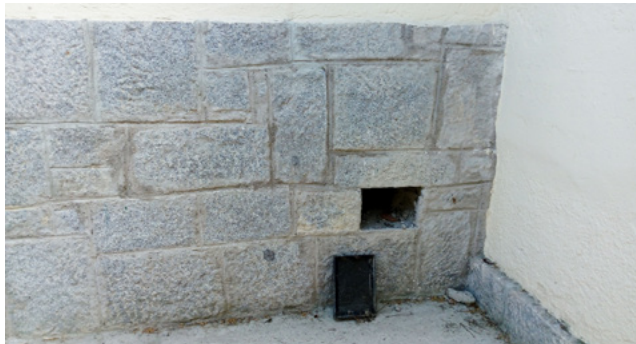
Figura 4 - Abertura de ventilación existente
