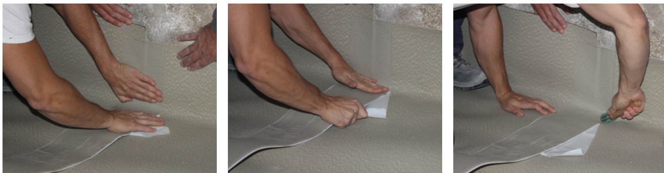
Figura 10 - Sellado del solape entre dos láminas
