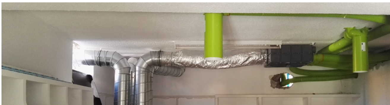
Figura 8 - Red de conductos de impulsión y expulsión
