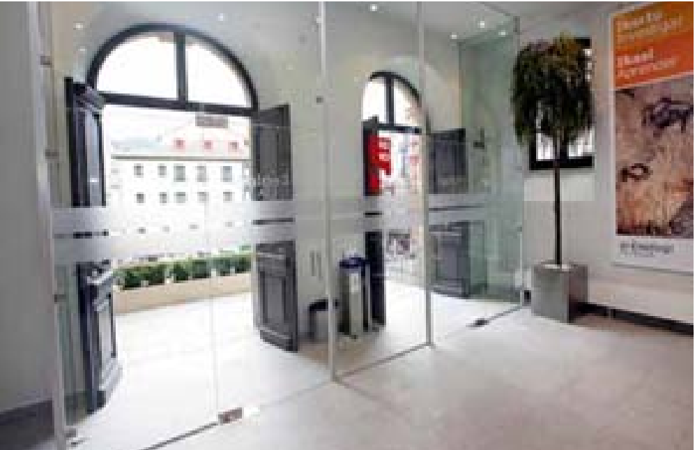
Puerta automática en el interior de un vestíbulo de edificio de uso público, pudiendo mantener el espacio cortavientos.
