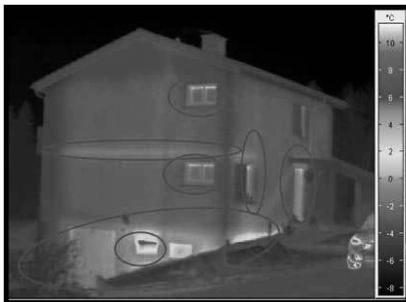
Figura 2. Termografía en invierno de la envolvente de una vivienda unifamiliar.
