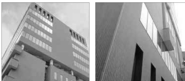
Edificio de FIATC en Barcelona, rehabilitado con SATE acabado con plaquetas cerámicas de ladrillo visto.
