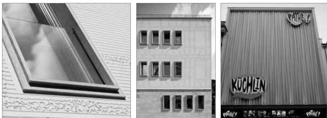
Edificio situado en el casco antiguo de Frankfurt; Cinema Multiplex en Basilea, rehabilitado con SATE usando aislamiento de EPS fresado en fábrica.
