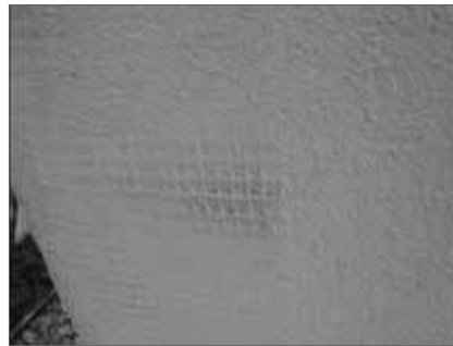
Cubrición insuficiente de la malla de refuerzo.
