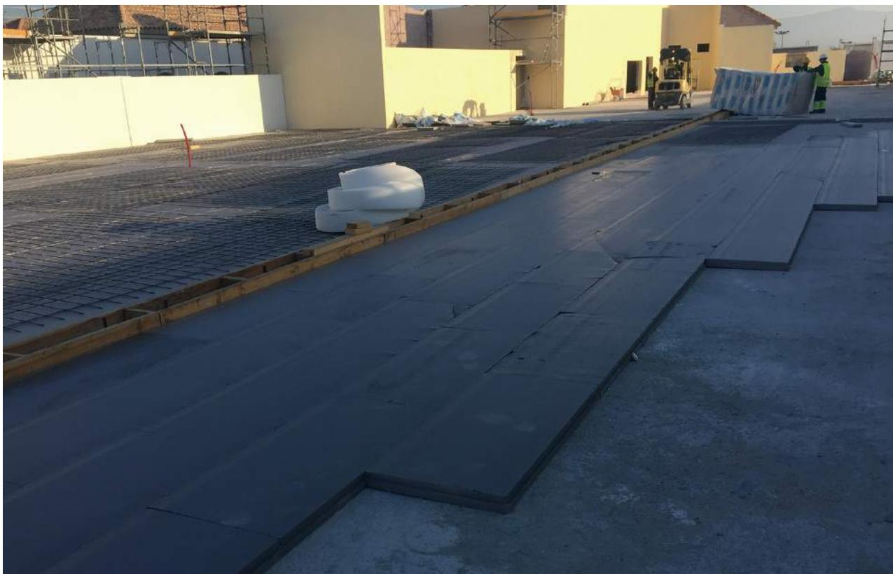
El aislamiento tiene una resistencia a compresión de 500 KPa
