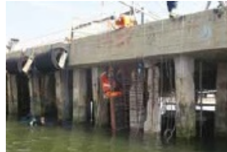
Muelle Ercross, Huelva
