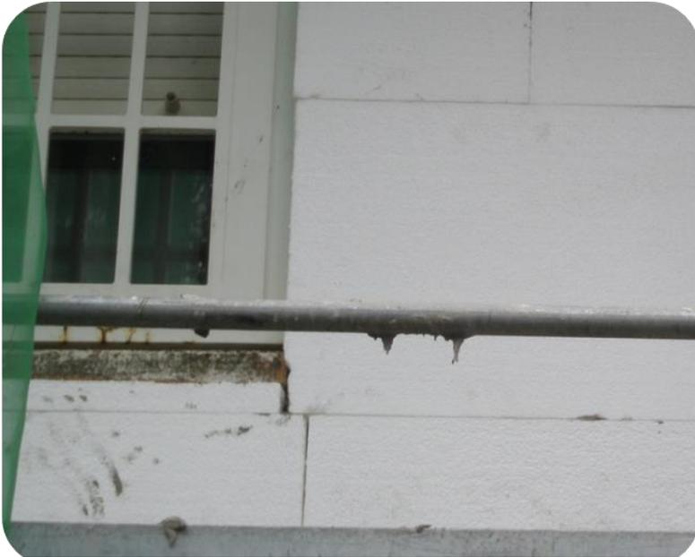
La continuidad de juntas en las placas de aislamiento con respecto a dintel, jambas o alfeizar, puede provocar fisuraciones en el revestimiento. Las fisuraciones más características en estos puntos son a 45°.
