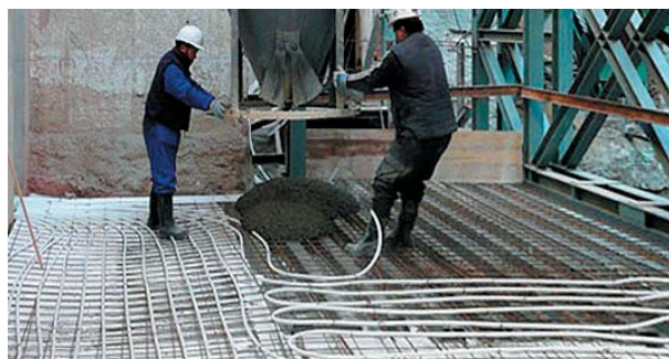
Obra. Hormigonado de losa.
