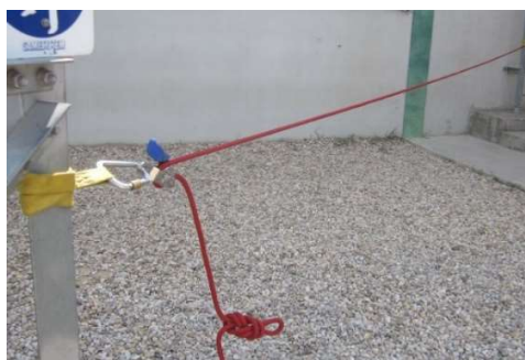
Fig. 7.5.6-1. Línea de anclaje flexible provisional de cuerda.
