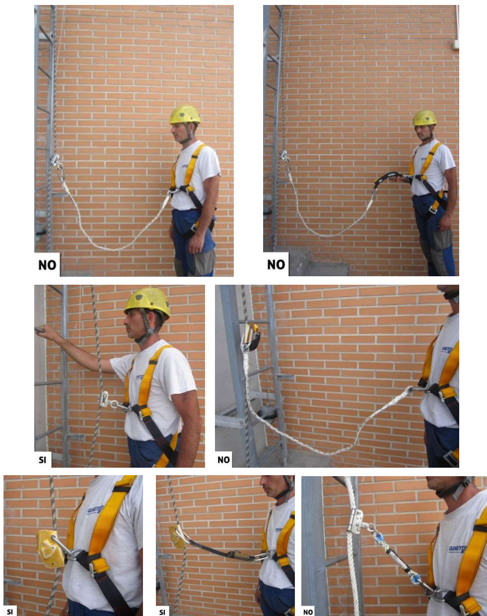
Fig. 6.3.1-3. Diferentes conexiones entre el dispositivo y el arnés autorizadas y no autorizadas por el fabricante de cada dispositivo.
