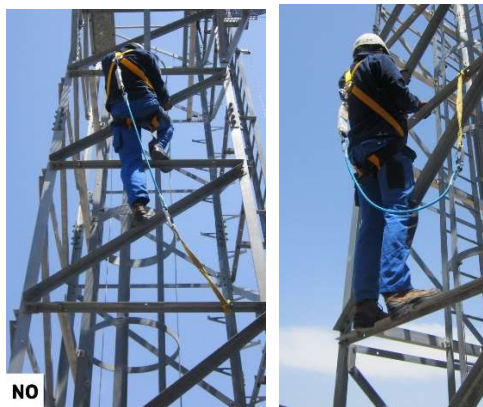
Fig. 5.4.2-3. Utilización de cinta de anclaje que alarga la caída y utilización correcta de cinta de anclaje (no alarga la caída).
