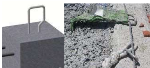
Fig. 7.3.3-4. Anclajes fijados de manera pasiva.
