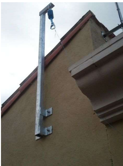
Fig. 7.3.4-19. Soporte anclado en fábrica de ladrillo.
