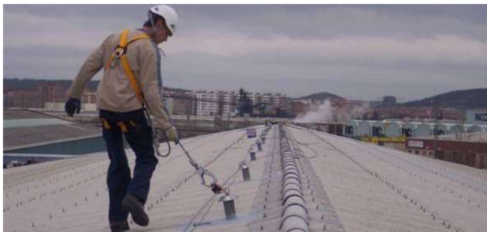
Fig. 7.5.1-1. Ejemplo de utilización de línea de anclaje flexible horizontal.
