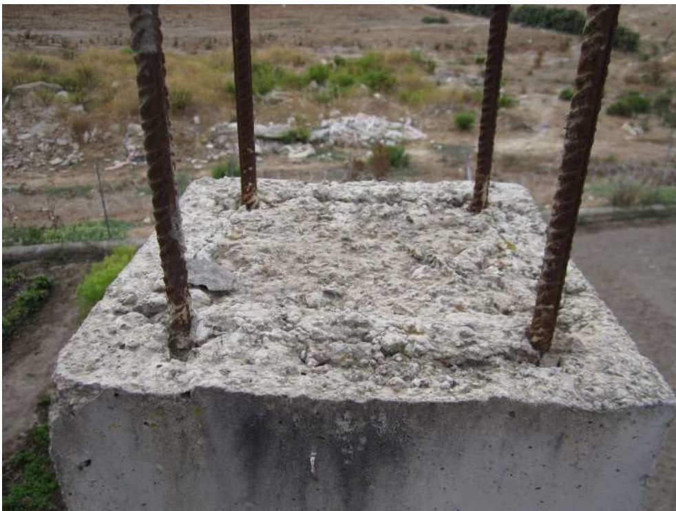
Fig. 8.4-1. Detalle de esperas del pilar.
