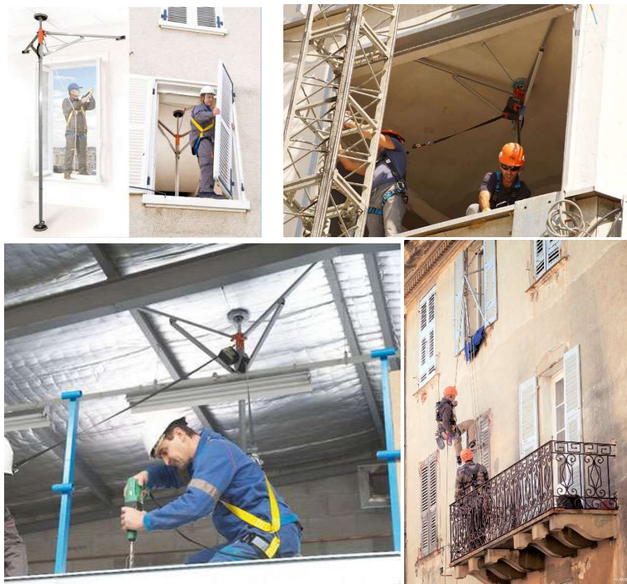
Fig. 7.4.6-5. Ejemplos de utilización de sistemas de anclajes móviles.
