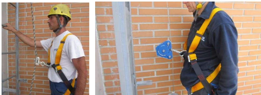
Fig. 6.3.1-1. Línea de anclaje de cuerda y de cable.
