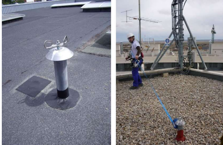
Fig. 6.4.2-2. Punto de anclaje fijo en cubierta al que se puede unir un sistema de conexión anticaídas y ejemplo de uso.
