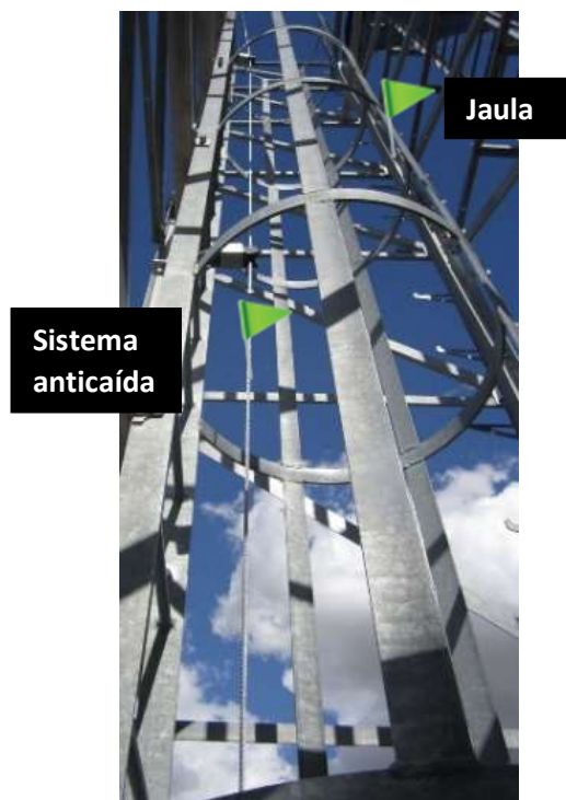
Fig. 6.1-3. Escalera protegida con aros circundantes y sistema anticaídas.
