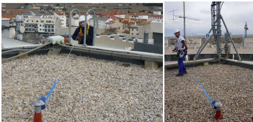
Fig. 6.4.4-18. Uso de un punto de anclaje con retráctil en una cubierta plana.
