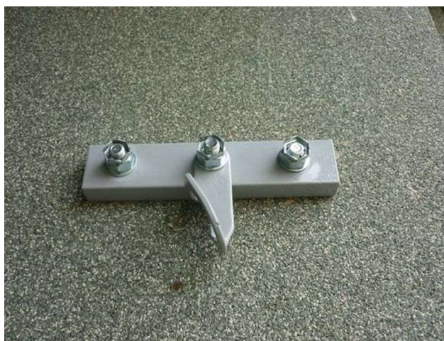
Fig. 7.3.3-5. Reparto de cargas entre dos elementos de fijación (el del centro sólo fija la plaqueta al perfil).
