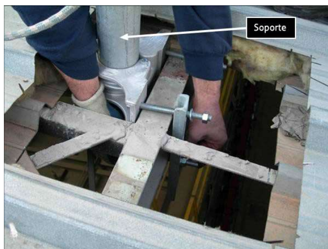
Fig. 7.3.-17. Embridado de un soporte a la estructura interior de una cubierta de chapa.
