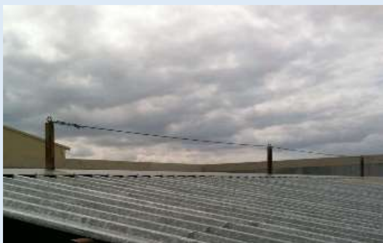
Fig. 7.5.6-4. Línea de anclaje dudosa.
