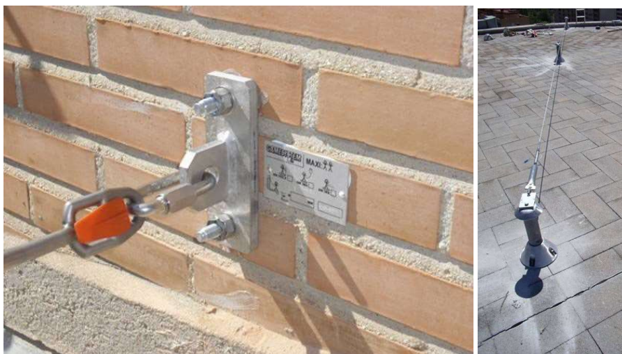
Fig. 7.5.4-5. Dos tipos de soportes fijados con anclajes activos.
