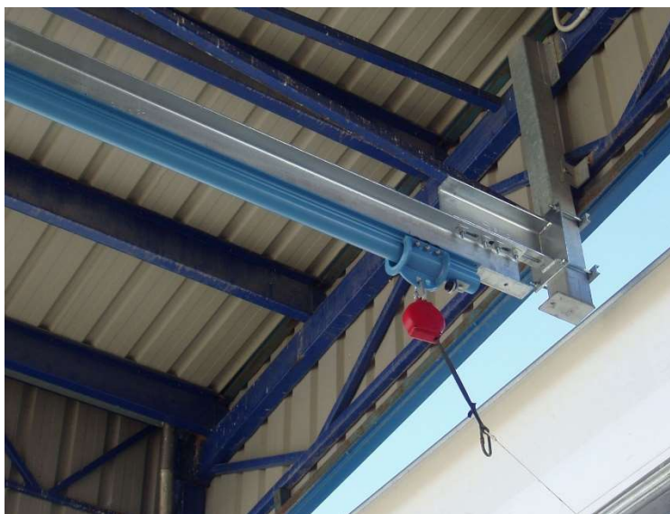
Fig. 7.6.1-1. Línea de anclaje rígida con retráctil lista para ser utilizada.
