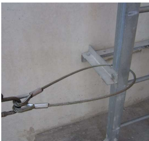
Fig. 7.4.2-2. Cinta de anclaje metálica.
