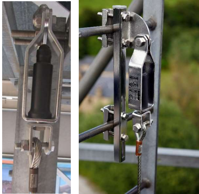
Fig. 6.2.1-3. Absorbedor en soporte superior del cable.
