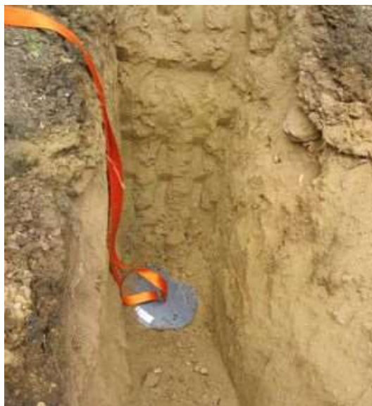
Fig. 7.3.4-9. Anclaje de tierra.
