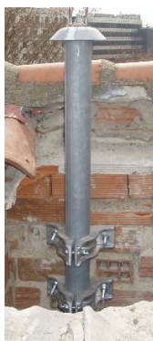
Fig. 7.3.4-18. Soporte anclado en fábrica de ladrillo.
