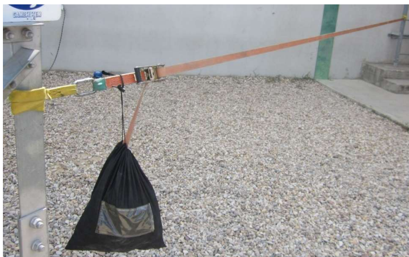
Fig. 7.5.6-2. Líneas de anclaje flexible provisional de cable.
