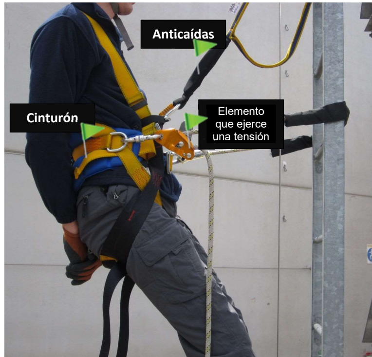
Fig. 4.2.1-1. Utilización de un cinturón para trabajar en sujeción.
