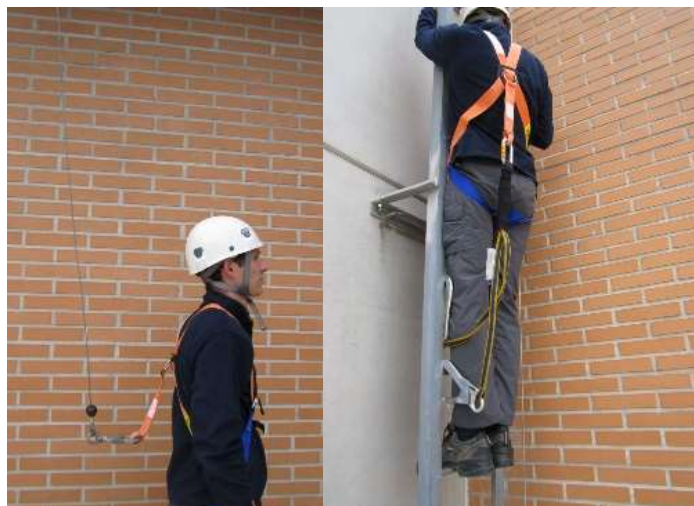
Fig. 4.1.8-3. Cinta extensora mal utilizada por aumentar la caída.
