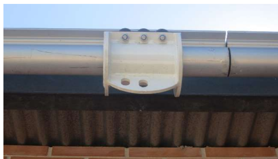
Fig. 7.6.1-6. Carro diseñado para sistema de suspensión y sistema anticaída.
