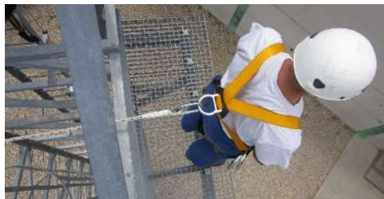
Fig. 5.2.1-7. Utilización correcta de un equipo de amarre para retención.
