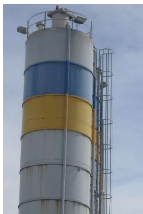
Fig. 6.1-1. Escalera para acceso a silo protegida exclusivamente con aros circundantes o jaula.
