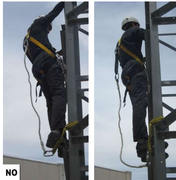
Fig. 5.2.1-2. Utilización peligrosa del equipo de amarre con posibilidad de caída y sin absorbedor. A la derecha, utilización correcta al añadir un absorbedor compatible.
