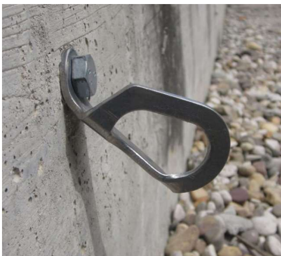
Fig. 7.3.4-2. Plaqueta diseñada para doblarse ante una solicitación axial.
