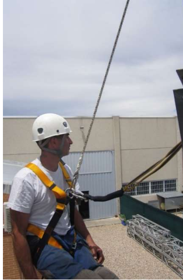
Fig. 5.2.1-6. Utilización de un equipo de amarre para sujeción.
