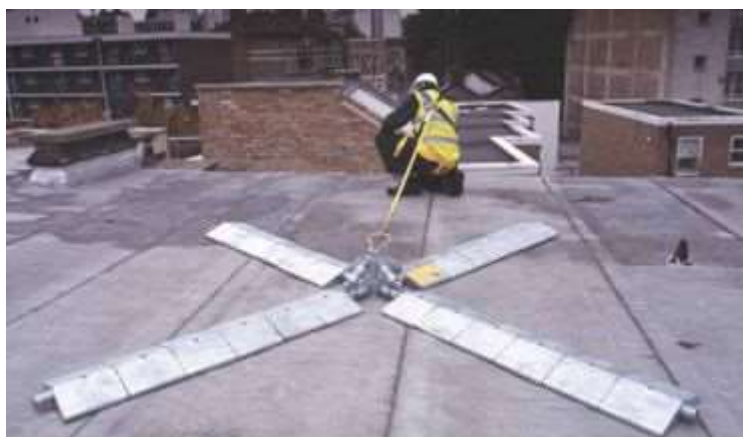
Fig. 7.7.2-1. Configuración de un peso muerto.
