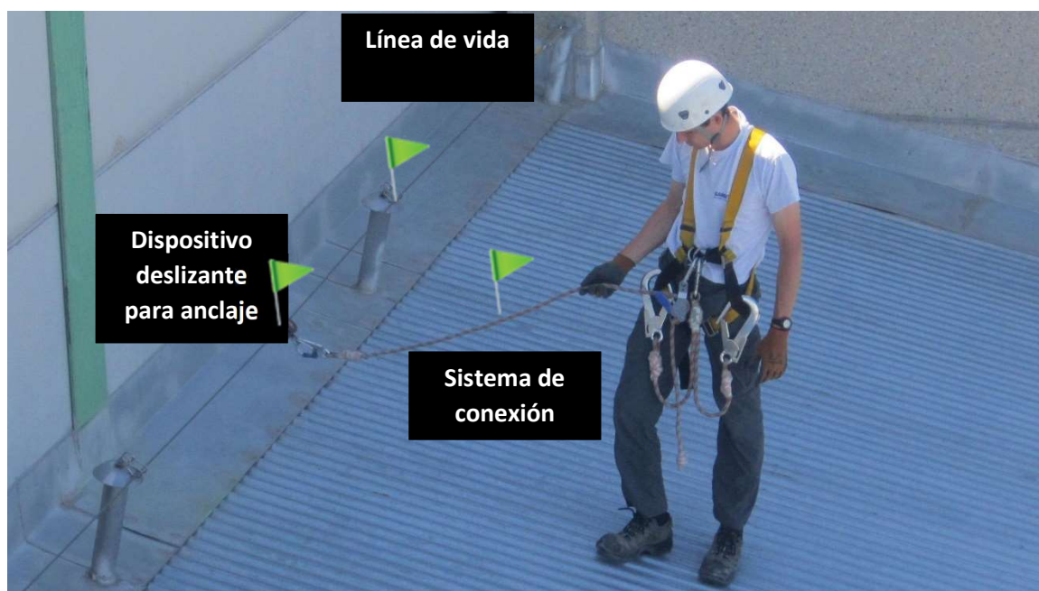
Fig. 6.4.2-1. Utilización de línea de anclaje flexible horizontal.
