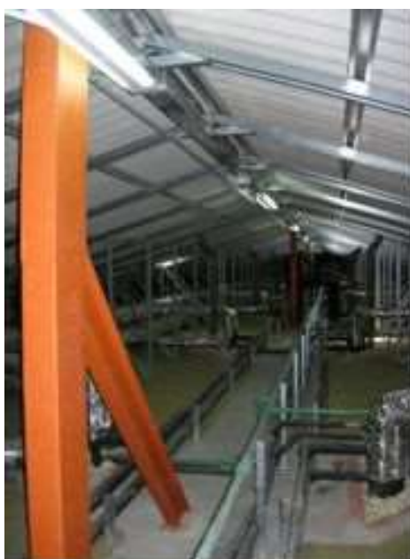
Fig. 7.3.4-20. Soporte anclado en forjado por debajo de la cubierta.
