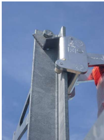
Fig. 6.2.1-4. Detalle de tope en la parte superior de un raíl.
