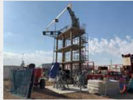
02 Estructura de simulación en las instalaciones de Acciona para la verificación final del funcionamiento.
