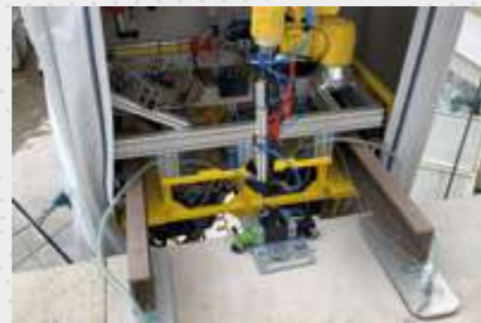
05 End-effector instalando los anclajes del muro cortina.
