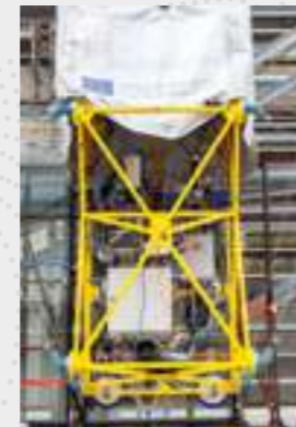
03 Detalle de la estructura en la que se alojan los sistemas de manipulación para la colocación de los anclajes y para el movimiento del robot.
