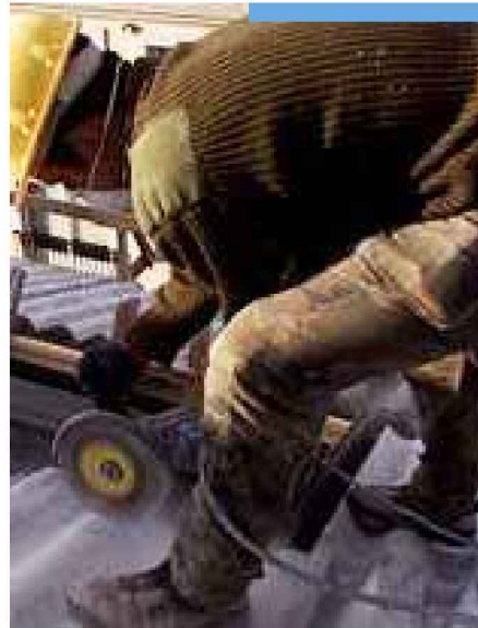
Derecha Corte con radial Izquierda Retirada de amianto
