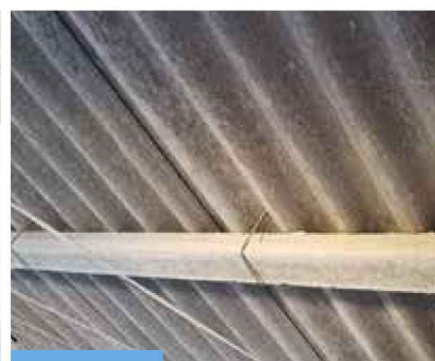
Fibrocemento en buen estado. Material no friable.
