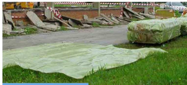
Colocación plástico en la zona de acopio
