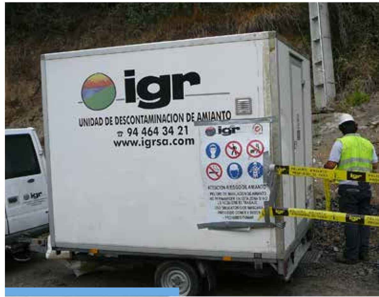
Acondicionamiento de la zona de trabajo previamente al comienzo de los mismos
