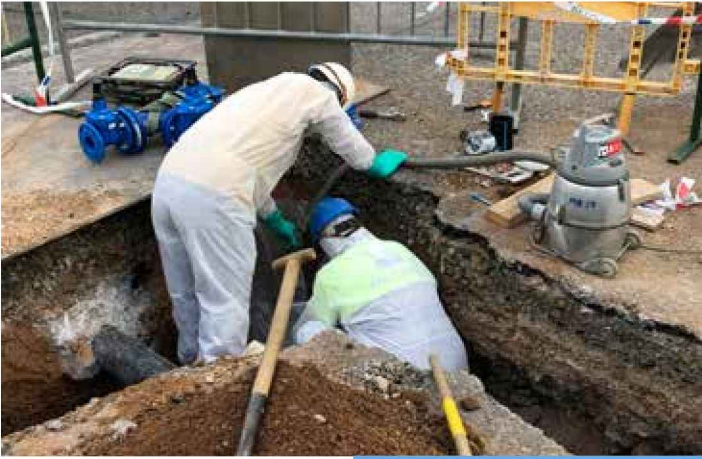
Uso de aspirador en trabajos con MCA
