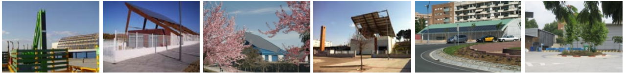
Figura 2. Centrales de recogida con placas fotovoltaicas, en Sevilla, Aranjuez, Alcobendas, Reus, Can Llong.
