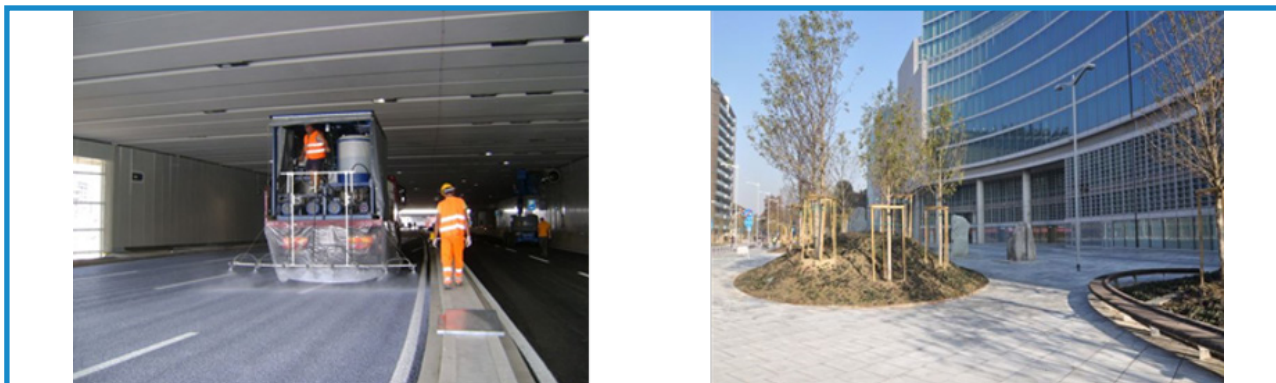
Figura 19: Proceso de pulverización de spray fotocatalítico sobre pavimento existente (Izda.). Detalle de acabado de extendido de spray fotocatalítico en aceras en Milán (Dcha.). Fuente: Impresa Bacchi
