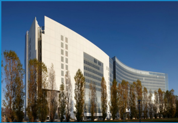
Figura 25: Ejemplo de aplicación de mortero fotocatalítico en Vodafone Village. Milán. Italia. Fuente: FYM-Heidelberg Cement Group
