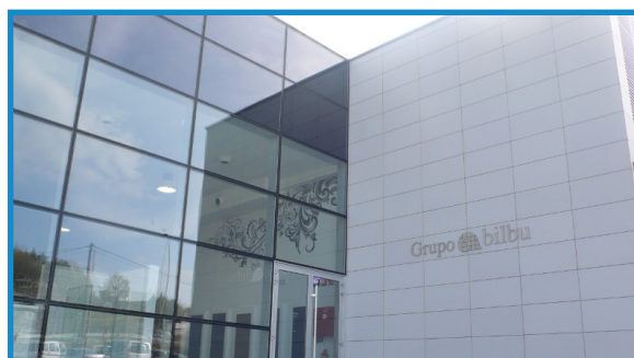
Figura 24: Ejemplo de acabado de revestimiento de fachadas con materiales cerámicos fotocatalíticos en Bilbao. Fuente: Ceracasa
