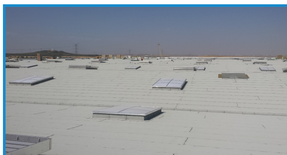
Figura 69: Cubiertas impermeabilizantes fotocatalíticas en centro logístico de Amazon. Getafe (Madrid). Fuente: BMI
