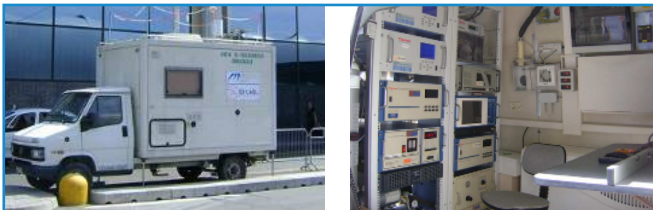
Figura 62: Estación móvil para la medida instalada en el Aeropuerto de Malpensa (Milán). Fuente: Impresa Bacchi.
