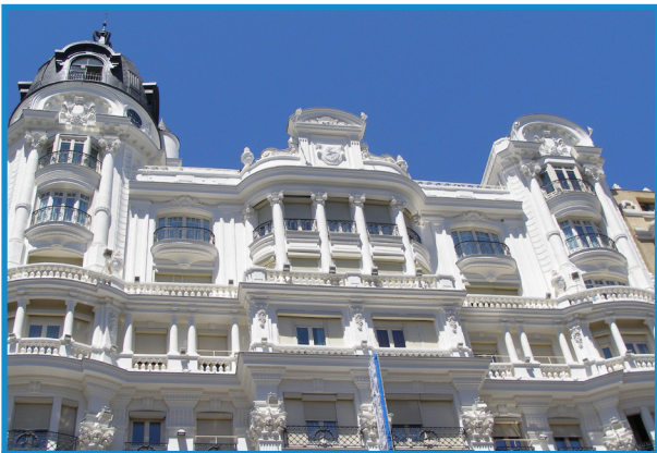
Figura 31: Fachada con pintura fotocatalítica en el Hotel Atlántico de la C/ Gran Vía de Madrid. Fuente: KEIM
