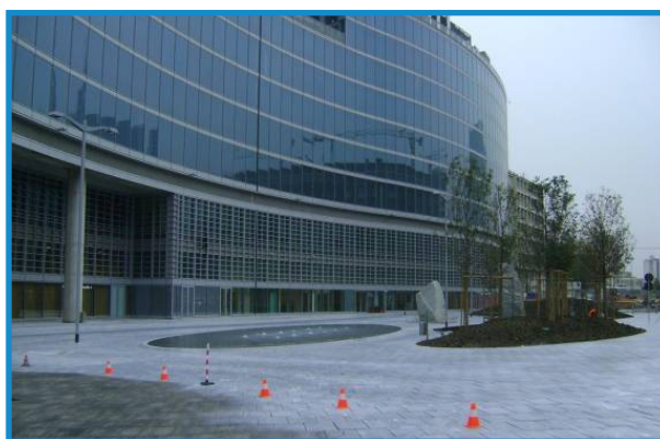
Figura 63: Aplicación de micro-emulsión fotocatalítica en las aceras del Edificio de la Región Lombardía (Milán). Fuente: Impresa Bacchi.
