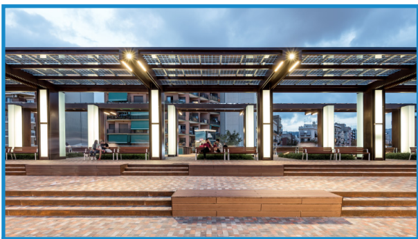
Figura 22: Aplicación de loseta fotocatalítica en High Line Sants, Barcelona. Fuente: Breinco
