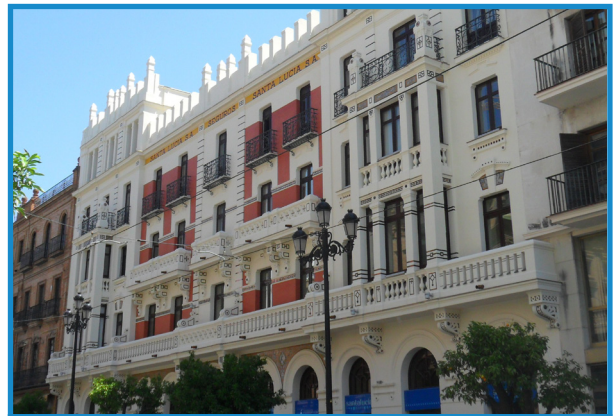
Figura 32: Fachada con pintura fotocatalítica en el Edificio Santa Lucía. Sevilla (España). Fuente: KEIM
