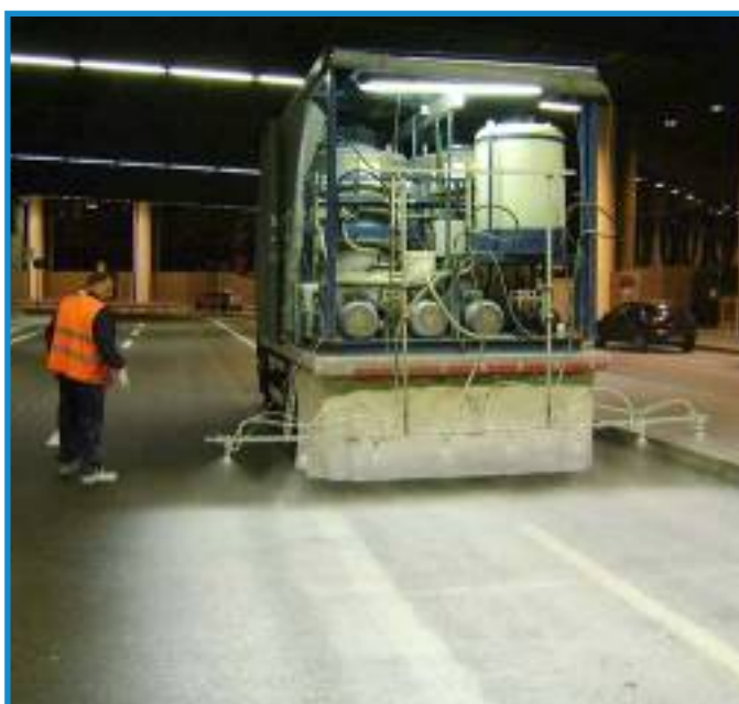
Figura 61: Aplicación de micro-emulsión fotocatalítica, mediante el prototipo patentado por "Impresa Bacchi", en la Terminal 1 del Aeropuerto de Malpensa (Milán)
