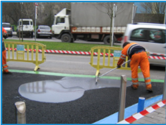
Figura 12: Proceso de extendido y percolación de lechada fotocatalítica sobre un pavimento drenante. Fuente: Eurovía
