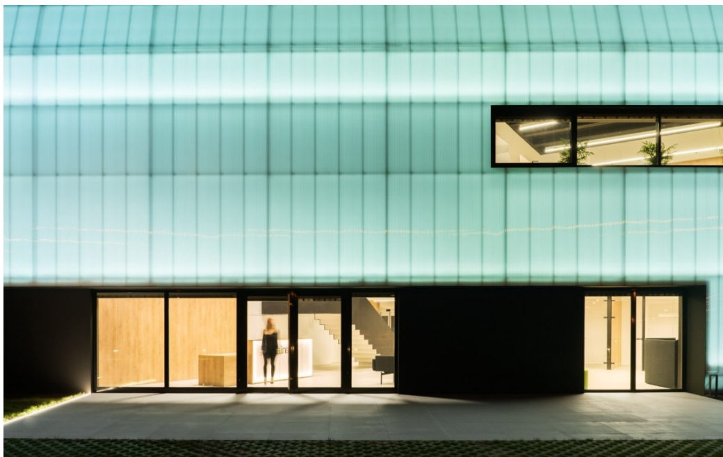
Figura 8. Fachada Ventilada SATE acabada con policarbonato retroiluminada. Zona de acceso principal al edificio.
