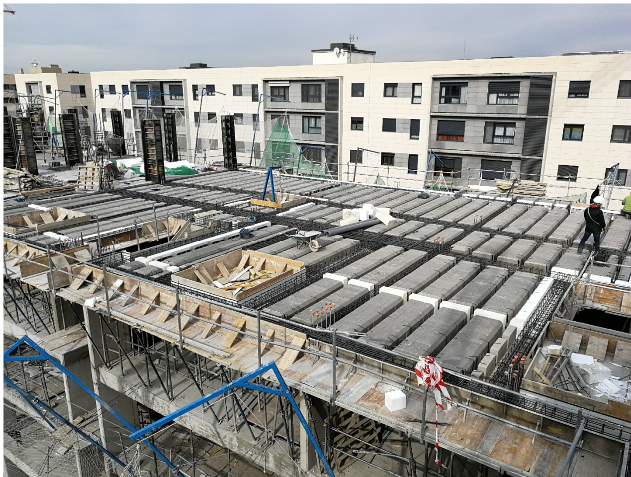
Figura 3. Piezas de alta resistencia térmica en la ejecución de forjado unidireccional de hormigón in situ.
