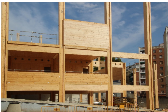
Figura 11. Montaje de la estructura de madera contralaminada.
