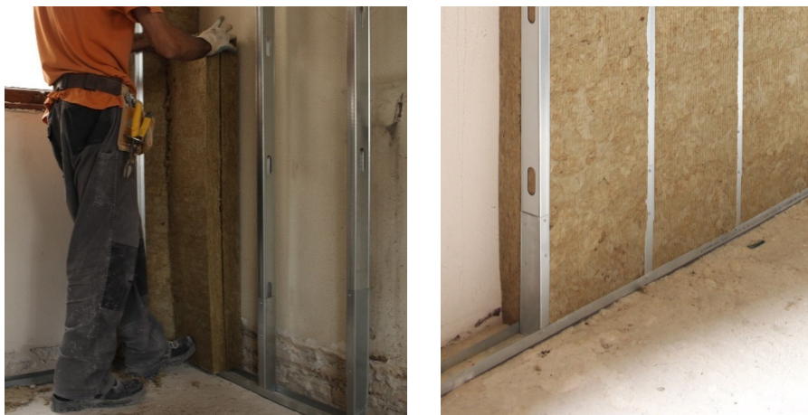
Figura 2. Proceso de colocación del panel RockDry en el primer trasdosado.
