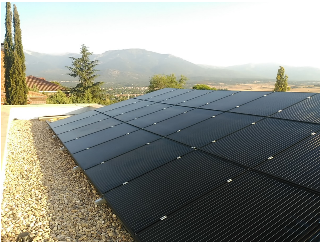
Figura 4. Instalación fotovoltaica en cubierta.
