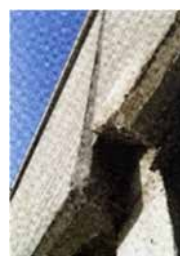
Figura 5. Desprendimiento paneles de fachada.
