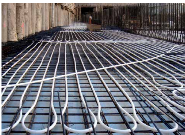
Figura 1. Posicionamiento de los tubos de activación sobre la armadura de un forjado (Fuente: IDOM).
