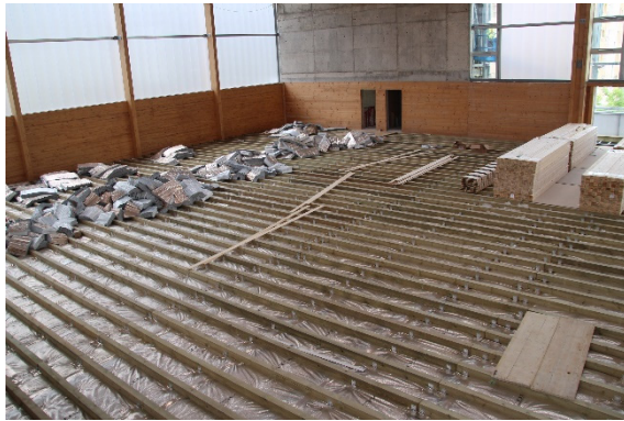
Figura 13. Colocación aislamiento térmico en el forjado entre piscina y pista.
