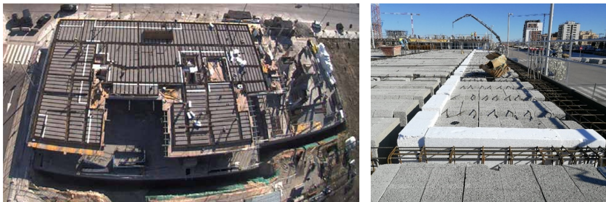
Figura 5. Tratamiento de puentes térmicos de forjados.
