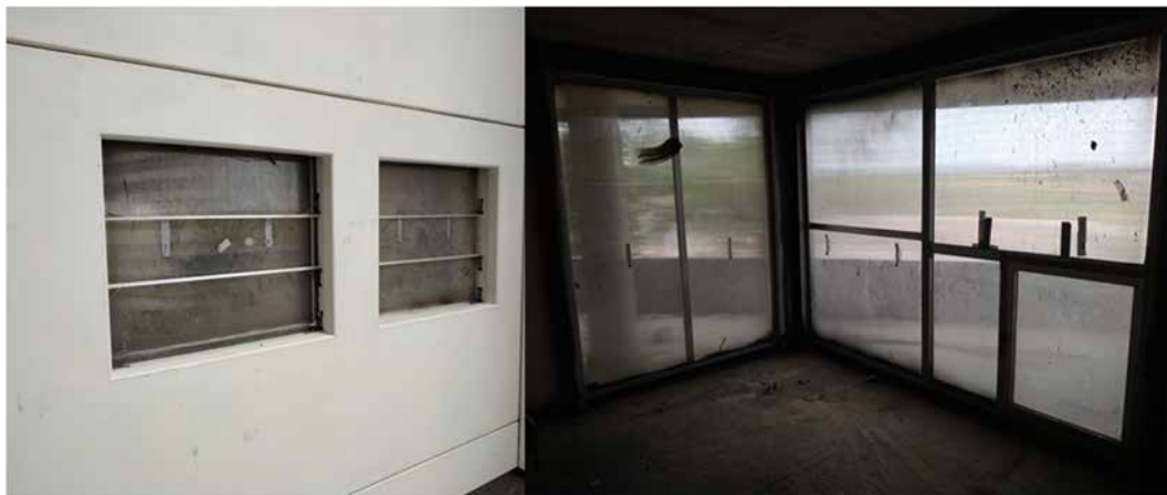
Figura 2. Ejemplo de sellado temporal de los huecos de las carpinterías con policarbonatos.
