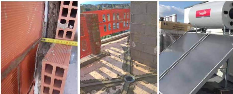
Figura 2. Detalle de montaje de aislamientos – visita a obra.
