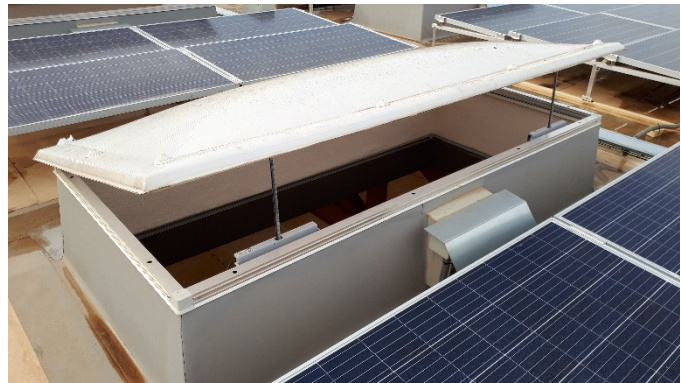
Figura 10. Lucernarios motorizados con ventiladores de apoyo.
