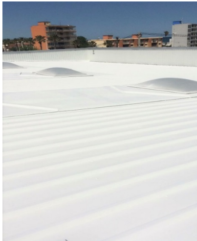
Figuras 3 y 4. Imagen de cubierta metálica tratada y medición con cámara termográfica, realizada a las 12h. Reducción de temperatura superficial de 21,8 grados, respecto a una zona de la cubierta no tratada.
