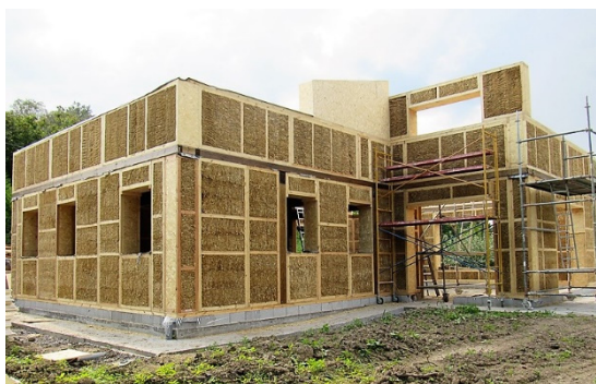
Figura 3. Montaje Paneles Industrializados Ecopaja.
