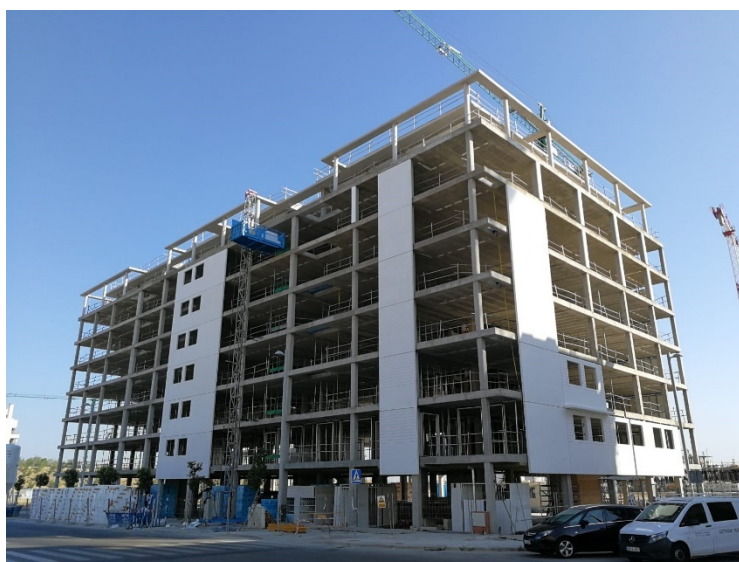
Figura 6. Instalación de fachadas de GRC.
