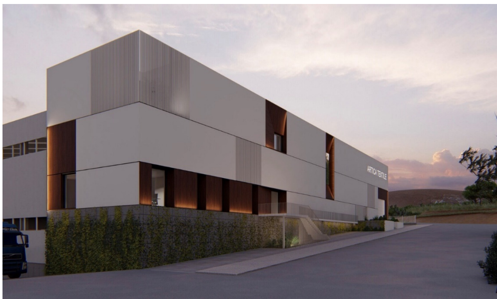
Figura 1. Vista general. Imagen exterior. Fachada tipo SATE de lana de roca con prefijado en húmedo y fijación mecánica con rotura de puente térmico, sobre fábrica de termoarcilla acabada con revoco de cal (blanco) y madera sobre malla de fibra de vidrio.
