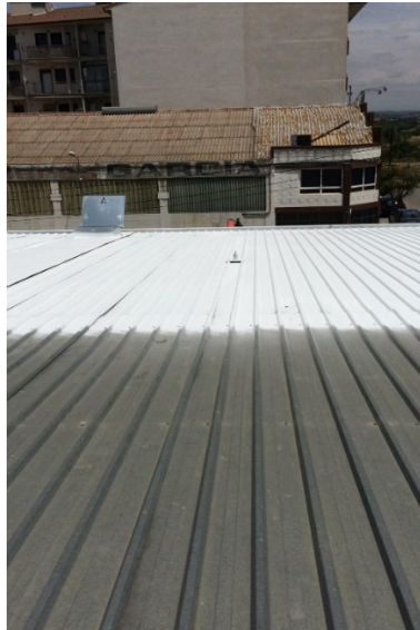
Figuras 1 y 2. Cubierta metálica tratada con pintura termo-reflectante Thermodry. Imagen captada a las 16h. Diferencia de temperatura superficial entre zona con pintura Thermodry y zona sin tratar de 27 grados.
