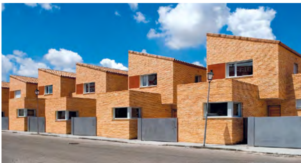
Viviendas en Sonseca (Toledo), Arq. Jorge Palomo Carmona
