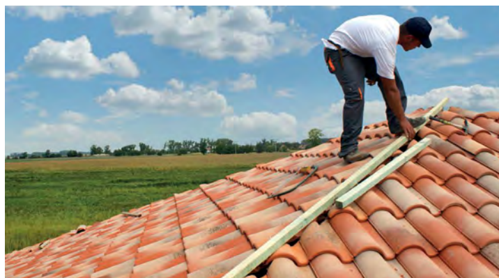
Figura 76. Rastrel de limatesa sobre soporte
