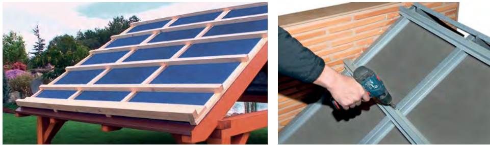
Figura 68. Instalación de doble rastrel (listón y rastrel) de madera y metal
