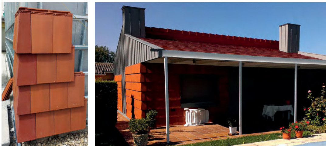
Figura 39. Fachada ventilada de teja cerámica
