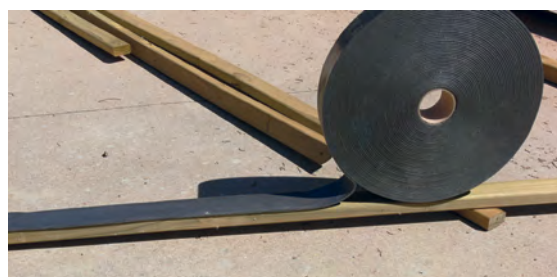
Figura 47. Colocación de cinta adhesiva en listones
