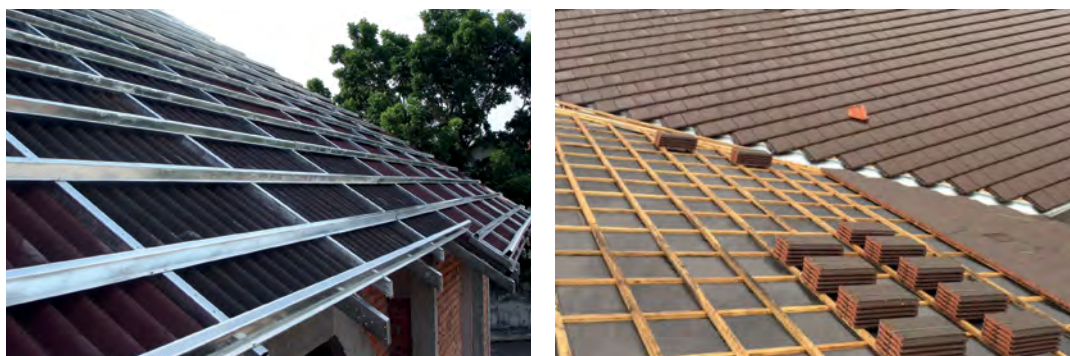
Figura 45. Tipos de rastreles de diferentes materiales
