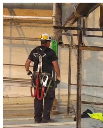
Montador de andamios con arnés.
