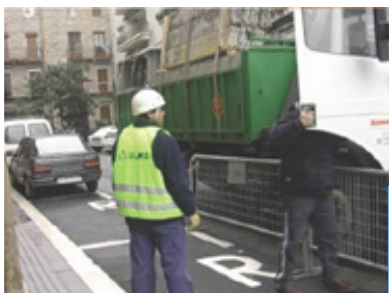
Vallado de zonas de descarga y acopio de material.
