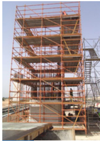
Escalera de servicio adosada a un andamio.
