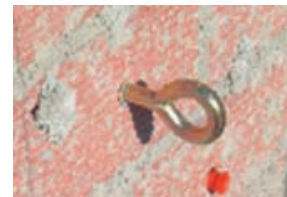
Cáncamo roscado sobre el taco dispuesto en la fachada
