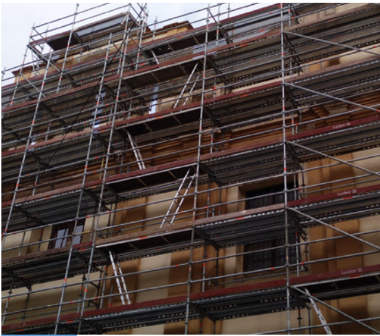
Escalera interna en un andamio.
