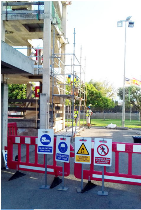
Zona de montaje de un andamio acotada y señalizada.
