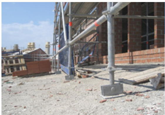
Husillo con placa base articulada en un terreno inclinado.
