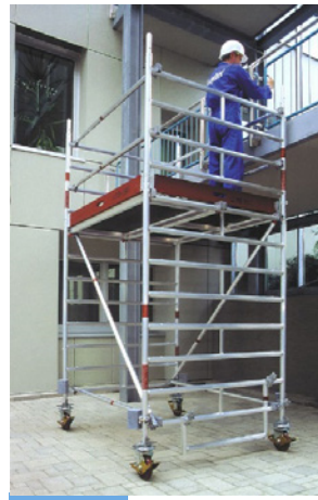
Foto izquierda Torre de trabajo móvil con lastre para aumentar el peso propio del equipo y asegurar su estabilidad frente al vuelco. Foto derecha Torre móvil con estabilizador para garantizar su estabilidad.
