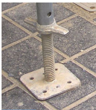
Placa base rectangular con husillo. Las bases de apoyo tendrán un espesor mínimo igual a 6 mm y un área mínima de 150 cm 2 .
