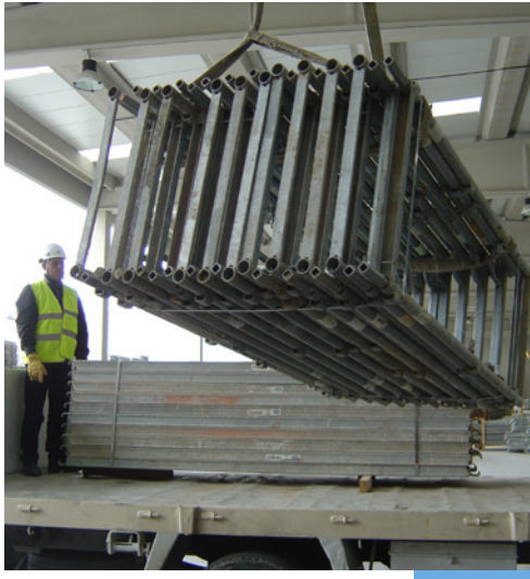
Descarga de materiales desde un camión.
