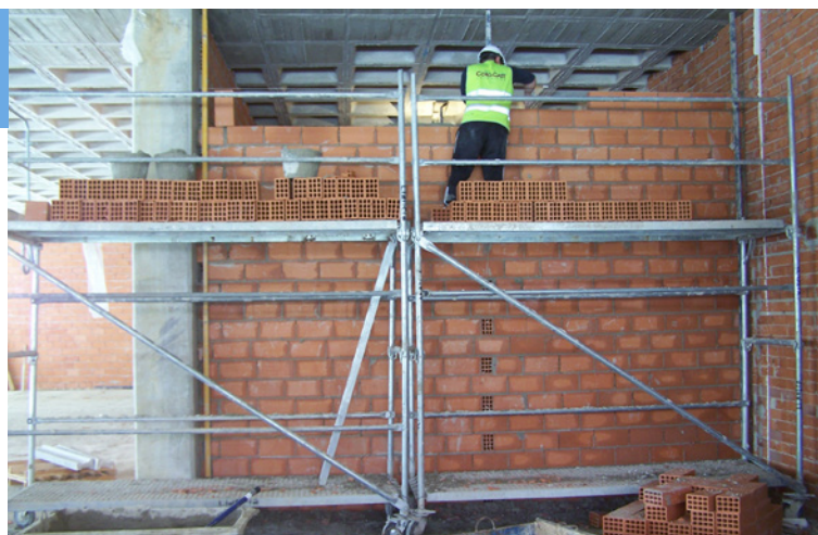
Plataforma de trabajo con sobrecarga.
