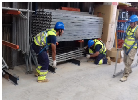
Foto superior Elevación y colocación manual de elementos del andamio.
