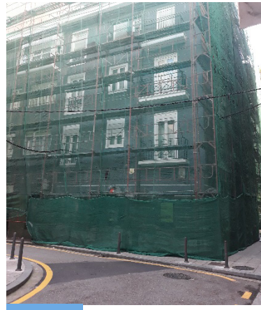
Andamio cubierto con red.
