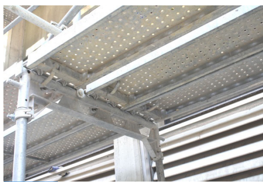
Correcto posicionamiento de las garras de los diferentes módulos de plataformas de trabajo sobre el travesaño horizontal de un marco de andamio tubular.
