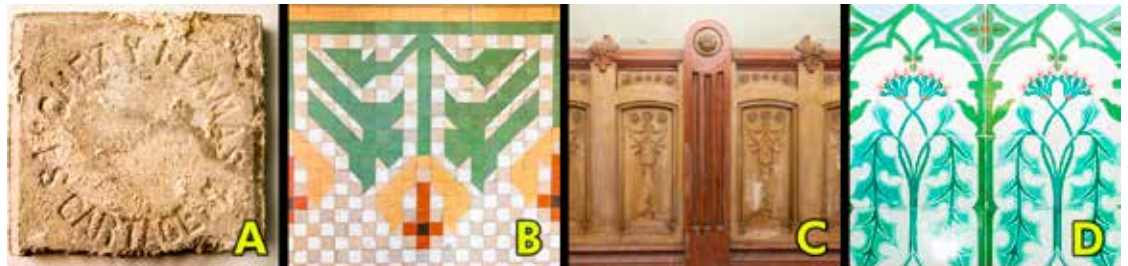
Figura 1. A. Baldosa hidráulica donde se aprecia el fabricante. B. Mosaico Nolla de vivienda modernista de Cartagena. C. Piedra Artificial coloreada para dejar vista. D. Zócalo de azulejo de una vivienda modernista de Cartagena, modelo valenciano de la fábrica de Eloy Domínguez.
