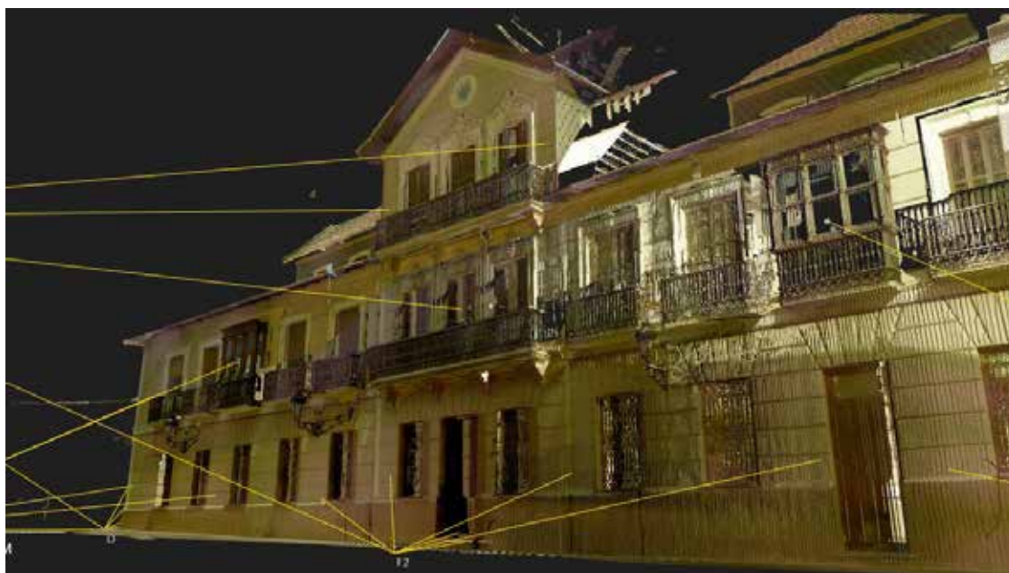
Figura 7. Escaneado realizado de la fachada D de la Casa Rubio. Elaboración propia.
