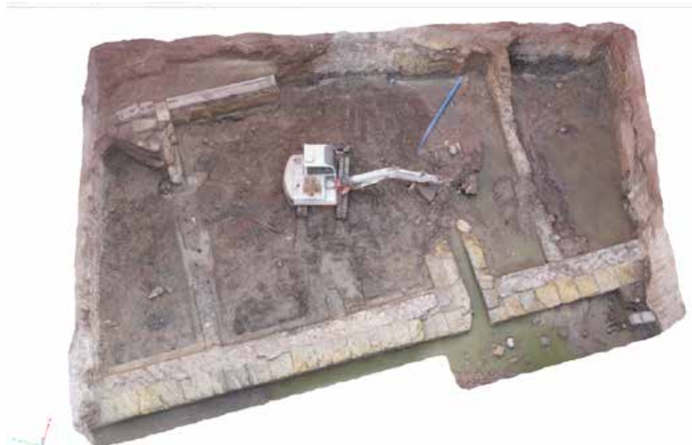
Fig. 3. Vista cenital de la estructura al completo.
