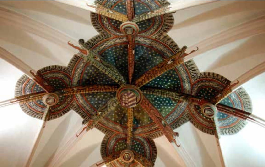
Figura 5: Bóveda de albañilería tardogótica decorada con dragones, tendida sobre el coro alto de la antigua iglesia de Santa Clara La Real (Murcia).
