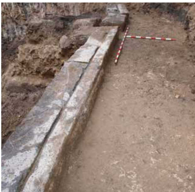
Fig. 4. Coronación del muro interior.
