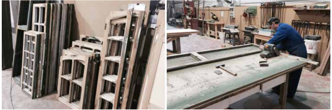
Fig. 2. Trabajos de restauración de ventanas y cierres de madera originales.
