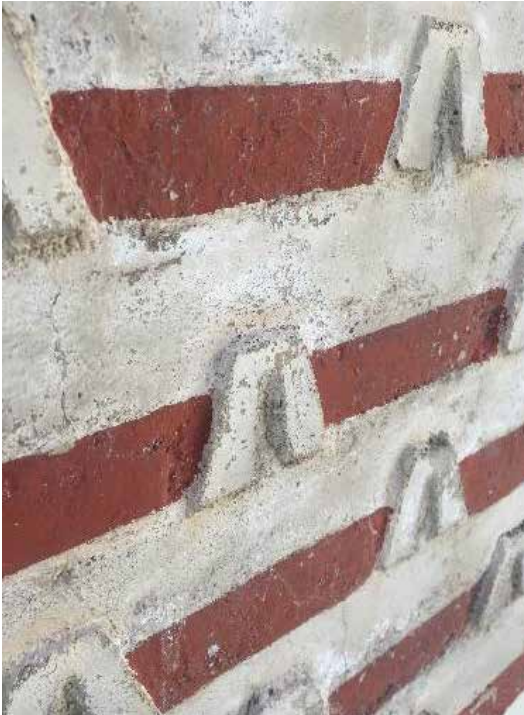
Fig. 4. Llagueado en “v” invertida colocado en la fachada
