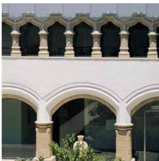
Figura 4: Galería de yeso con perfil mixtilíneo (s. XV) que remata el pórtico norte del claustro de Santa Clara La Real (Murcia).
