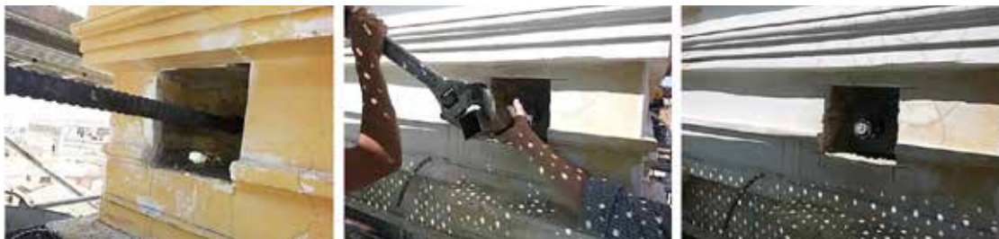
Figura 7. Proceso de reparación del campanario mediante la incorporación de barras de acero tipo GEWI.
