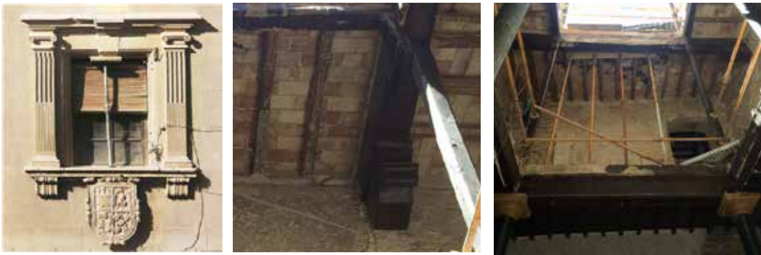
Figura 5. Detalles de la Casa Irurita en Lorca. A la izquierda, ventana sobre la portada con las ménsulas bajo las dos pilastras jónicas. En el centro, uno de los canes que sustentan las grandes vigas del salón principal, donde se reproduce el dibujo de dichas ménsulas. A la derecha, el apoyo de un brochal sobre la viga, con una pieza claramente diferente y sin ninguna coincidencia con el resto del lenguaje renacentista de las armaduras
