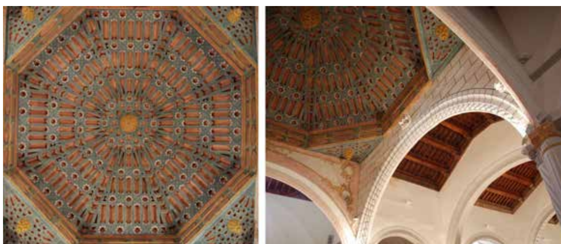
Fig. 3. Vista general de la armadura ochavada del presbiterio de la Iglesia de Cehegín (izqda.), y detalle de la transición del presbiterio a la nave central con los arcos fajones y las carpinterías (dcha).
