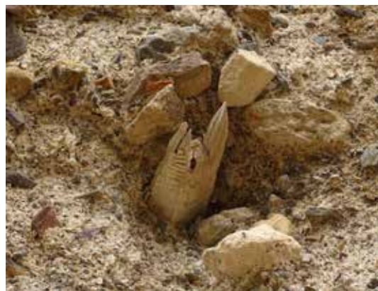
Fig. 3. Aguja original de madera detectada en una de las torres.
