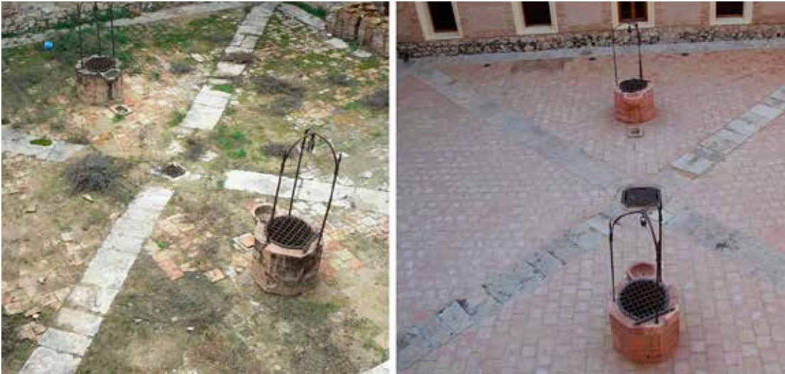
Figura 6. El patio conventual antes y después de la restauración.
