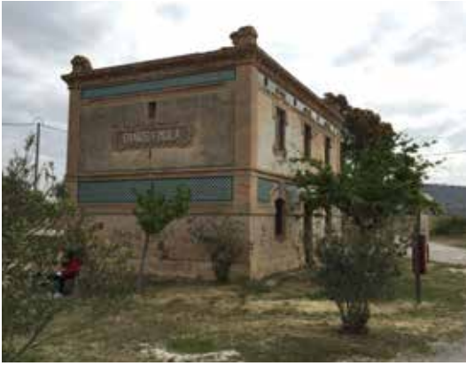
Fig. 1. Estación de Los Baños.
