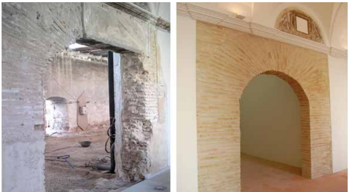
Figura 5. Hallazgo de la puerta de acceso al Hospital del siglo XV en la crujía este.
