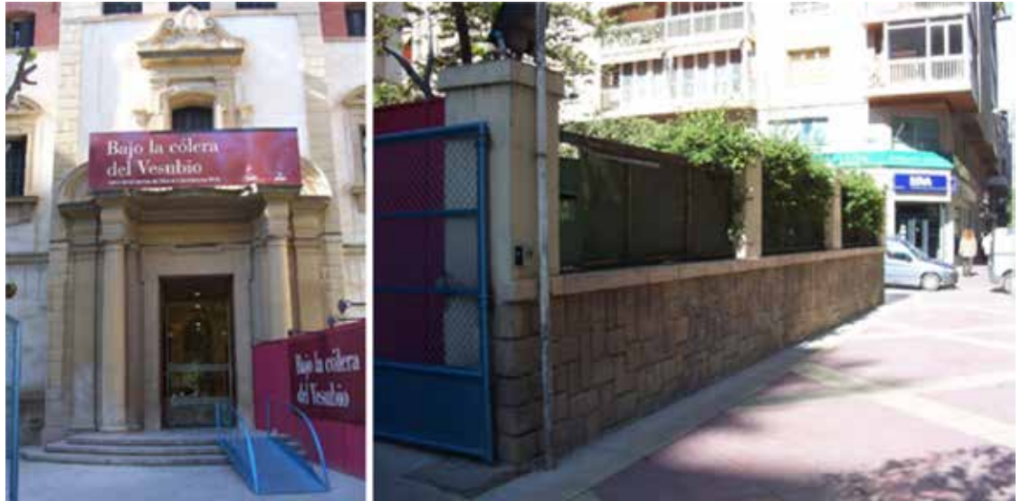
Fig. 7. Aspecto previo a la intervención del exterior del Museo
