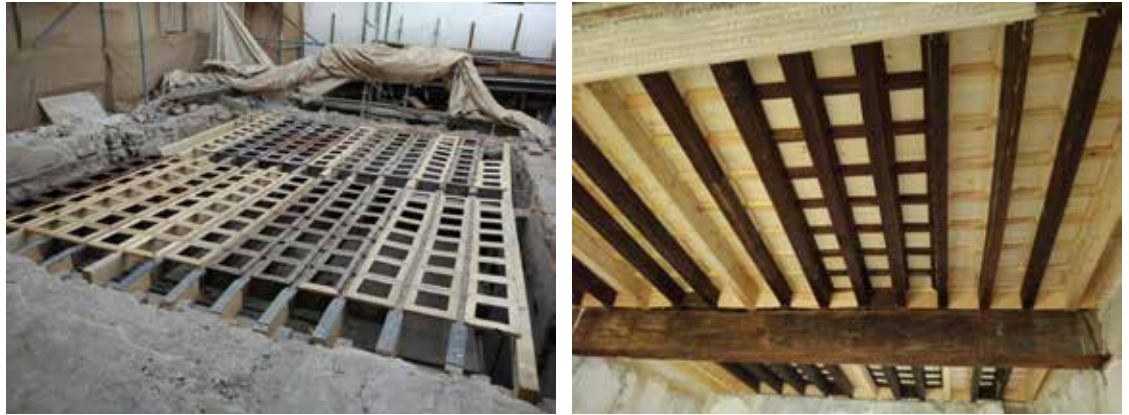
Figura 7. Casa Irurita en Lorca. Trabajos de recuperación de la cara superior (izda.) e inferior (dcha.) de la armadura del techo de planta baja del Salón Oeste
