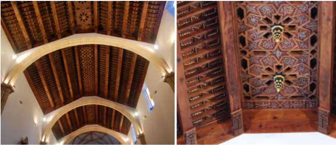
Fig. 1. Vista general del artesonado de la Iglesia Parroquial de la Purísima Concepción de Caravaca (izqda.), y detalle del almizate y faldón (con la solución de cinta y saetino) del tramo 2 (dcha.).
