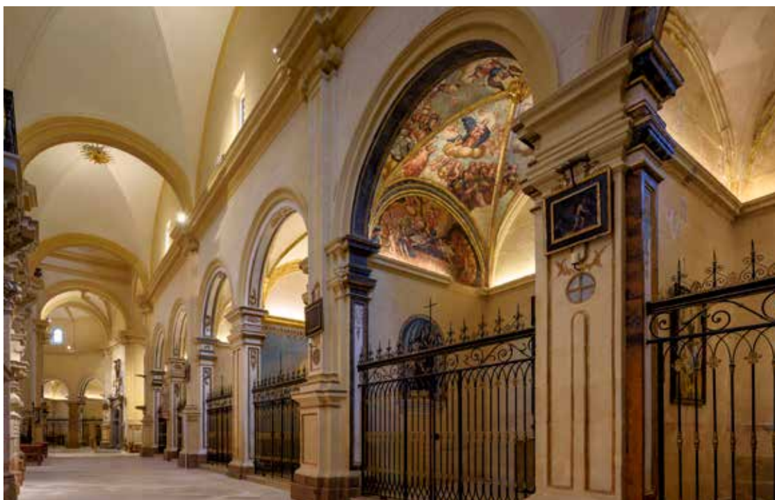
Figura 5. Nave de la Epístola de la Ex Colegiata de San Patricio. Lorca. Se aprecian las decoraciones de color recuperadas en el intradós de los arcos de acceso a las capillas situadas entre los contrafuertes. Fotografía Joaquín Zamora
