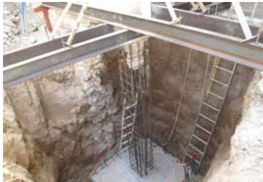
Fig. 1. Imagen de uno de los 8 pilares prolongados hasta nueva cota de planta inferior.
