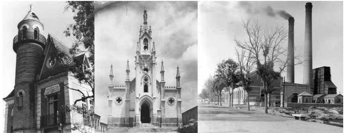
Fig. 2 Hitos: El Castillito, Iglesia del Barrio de Peral y Fábrica de la Luz
