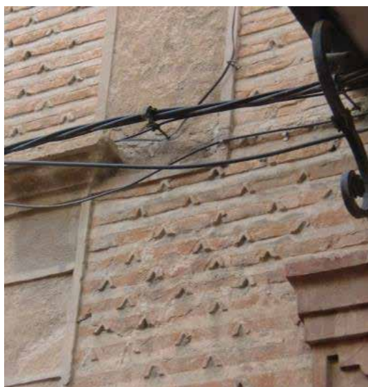
Fig. 2. Encintados y llagueado en “v” invertida en fachada.
