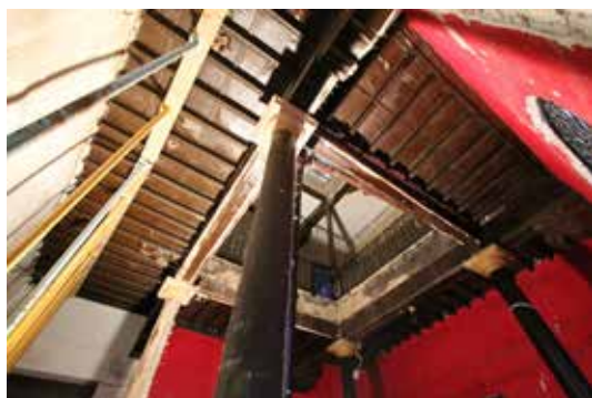
Figura 4. Casa de los Irurita en Lorca. Estado previo de planta baja al inicio de los trabajos (una vez retirado el tabique de separación)
