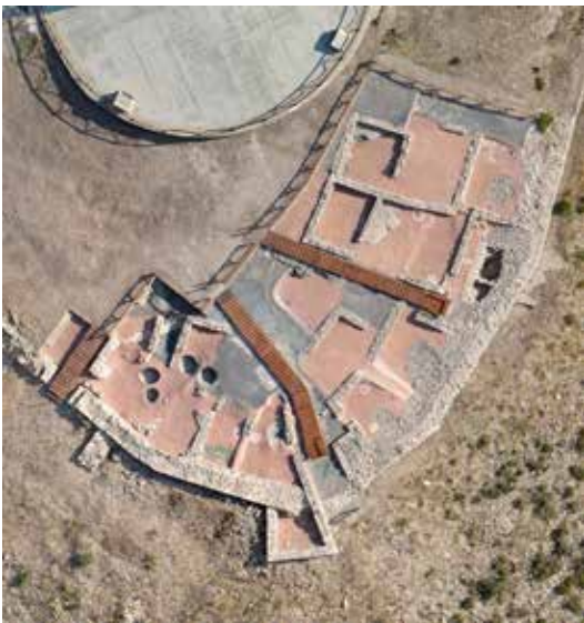
Figura 5. Ortofotoplano del área excavada tras finalizar los trabajos de puesta en valor.
