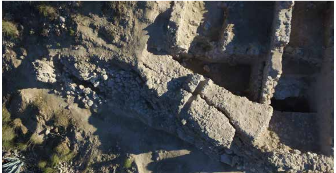
Fig. 4. Trazado de muralla donde se observa el gran derrumbe y desplazamiento ocasionado por una grieta seguramente producida por un sismo (Fotografía: Equipo de dirección arqueológica).
