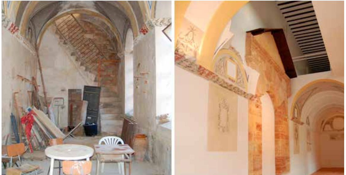
Figura 4. Hallazgo de la puerta original de acceso a la Iglesia en el claustro.
