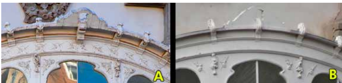
Figura 3. Mirador del edificio de la antigua Compañía del Ensanche, en Cartagena. A. Mirador original. B. Mirador nuevo.
