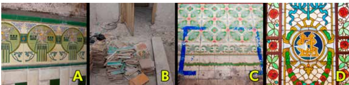
Figura 2. Vistas de la Casa Llagostera en proceso de demolición. A. Azulejos de Valencia Industrial con la técnica del “entubat”. B. Desmontaje de azulejos en estancias. C. Pavimentos modernistas con señalización de la parte a conservar, el resto a la escombrera. D. Vidriera con las iniciales del propietario desmontada.
