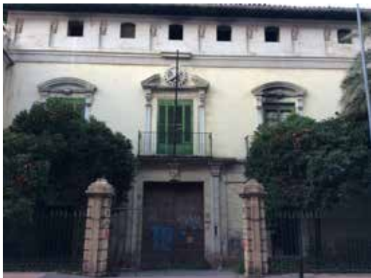
Fig.2. Edificio Principal de la Real Fábrica de Salitres de Murcia
