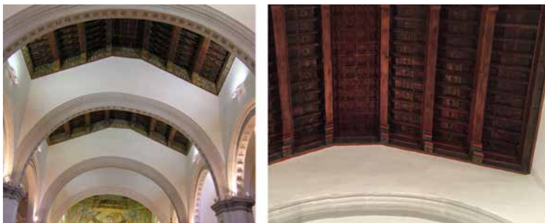
Fig. 2. Vista general del interior de la Iglesia de Ntra. Sra. de La Concepción de Cehegín con el macizo sobre los arcos y el artesonado (izqda.). Detalle del almizate y faldón del tramo 3 (dcha).
