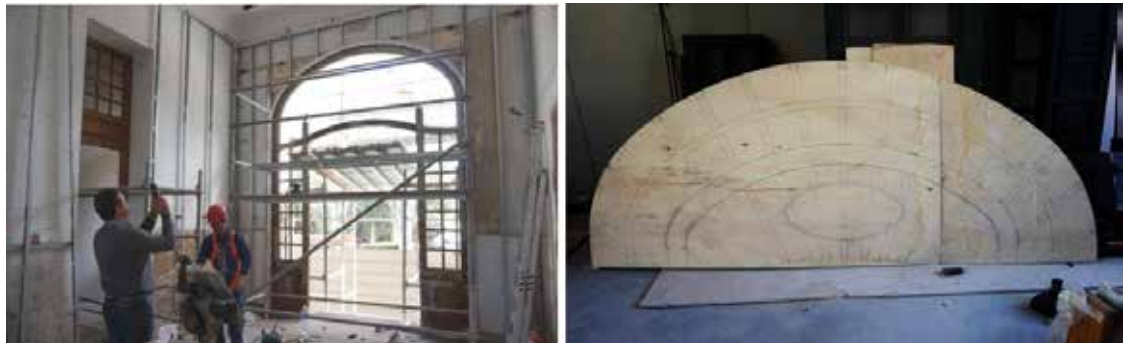
Fig. 3. Recuperación del dibujo en abanico del acceso principal. Plantilla a escala 1/1.
