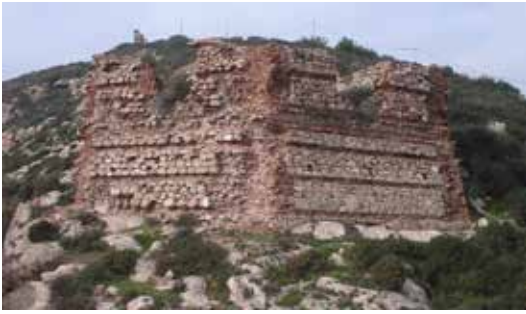
Fig. 3. Vista general de la Torre Navidad en la actualidad, desde el Fuerte de Navidad. (P.E. Collado)
