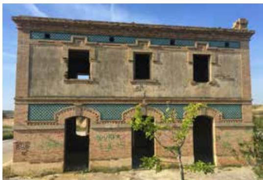
Fig. 5. Estación de Los Baños.
