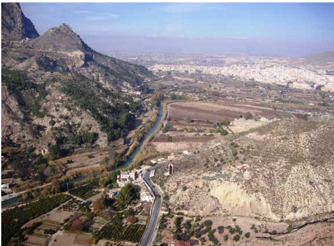
Fig. 1. Ubicación de Bolvax en la puerta Norte del Valle de Ricote, junto al río Segura. A la izquierda se observa Siyâsa y al fondo la ciudad de Cieza (Fotografía: José López López).
