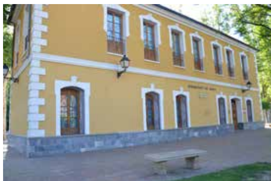
Fig.4. Edificio de Estadística del Ayuntamiento de Murcia
