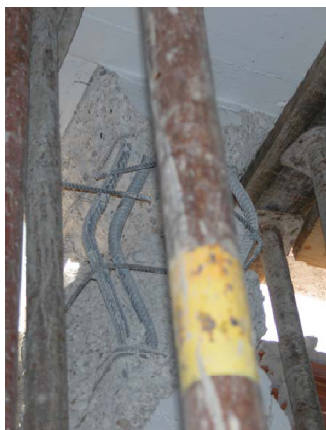
Figura 1 a) Localización de daños en pilares de planta baja. b) Fallo en pilar por flexocompresión. c) Fallo en pilar por cortante
