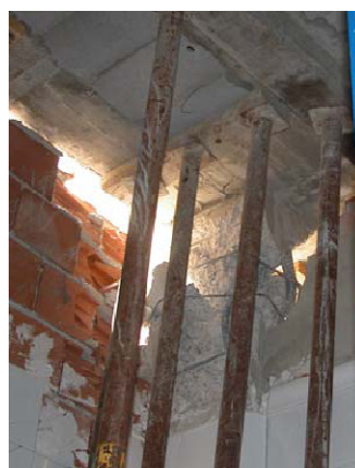
Figura 1 a) Localización de daños en pilares de planta baja. b) Fallo en pilar por flexocompresión. c) Fallo en pilar por cortante
