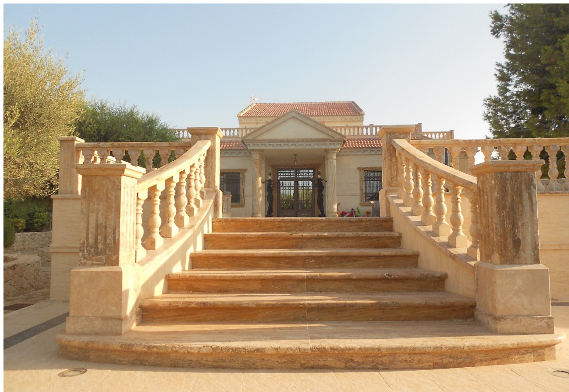
Figura 1. Entrada principal de la villa.
