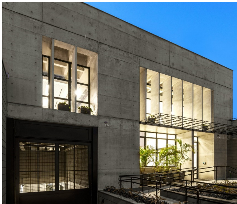
Figura 1. Imagen del frente de la edificación.
