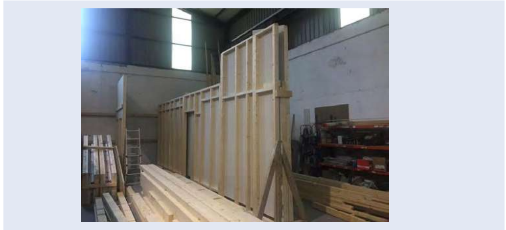
Figura 82. Premontaje de bloque de madera de ingeniería. Fuente: medgon.com
