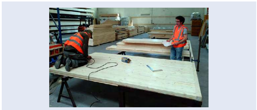
Figura 83. Fabricación de bloque de madera de ingeniería. Fuente: medgon.com
