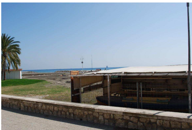
Instalación de almacén de embarcaciones junto a paseo marítimo
