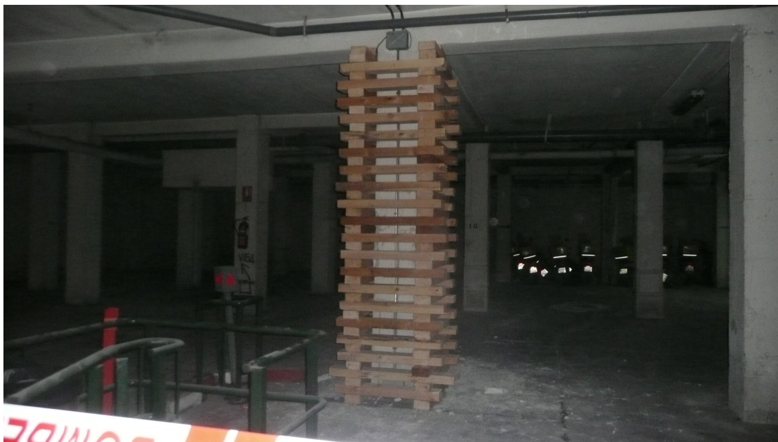
FIGURA 6. Diseño de apeo complementario de pilar y su protección. El apeo transmite las cargas verticales al terreno o planta inferior mediante piezas de madera horizontales a flexión apoyadas sobre otras piezas de reparto del mismo material. Permite reparar el origen (desplome, asiento, etc.) salvando el pilar afectado. Edificio Residencial San Mateo, de Lorca.
