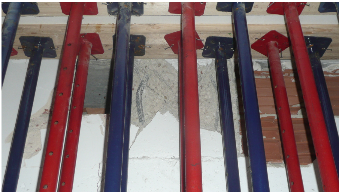
FIGURA 3. Apuntalamiento de emergencia muy riguroso. Edificio situado en calle Auroros de Lorca. Este apuntalamiento permite la transmisión de carga vertical a otras plantas o terreno mediante el empleo de puntales metálicos verticales a compresión y sopandas horizontales de madera a flexión. No apto para poder sustituir o reparar la cabeza del pilar dañado.
