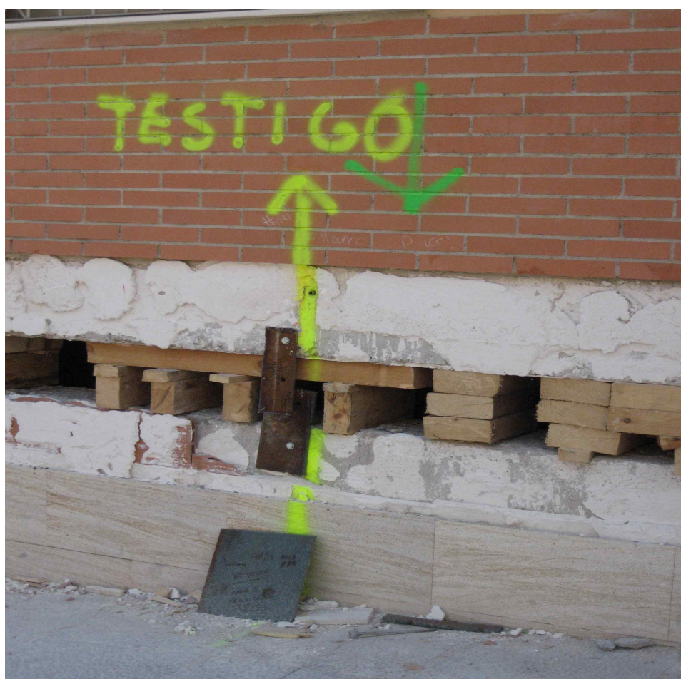
Torsión motivada por el efecto rigidizante de los muros medianeros de un edificio de esquina.
