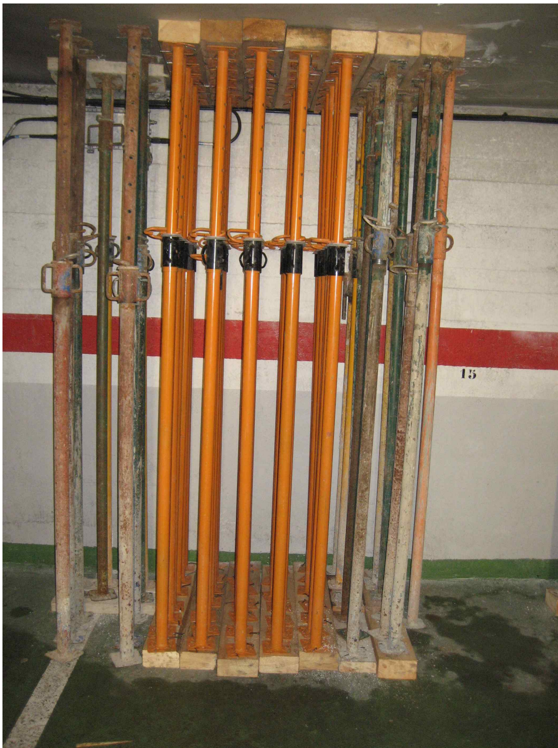
FIGURA 13. Apeo supletorio: Tornapuntas metálicos verticales con durmientes y sopandas de madera, que transmisión de la carga del forjado o de elemento horizontal al suelo o terreno acortando la luz.
