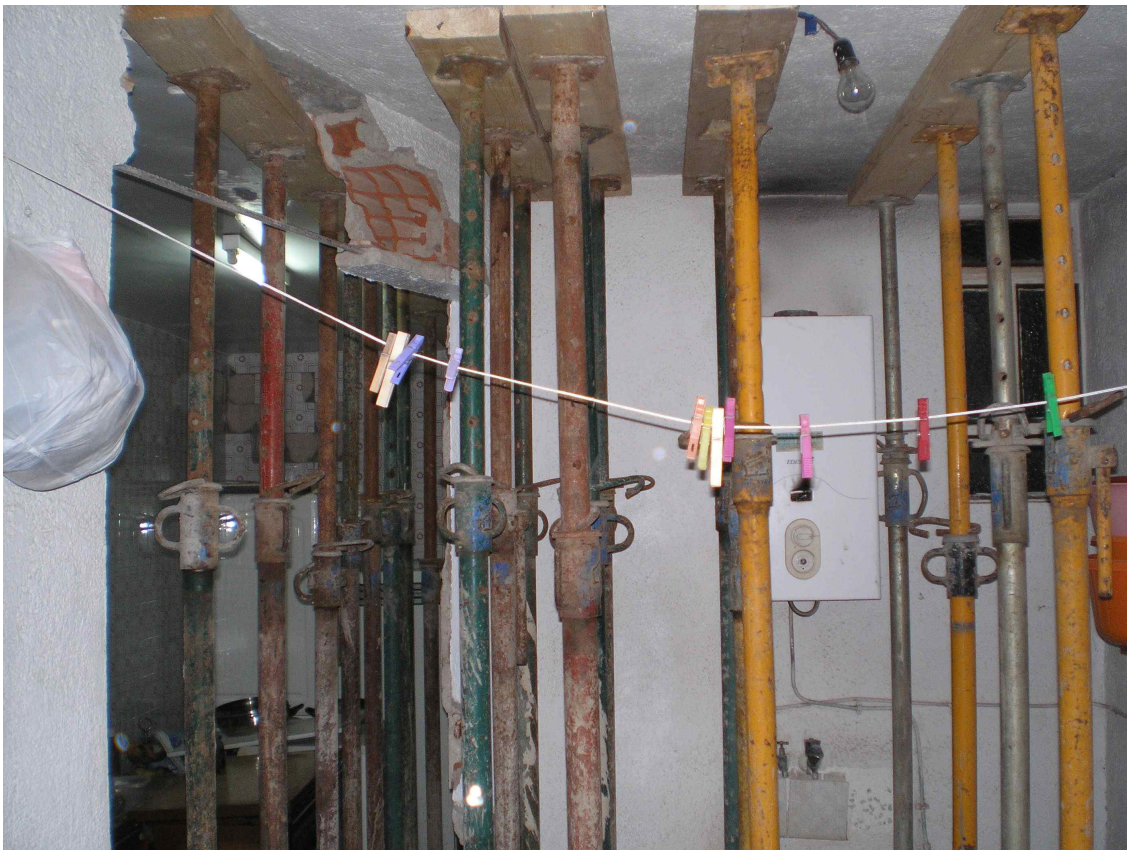
FIGURA 14. Apeo supletorio: Tornapuntas metálicas verticales con durmientes y sopandas de madera, de transmisión de la carga del forjado o de elemento horizontal al suelo o terreno acortando la luz, por pérdida del muro de ladrillo que divide las instancias. Ataja un peligro inminente. No supone una solución de apeo definitiva.
