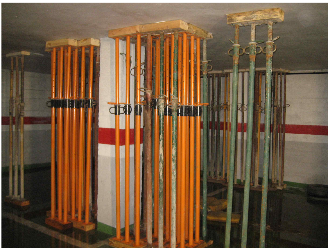
FIGURA 12. Apeo supletorio: Tornapuntas metálicas verticales con durmientes y sopandas de madera, que transmisión de la carga del forjado o elementos horizontal al suelo o terreno acortando la luz. Ataja un peligro inminente. No supone una solución de apeo definitiva. Vallado provisional para acotar la zona de seguridad.
