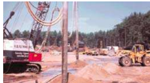
Vibroflotación.
