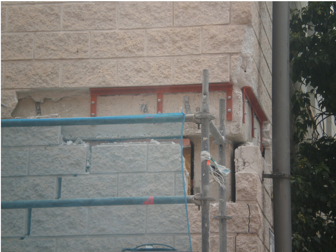
Detalle de colocación de elemento metálico en canto de forjado por falta de estabilidad de fábrica exterior de cerramiento de fachada. En edificio sanitario situado en Lorca.
