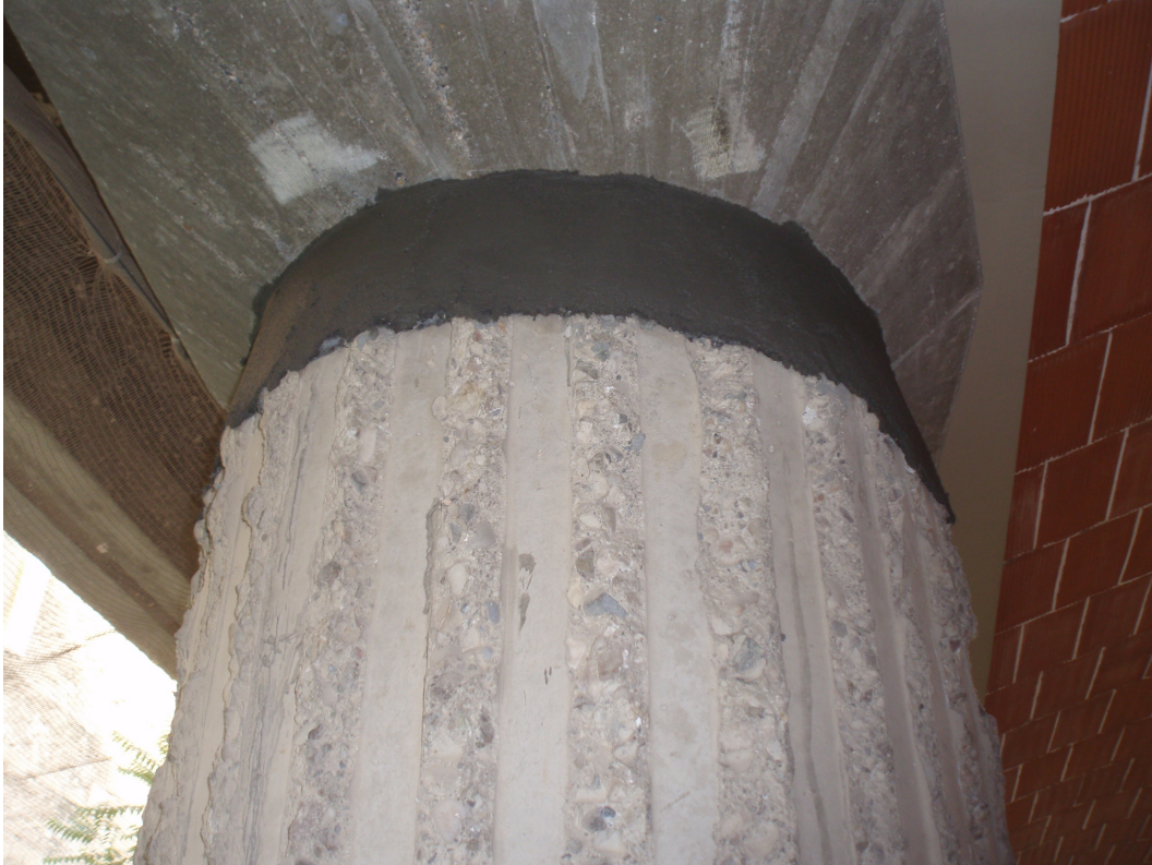
Detalle de capitel de hormigón armado y reparación de lesiones por sismo con mortero epoxi en su collarín. Edificio en Lorca.
