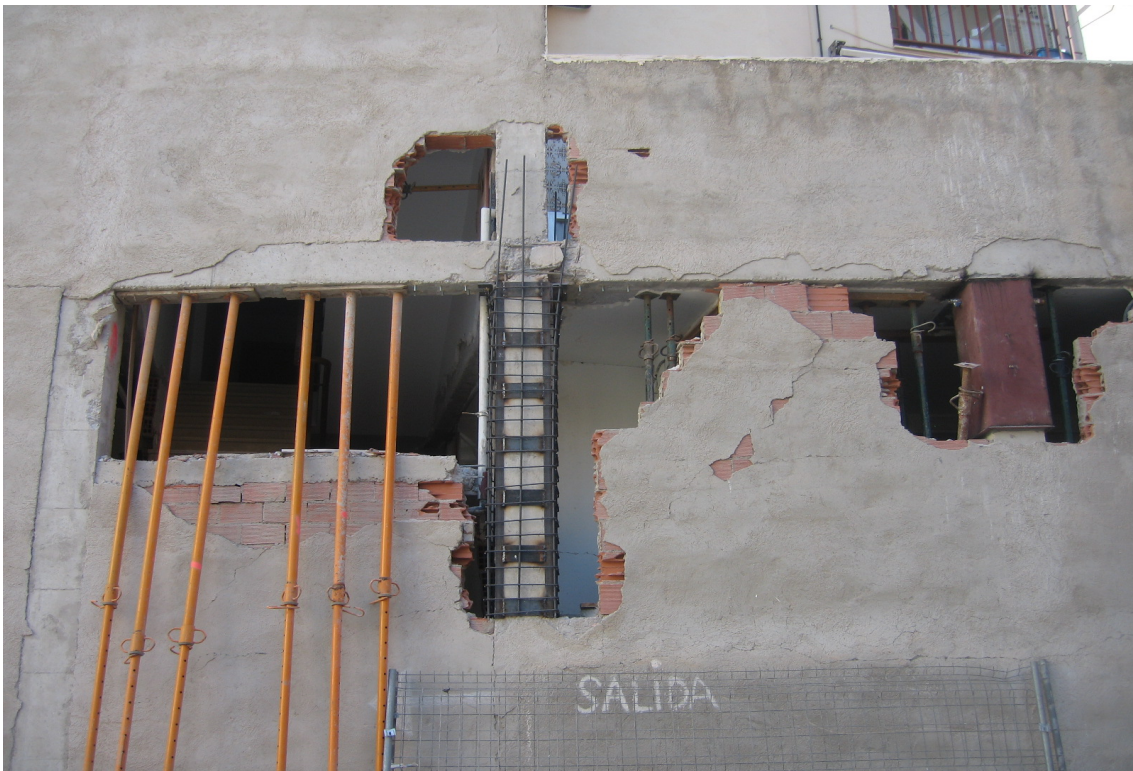
Detalle de nudo pilar-viga, unión poco fiable, falta de confinamiento.
