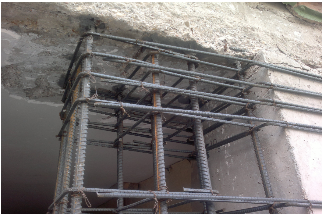
Detalle de armado de cabeza del nuevo pilar adosado al existente
