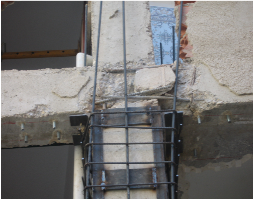
Detalle de nudo pilar-viga, unión poco fiable, falta de confinamiento.
