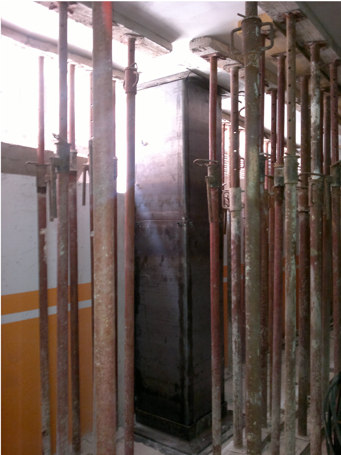
Foto. El apeo supletorio también ha permitido realizar operaciones de refuerzo del pilar de hormigón armado con lesiones graves. El procedimiento empleado ha sido el de refuerzo mediante camisa metálica. Pilares entubados.
