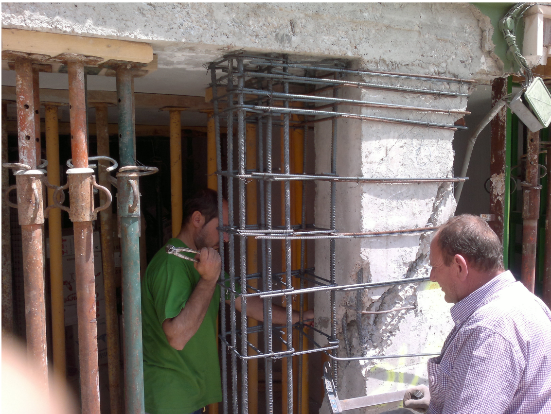
Foto. El apeo supletorio como el que aquí se representa permite realizar operaciones de refuerzo del pilar de hormigón armado con lesiones graves. El procedimiento a seguir ha sido el de ampliar la sección del pilar de hormigón con el mismo material, creando una pantalla o contra fuerte en planta baja blanda, solución antisísmica muy ideal.
