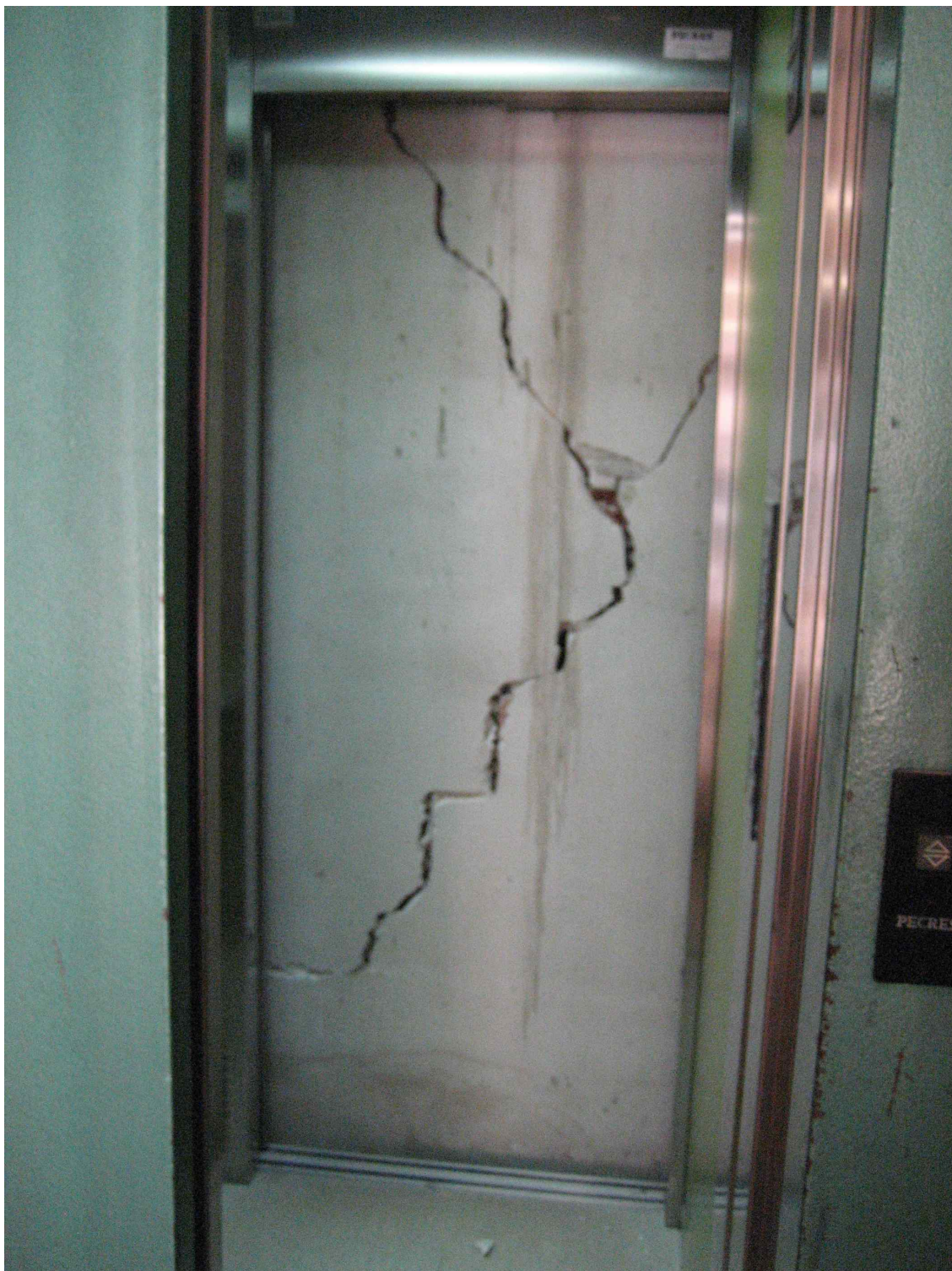
FIGURA 44.- Daños no estructurales. Lesiones graves en cerramiento de caja de ascensores en edificio de Lorca. Se observa puerta de ascensor deformada por cargas de compresión
