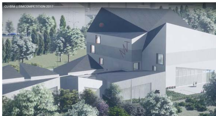
Fig 3. Infografía exterior de la Casa de la Música y el Teatro. Fuente: CuBIM (2017) 3
