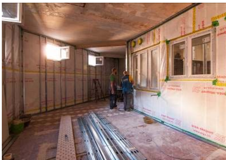
Fig. 3 Proceso de construcción. Fuente: Glauco Estudio (2017)
