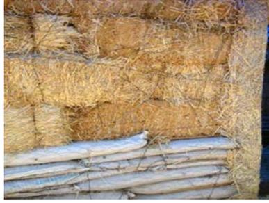
Figuras 24, 25, 26 y 27: Las imágenes muestran los detalles del acomodo de la malla de refuerzo de marcos de puertas y ventanas que se usa para dar el soporte y forma necesarios en el acabado de éstas partes de la construcción.
