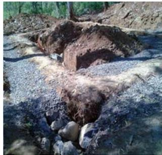
Figuras 4 y 5: Ambas imágenes muestran el detalle del llenado de las zanjas. A la derecha, se muestra en detalle el relleno final con grava hasta el nivel del terreno
