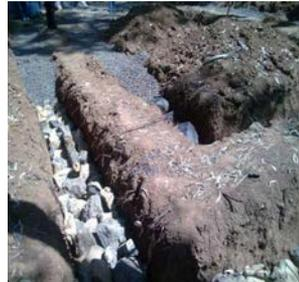
Figuras 2 y 3: A la izquierda, detalles de la excavación de las zanjas, interior y del canal perimetral. A la derecha, detalles del relleno de ambas zanjas
