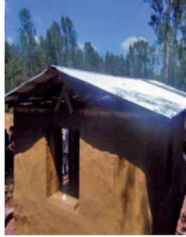
Figuras 37 y 38: A la izquierda se muestran los detalles de la base de madera del techo con las travesas hechas con polines y vigas. A la derecha la obra del techo terminada.
