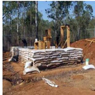
Figuras 10 y 11: A la izquierda, colocación de los marcos de puertas. A la derecha, continuación del levantamiento de paredes con los costales de tierra.
