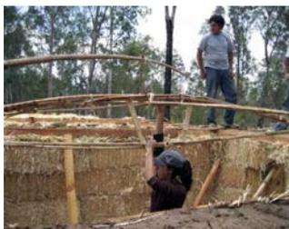
Figuras 33 y 34: En la página anterior a la izquierda detalles del armado de los arcos de bambú con apoyo de pijas y mecate. A la derecha, acomodo de los arcos de bambú distribuidos uniformemente en el área del techo.
