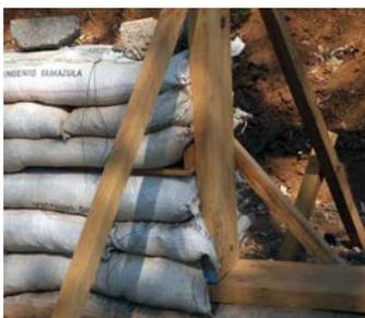
Figuras 12 y 13: A la izquierda, sujeción de la escuadra de madera con la línea de costales y el marco de la puerta. A la derecha, se aprecia la distancia aproximada entre una escuadra y la otra, al continuar levantando las paredes.
