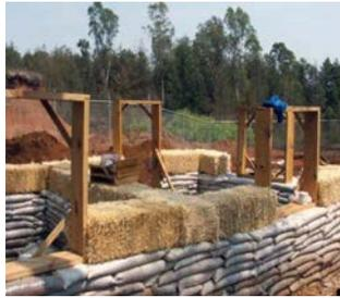
Figuras 14 y 15: A la izquierda, preparación de las varillas de carrizo con matapolilla ecológico. A la derecha, acomodo de la primera hilera de pacas de paja sujetas a la hilera de costales por medio de las varillas de carrizo.
