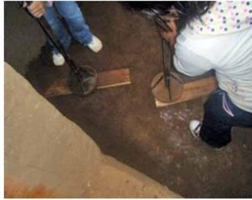
Figura 48: Detalle del apisonado de la cal con tierra para la base del piso de cal y arena
