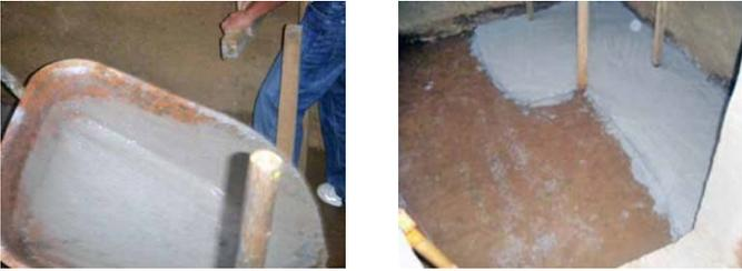
Figuras 50, 51 y 52: Figura al centro arriba, mezcla de arena y cal para el entortado. Figuras abajo, muestran los detalles del acarreo y colocación de la mezcla y aplanado del entortado.
