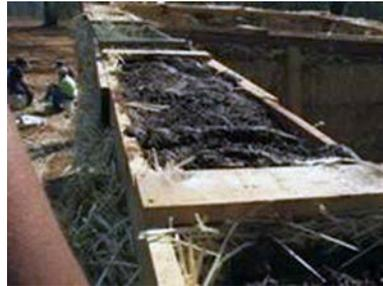
Figuras 18 y 19: Detalles de la cadena de madera para el cierre del levantamiento de las paredes. A la derecha, relleno de la cadena con mezcla de tierra arcillosa.
