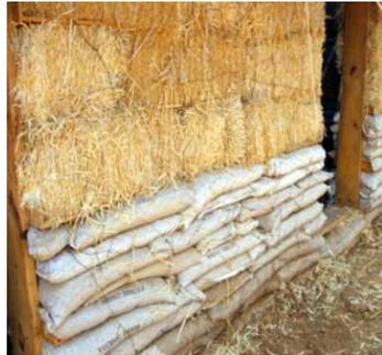
Figuras 20 y 21. Se muestran detalles del tejido de alambre en las pacas de paja y en la sujeción de la malla en los costales por medio de los alambres.
