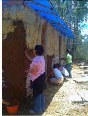
Figuras 29, 30, 31 y 32. Imágenes de detalle del repello de paredes. Para unir capas de repello de diferente día de trabajo, humedecer la capa del día anterior y continuar repellando.
