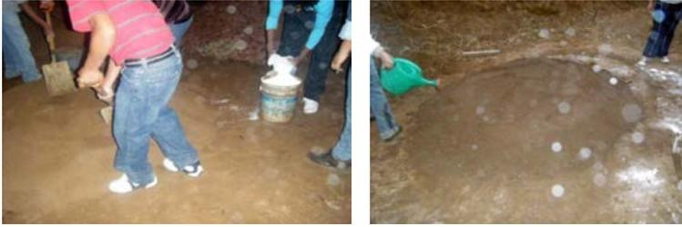
Figuras 46 y 47: Detalles de la mezcla de tierra y cal humedeciendo la mezcla con apoyo de una regadera.
