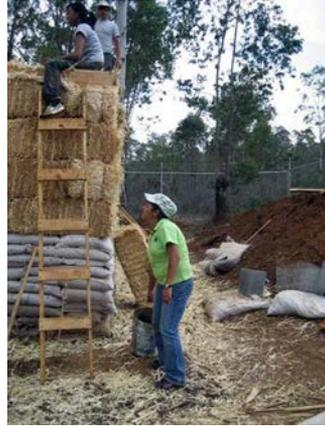
Figuras 16 y 17: Detalles del levantamiento de paredes con las pacas de paja.
