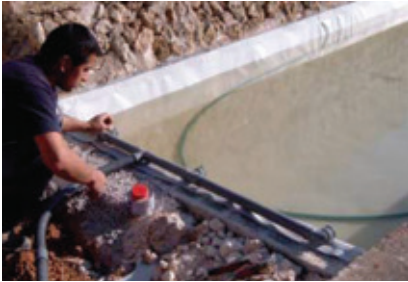
Instalación de fontanería. Plumbing installation.
