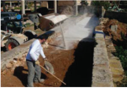
Construcción de muretes y vaciado de tierras. Construction of walls and drainage of lands.
