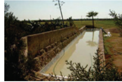
Prueba de impermeabilización. Waterproofing test.
