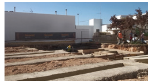
Cimentación de cal en masa Lime Foundation
