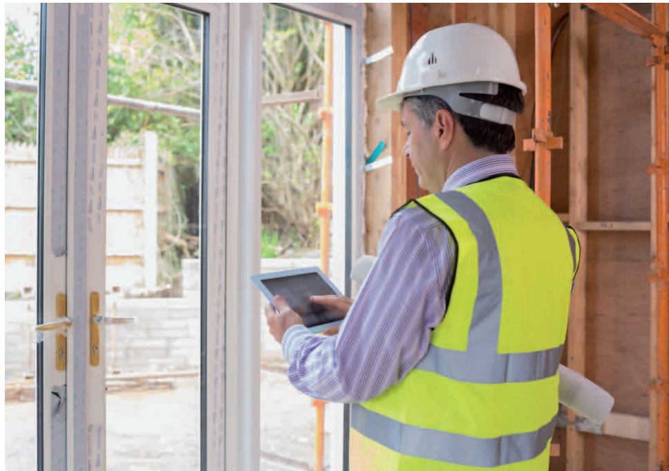
Recopilando información sobre el emplazamiento donde se realizará la obra
