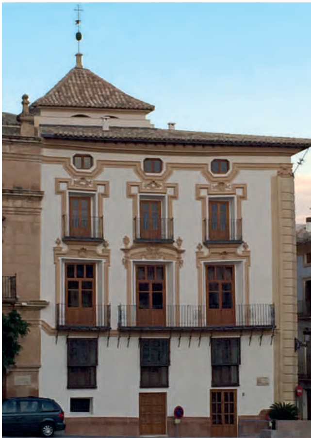
Figura 13. Fachada de la casa hacia la plaza de España, una vez concluidos los trabajos tanto de reparación de grietas, como de revestimientos, así como en aleros, zócalos, ventanas y balcones. Fotografía: Juan de Dios de la Hoz.
