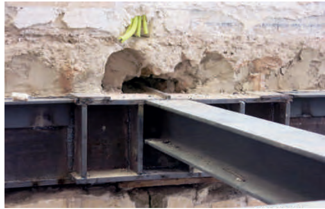
Figura 16. Refuerzos de vigas de madera y capiteles.
