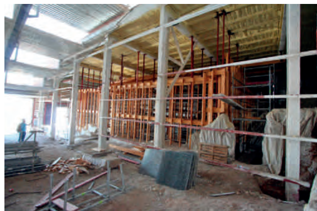
Figura. 63. La construcción del entramado de madera colgado para no interferir ni altear de ninguna manera los restos existentes (septiembre de 2011).
