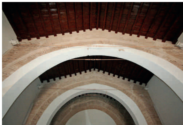
Figura 12. Detalles de tirantes de refuerzo en los arcos diafragma.
