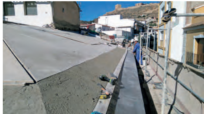
Figura 12. Detalle de la ejecución de la nueva cubierta.
