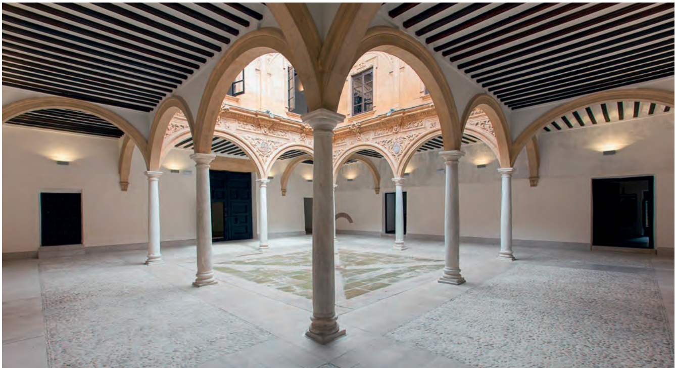
Figura 8. El patio tras la restauración.
