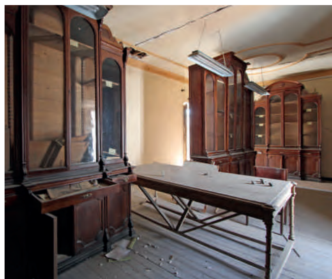
Figura 10. Biblioteca en planta alta, desmantelada tras los terremotos.
