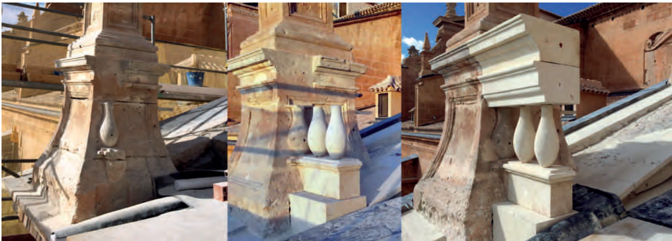
Figura 14. Izquierda. Base del pináculo que remata el tímpano lateral, donde se ha descubierto un balaustre idéntico a los del tejado sobre la capilla mayor, lo que refuerza la hipótesis de una terraza con balaustrada. Las imágenes a la derecha muestran la nueva inserción de dos balaustres y cornisa para permitir su lectura tras las obras. Fotografías: Juan de Dios de la Hoz.
