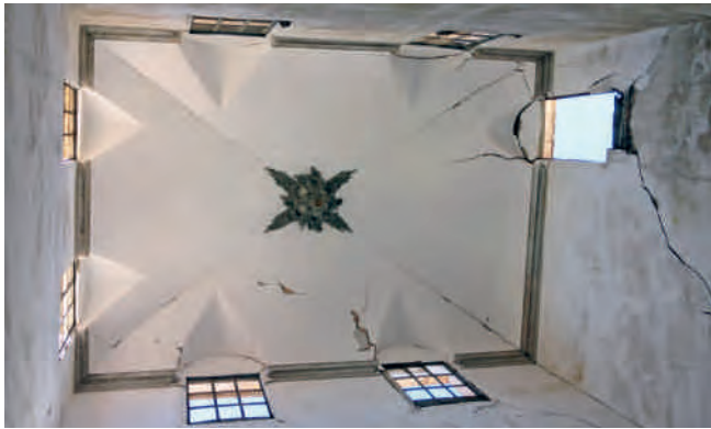
Figura 16. Cara inferior del forjado del torreón.
