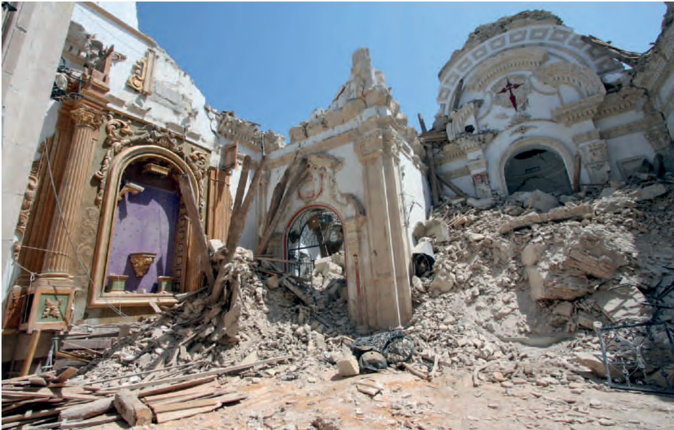
Figura 14. Retirada del material desplomado del crucero de la iglesia de Santiago.
