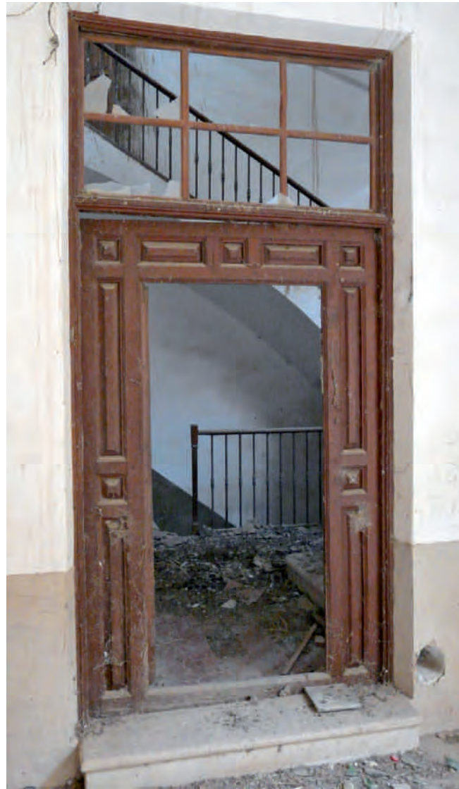
Figura 21. puerta de entrada vivienda desde zaguán.
