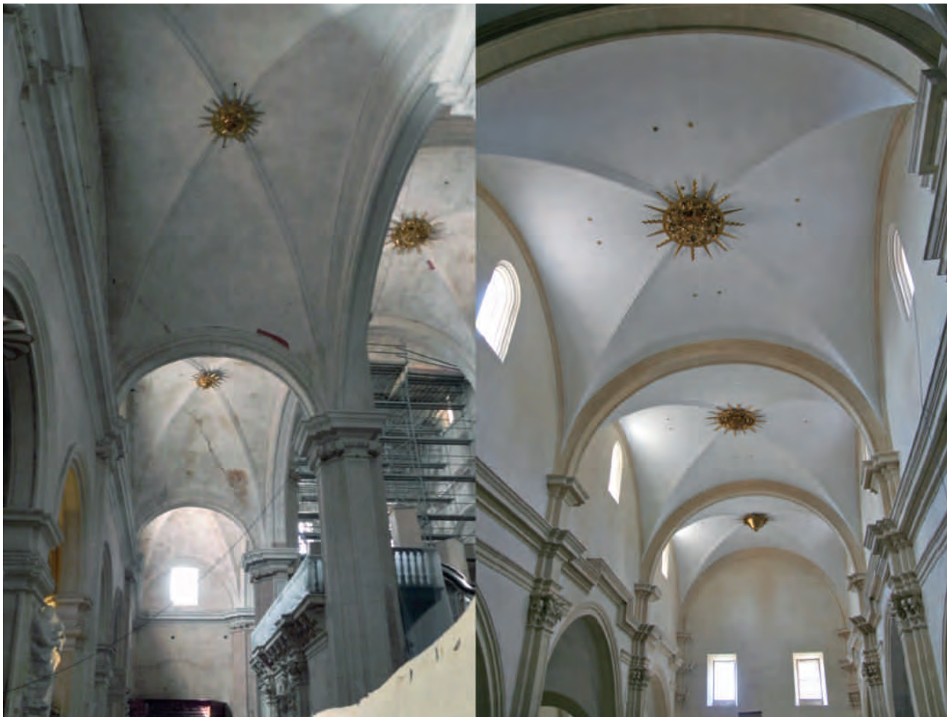
Figura 20. Estado previo y final de las bóvedas y arcos de San Patricio una vez reparadas las grietas y desplomes, así como los pinjantes dorados, el yeso y las pátinas de los arcos, paramentos, etc. Fotografías: Pablo Molina.
