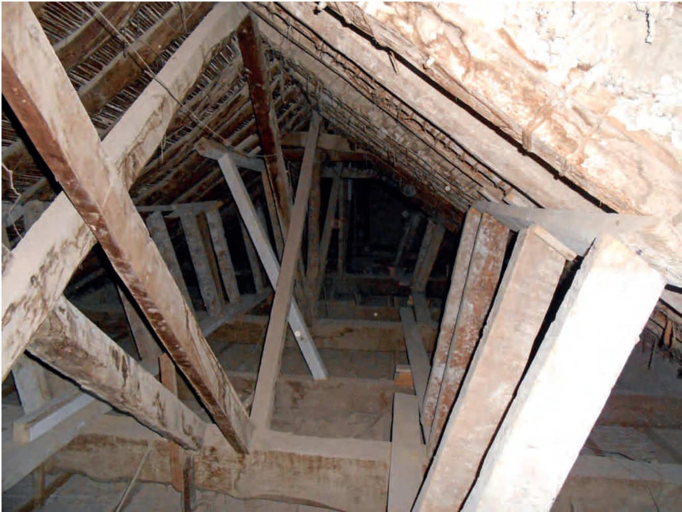
Figura 11. Cubierta sobre el salón de billar, en situación de gran precariedad estructural.
