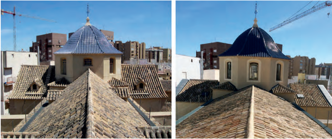
Figura 12. Dos imágenes correspondientes al estado previo (izquierda) y final (derecha), donde se observa la variación de las pendientes de los faldones.
