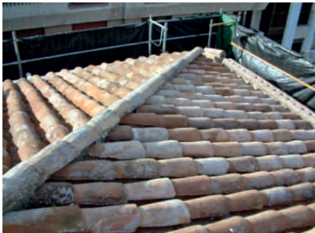
Figura 8. Zona de la cubierta terminada. Encuentro de los dos paños perpendiculares entre sí de la esquina de las dos fachadas.
