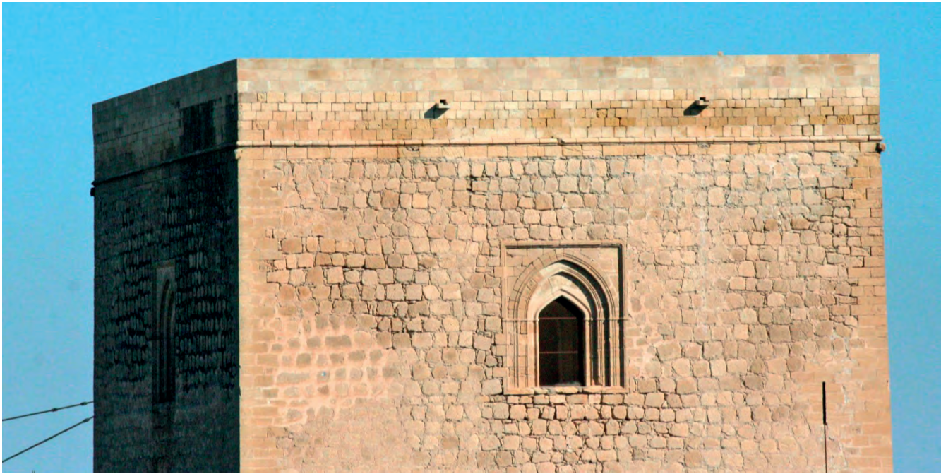
Figura 40. El remate de la torre Alfonsina tal como se percibe en la actualidad. La distinción entre los sillares añadidos y los existentes se deja al corte más perfecto y a las llagas más ajustadas sin ripios, mientras que el color de la fábrica se percibe igual desde la lejanía.
