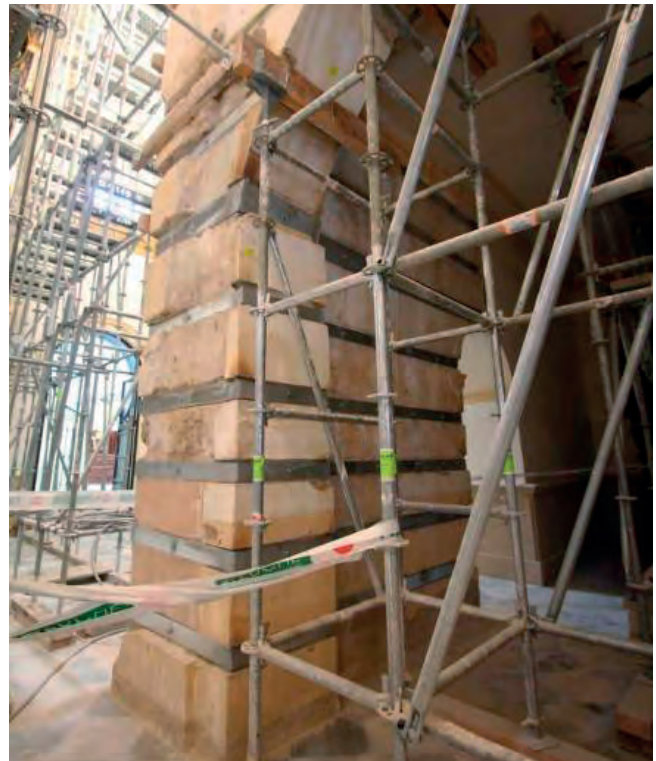
Figuras 23 y 24. Aspecto que presentaban las pilastras zunchadas en 2011 (las platabandas fueron totalmente eliminadas en la emergencia de 2012).
