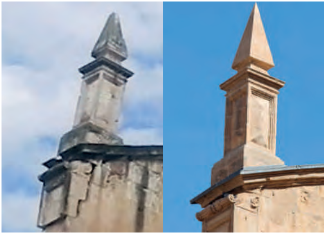
Figura 21. Estado previo y final de uno de los pináculos, una vez reparado el fallo por deslizamiento de su base y completado las piezas faltantes, así como el fijado con varillas de fibra de vidrio al soporte. Fotografías: Juan de Dios de la Hoz.
