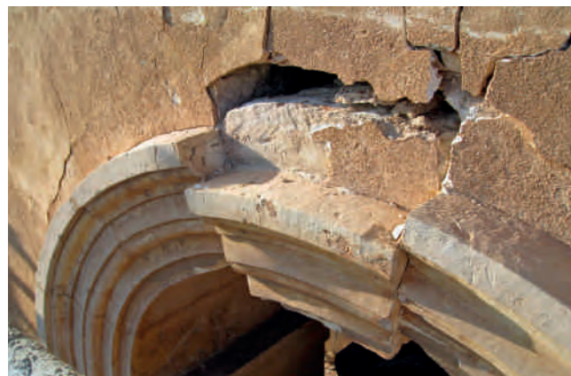
Figura 7. Descenso de la dovela central de uno de los huecos del cuerpo de campanas. Fotografía: Juan de Dios de la Hoz.
