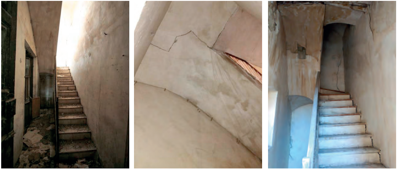
Figura 20. Escalera de servicio de acceso a planta primera, de desembarco a planta segunda y de acceso al torreón.
