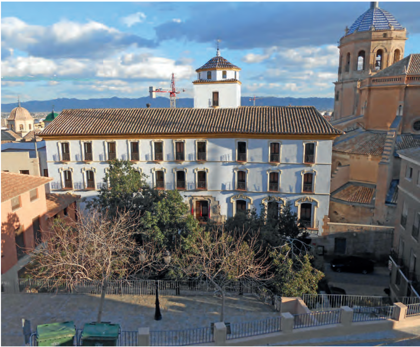
Figura 1. Panorámca del edificio, colindante con la colegiata de San Patricio.
