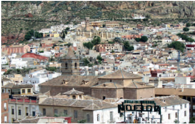
Figura 2. Vista general de las cubiertas tras los seísmos.
