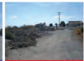
21. Mota río abajo. La mota del río se interrumpe al llegar a una fábrica y almacén de arroz. El lugar se encuentra muy deteriorado, lleno de escombros y supone una barrera para la continuidad del paseo.
