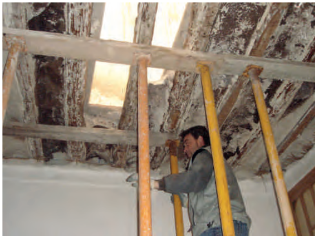
Figura 6 y 7. Apeos de forjados hundidos un año antes del terremoto.
