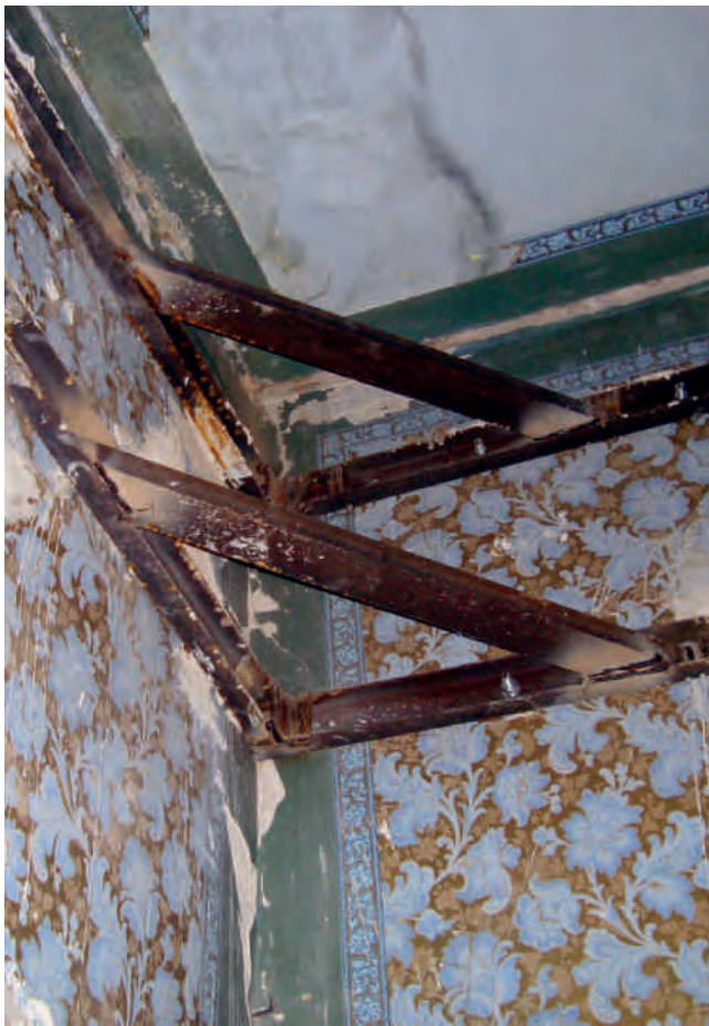
Figura 25. Sujeción de la fachada (P. 1.º).
