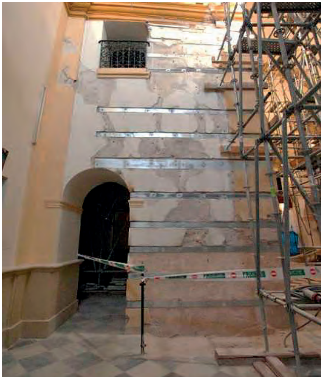
Figuras 23 y 24. Aspecto que presentaban las pilastras zunchadas en 2011 (las platabandas fueron totalmente eliminadas en la emergencia de 2012).
