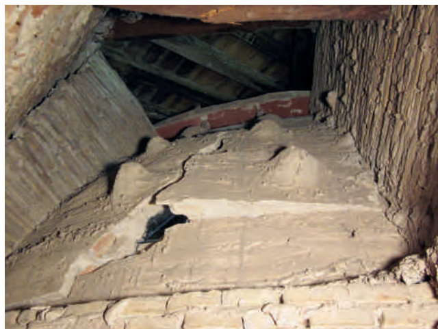
Figuras 5A, 5B y 5C. Composición con la fractura, desplazamiento y giro de la cúpula. Fotografías: JCC.
