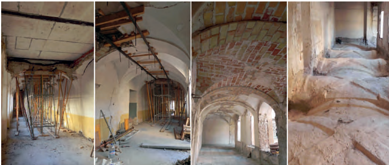
Figura 7. Fotografías: el interior de una de las pandas del claustro, reforzada tras los seísmos con losas de hormigón (a y b). A su derecha (c), una vez retiradas las losas (en el piso se aprecian los cortes preparatorios para el desmontaje del nivel inferior) y restauradas las bóvedas superiores a base de dos rosas tabicadas de ladrillo macizo (o ejecutadas de nuevo las que se desplomaron). La fotografía (d) muestra el trasdós de estas bóvedas tras retirar la losa de hormigón y los perfiles metálicos, una vez ejecutada su restauración con el doblado de las rosas y los arcos. Fotografías: Juan de Dios de la Hoz.
