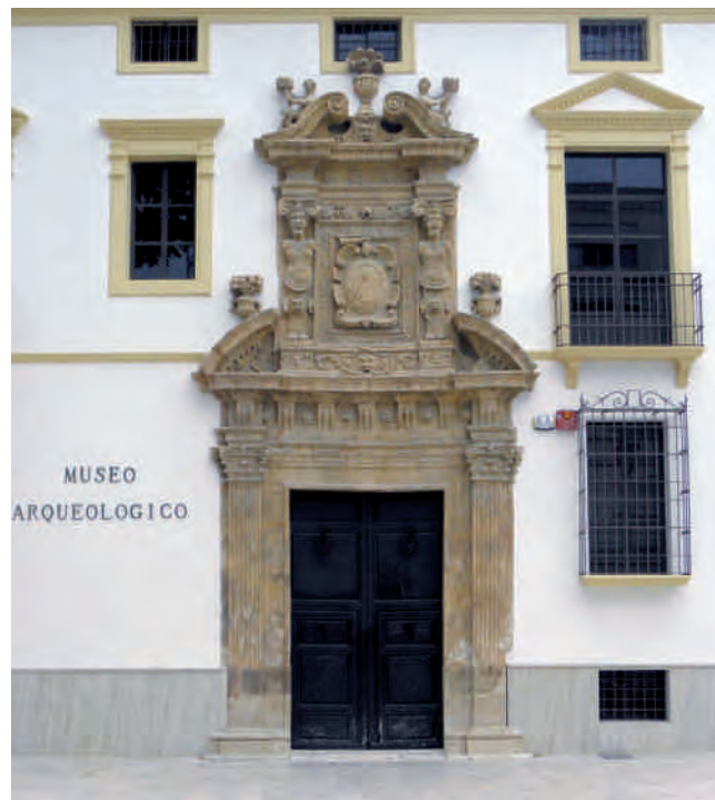
Figura 1. Fachada principal del MUAL (casa Salazar) antes de la intervención. Fotografía: Jerónimo Granados.
