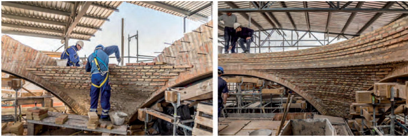
Figuras 14. Proceso de construcción de la estructura cerámica del crucero: A la izquierda, cierre del espacio entre dos de los arcos formeros ya terminados, para conformar una de las pechinas. A la derecha, culminación de las cuatro y levantado de las primeras filas del arranque del tambor. Fotografías: Jaime J. Díaz.
