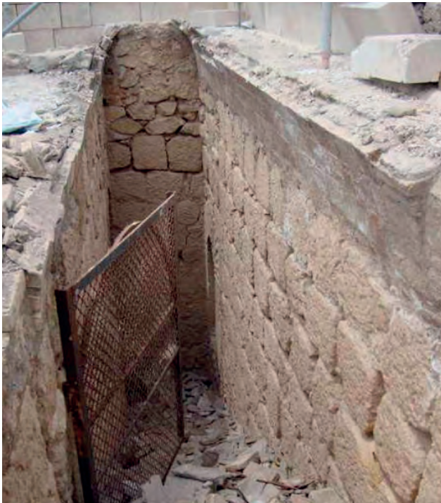
Figuras 38A y B. Bóveda que cubría la escalera en la terraza y el peto en construcción tras la acción del seísmo.
