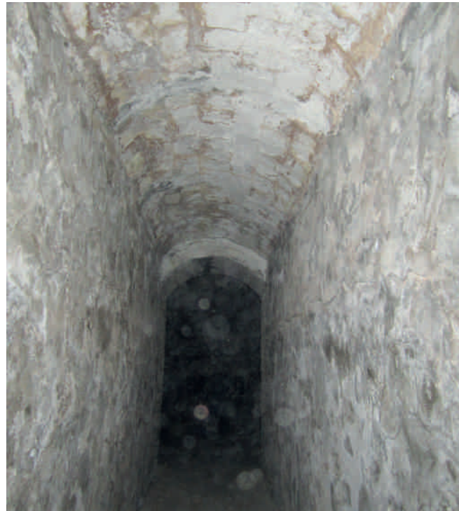
Figura 6. Túnel en sótano.
