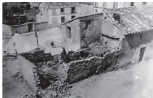
Figura 3. Vivienda dañada terremoto de Lorquí 1911. Fotografía: Ayuntamiento de Lorquí en Atlas Global de la Región de Murcia .
