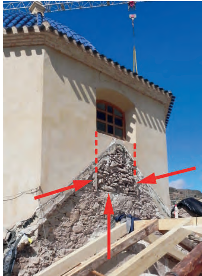
Figura 13. Detalle de la recuperación de la dimensión de uno de los huecos de ventanas del tambor, eliminando la sobreelevación de las cubiertas de los brazos del crucero. Fotografías: Juan de Dios de la Hoz.
