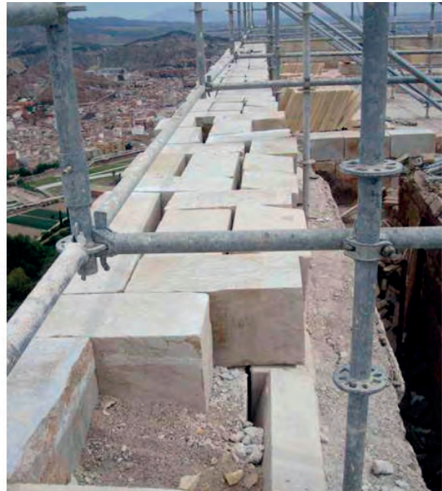
Figuras 38A y B. Bóveda que cubría la escalera en la terraza y el peto en construcción tras la acción del seísmo.
