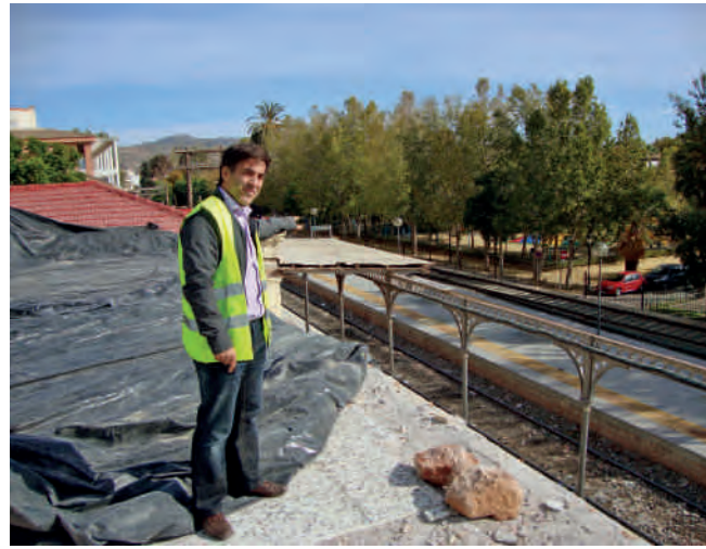
Figura 4. Sobre el forjado de planta baja, tomando datos para el proyecto de reconstrucción. Fotografía: F. J. García Carreras.
