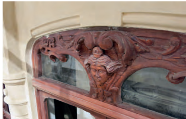
Figura 18. Estado restaurado de elementos ornamentales de carpintería.
