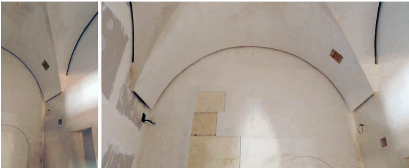
Figura 12. Bóveda encamonada de cañizo, completamente exenta de los muros, mediante un foseado perimetral de 5 cm (también se ha dejado vista una pequeña ventana donde se aprecian las cañas y la cuerda de cáñamo que las une). En el paramento norte se aprecian los restos de un arco y una cadena de sillares en vertical, correspondientes al encuentro entre el cierre del atrio, en su encuentro con el brazo del crucero. Fotografías: Carmen Martínez Ríos.
