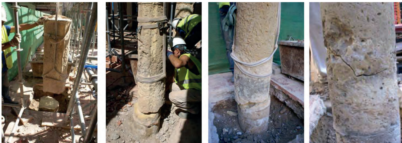
Figura 8. Composición con diversos fustes del cuerpo inferior, seccionados al nivel del empotramiento bajo el solado de la plaza. Fotografía: JCC.
