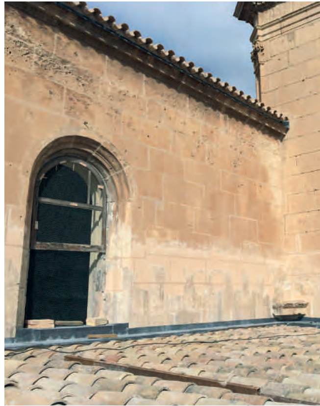
Figura 12. Imágenes correspondientes a la cubierta del transepto sur, antes de las obras (izquierda) y durante los trabajos (derecha). Se ha reducido la pendiente del faldón hasta introducir los palos en los antiguos mechinales en el muro, dejando libre completamente la ventana. Gracias a ello se recupera la dimensión completa (queda reflejado en la fachada, el nivel que alcanzaban los faldones, mutilando las jambas y lo hemos resaltado en línea de puntos sobre la imagen). Fotografías: Juan de Dios de la Hoz.
