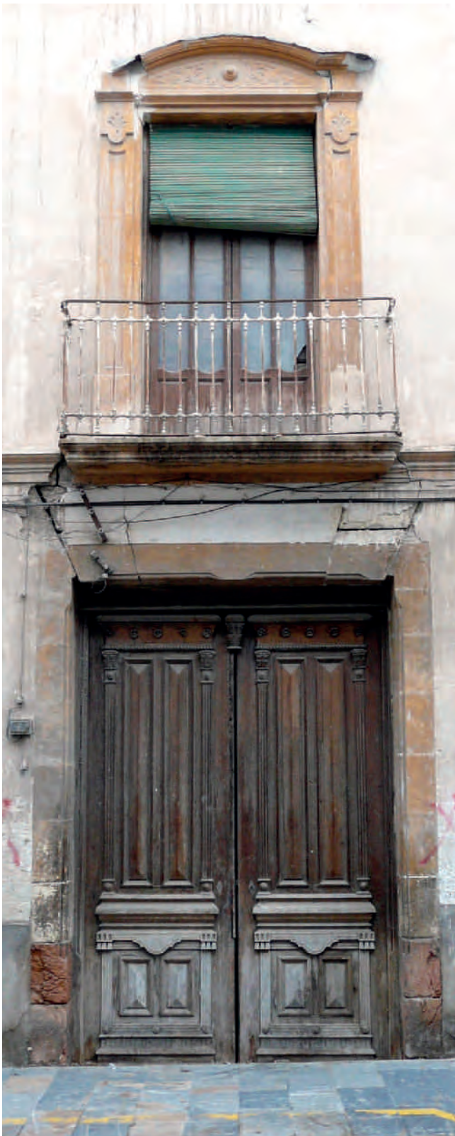
Figura 15. Detalle del portón de entrada, fachada a calle Lope Gisbert.
