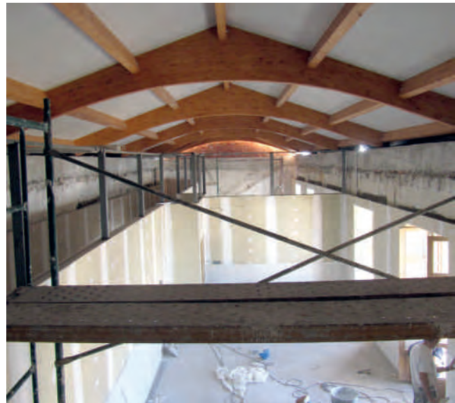
Figura 5. Disposición interior de las vigas de cubiertas.
