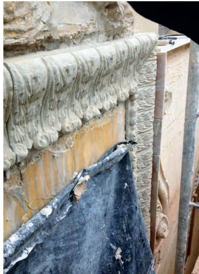
Figura 13. Reproducción de piezas de yeso en portada.
