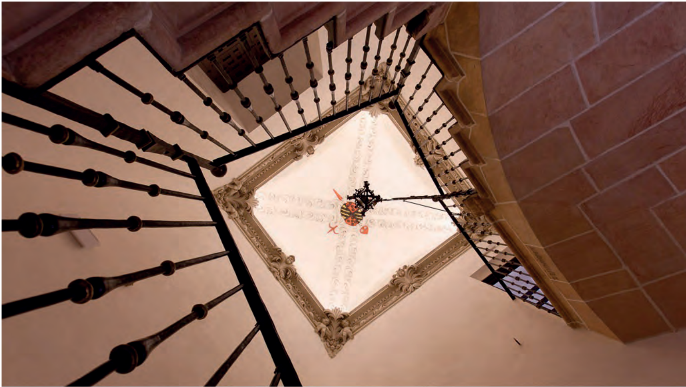
Figura 7. La escalera principal tras la restauración.
