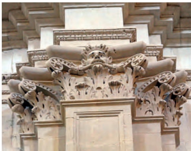
Figura 23. Detalle de uno de los capiteles de la nave central, una vez limpio de las múltiples capas de grasa, cal y pintura que lo deformaban. Fotografía: Juan de Dios de la Hoz.
