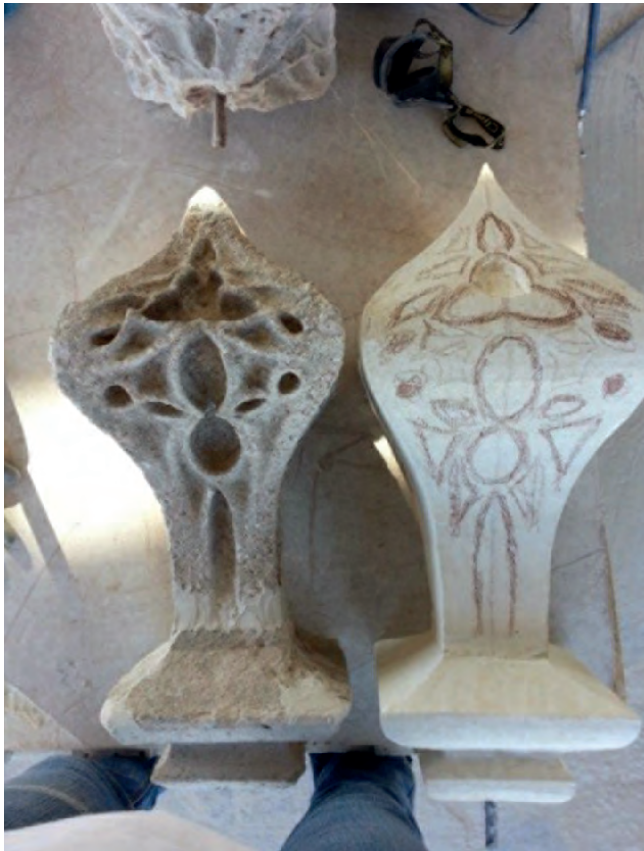
Figura 6. Detalles de la recuperación de las piezas ornamentales de la crestería. Fotografías: Reyes Molina.
