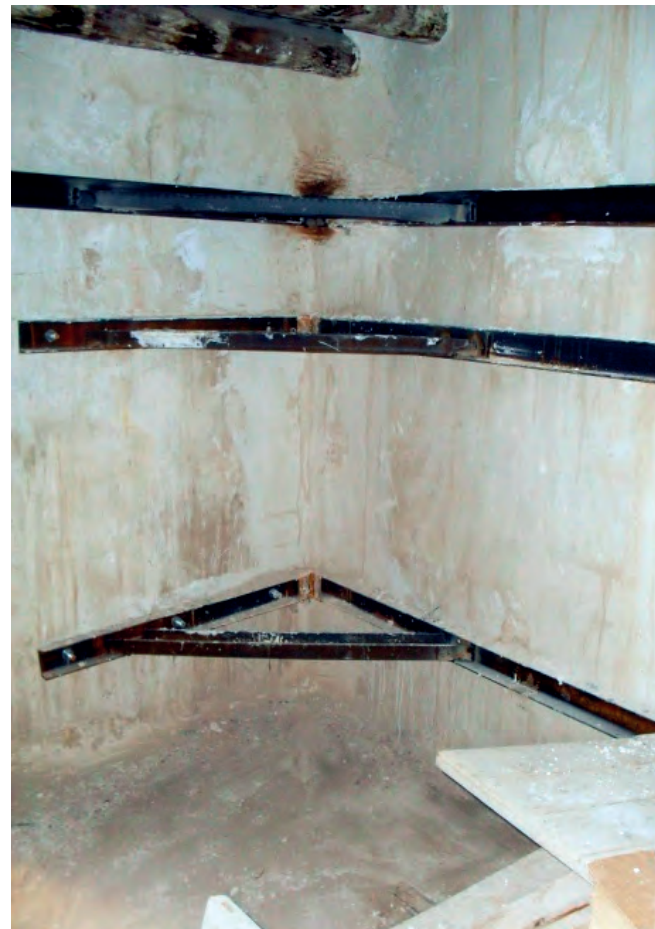
Figura 26. Sujeción de la fachada (P. 2.º).
