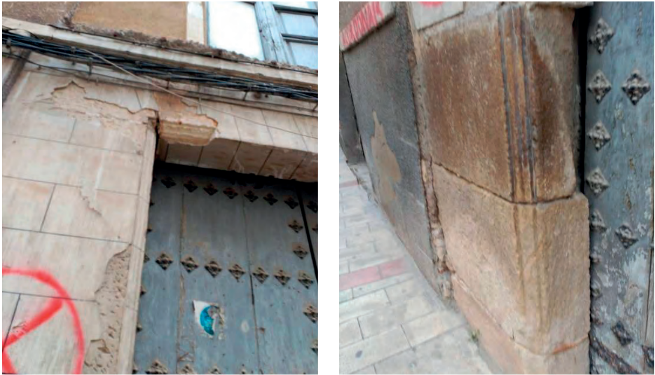
Figura 24. Detalles de la portada de sillares de piedra oculta bajo el revestimiento.
