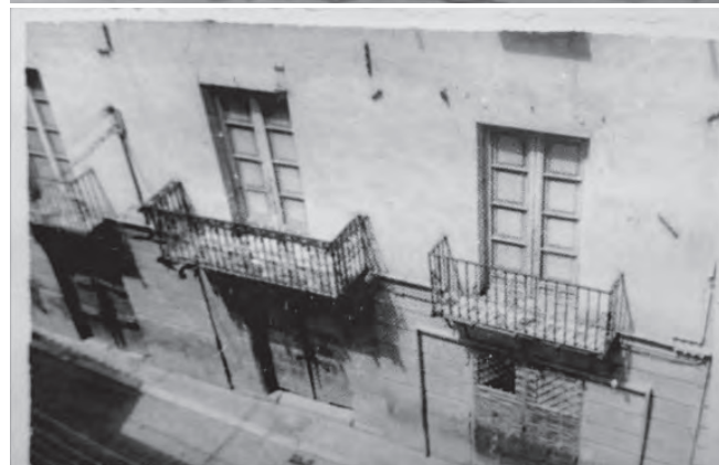
Figura 23. Información gráfica de 1922 donde se aprecian los balcones originales del edificio en su fachada principal.
