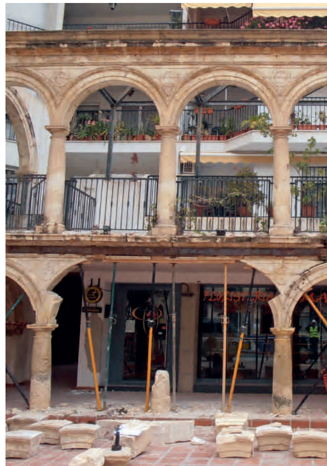
Figura 7. Rotura tras el terremoto de uno de los fustes y arrastre de las arcadas contiguas. Fotografía: JCC.
