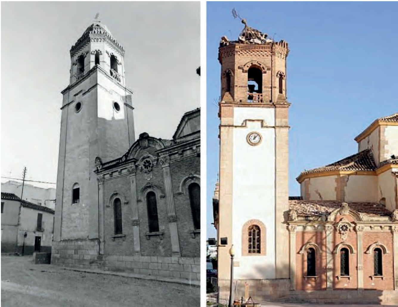
Figura 9. Izquierda: convento Virgen de las Huertas en 1902. Derecha: estado del edificio después del terremoto de 2011. Fotografías: inventario Bienes Muebles de Murcia, Ministerio de Cultura (1978) y Comunidad Autónoma de la Región de Murcia.
