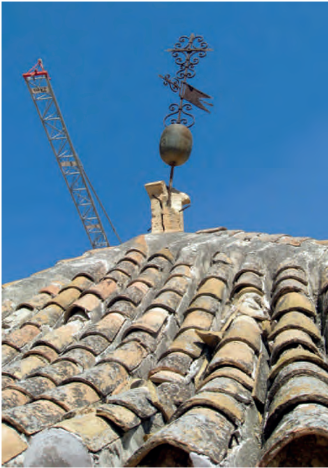
Figura 8. Remate del torreón que ilumina la escalera del inmueble, con desorganización general de tejas y rotura de su remate de piedra y el consiguiente vuelco de la veleta y la bola. Fotografía: Juan de Dios de la Hoz.
