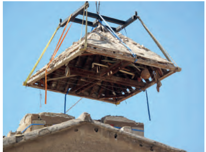
Figura 13. Elevación de la cubierta. Su peso era de 3 to.
