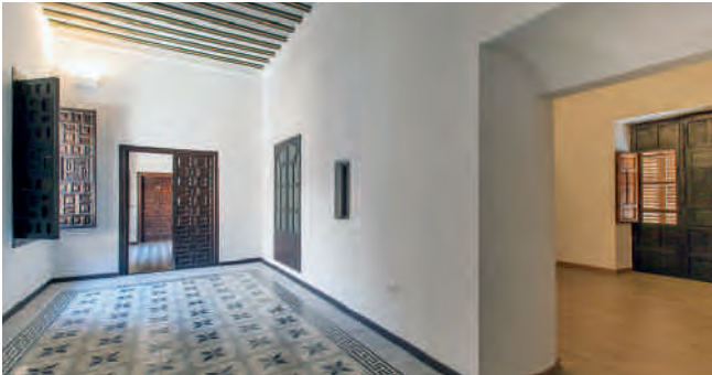
Figura 12. Restauración y rehabilitación de paramentos, pavimentos y carpinterías del salón rojo.
