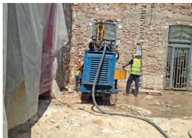
Figura 6. Ejecución micropilotes cimentación. Fotografía: F. J. García Carreras.
