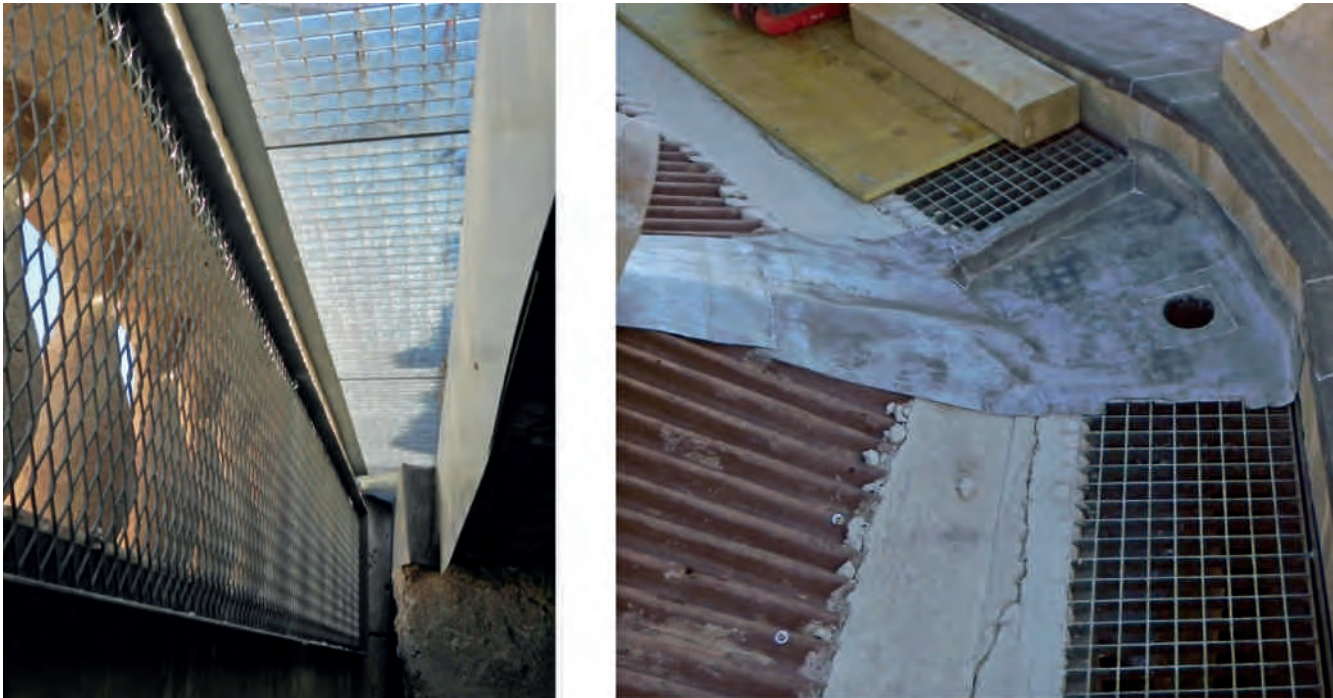
Figura 18. Desarrollo de las obras en la cubierta de la girola, recuperando la antigua evacuación de las aguas. Se han ejecutado rebosaderos, vierteaguas y bajantes de plomo, así como la instalación de planchas de trámex completamente exentas de la balastrada. Fotografías: Juan de Dios de la Hoz.
