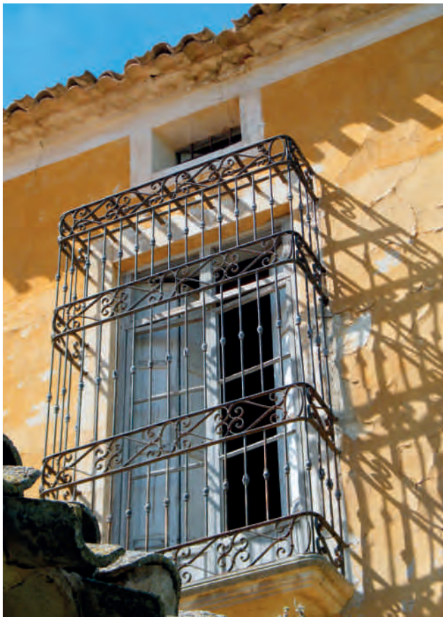
Figura 8. Detalle de cerrajería de huecos y balcones.
