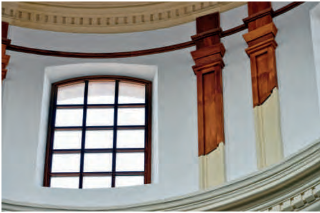
Figuras 19. Interior de la cúpula con el detalle de una de las pilastras del tambor en la que se aprecia parte de la misma recuperada entre los escombros mientras que el resto se ha completado con madera sin tallar a modo de sólido capaz. Fotografía: Joaquín Zamora.
