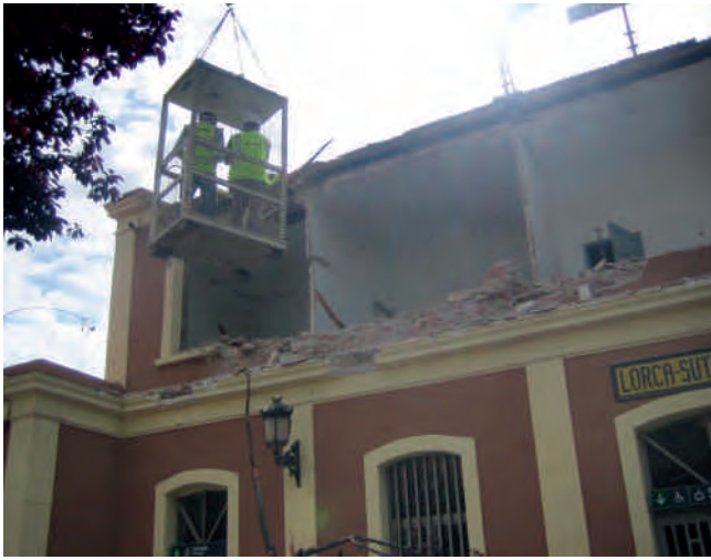
Figura 3. El autor subido a una cesta la mañana del día 12, inspeccionando la cubierta. Fotografía: F. J. García Carreras.
