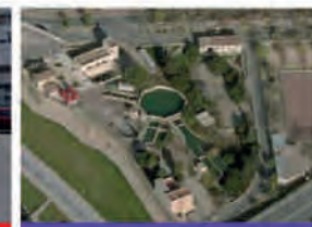
15. Parador de agua y jardín. Esta instalación supone un obstáculo en recorrido a lo largo del río, pero resulta interesante la posibilidad de hacer accesibles sus espacios verdes e integrarlos en un posible paseo.
