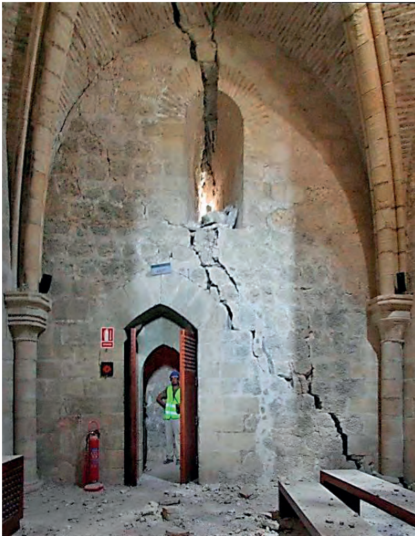
Figuras 14 y 15. En el interior la rotura más ostensible se sitúa en el recinto superior, uniendo las grietas los puntos más débiles de ventanas y hueco de escalera.
