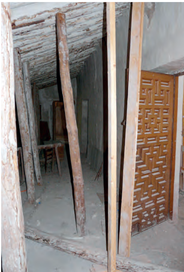
Figura 20. Apoyo de la estructura de cubierta en las cámaras de planta 2.ª.
