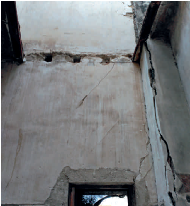
Figura 13. Forjado techo de planta primera en paso a escalera de servicio.
