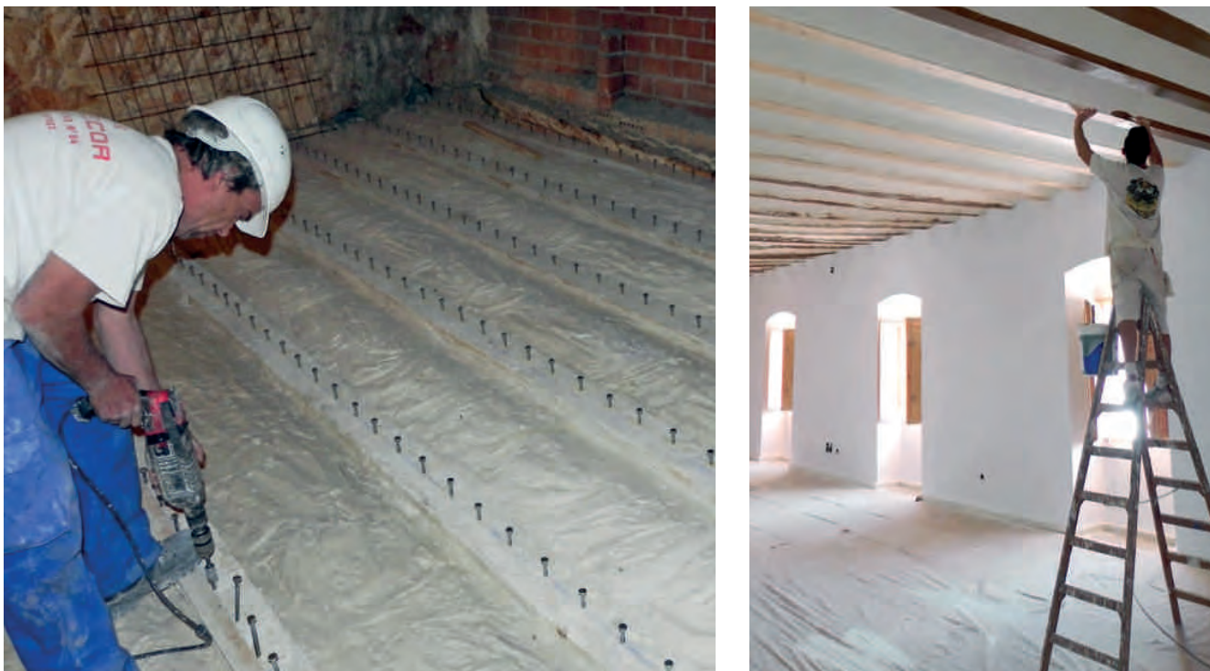
Figura 21. Detalle de los trabajos para incrementar la capacidad resistente de los forjados mediante una nueva cabeza de compresión con tornillos berraqueros, arlita y mallazo (izquierda) A la derecha, mismo forjado por su cara inferior, una vez finalizada su consolidación.
