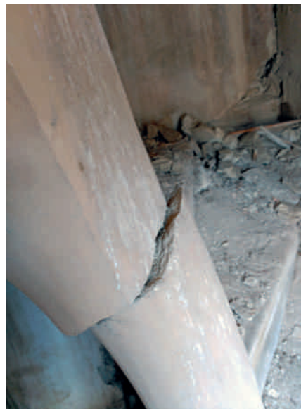
Figura 19. Escalera de caracol de acceso al torreón con rotura de su nabo central.
