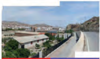
8. Naves junto carretera acceso castillo. Esta carretera es un bonito recorrido junto a las faixas del castillo, pero la accesibilidad para peatones y bici es limitada. Además hay una serie de naves en el espacio de huerta que suponen un impacto negativo importante.
