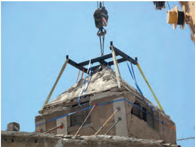
Figura 12. Apuntalamiento de la torre y sujeción de la cubierta de madera.
