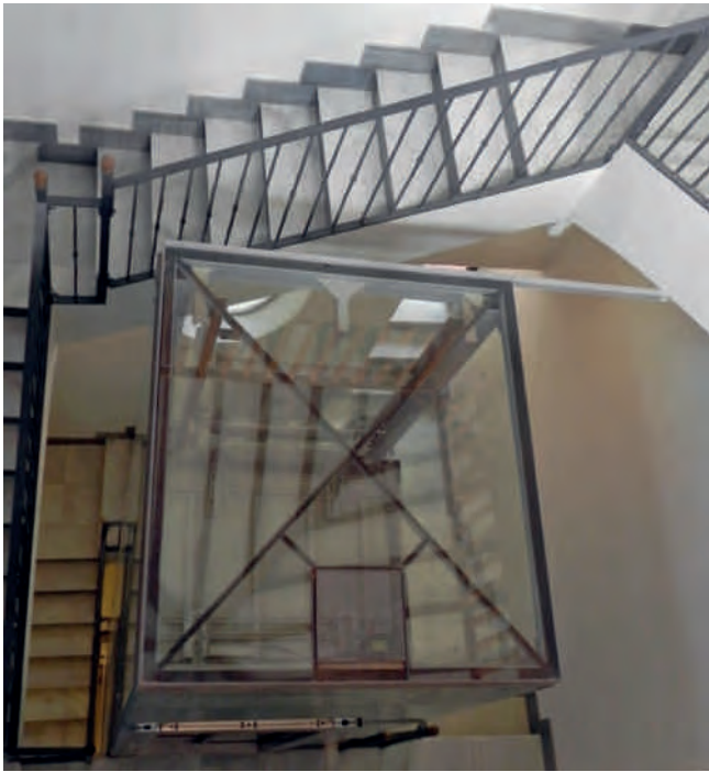
Figura 11. Parte superior de la estructura de vidrio que envuelve el ascensor, colocada en el hueco de la escalera, sin afectar ninguna de las estructuras ni niveles superiores, además de no interferir la entrada de luz, ni modificar zancas, barandillas, descansillos, etc. Fotografía: J. de Dios de la Hoz.
