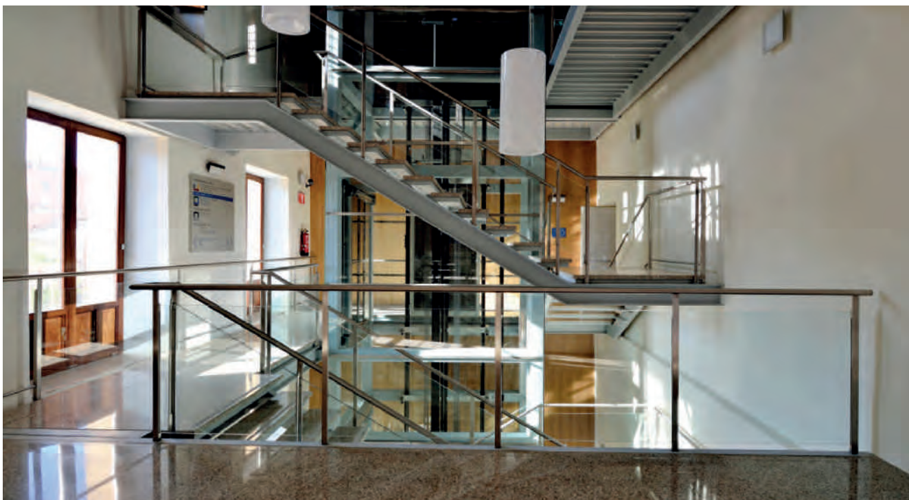
Figura 9. Fotografía del nuevo núcleo de comunicaciones con ascensor que garantiza la accesibilidad y escalera protegida. Fotografía: Joaquín Zamora.
