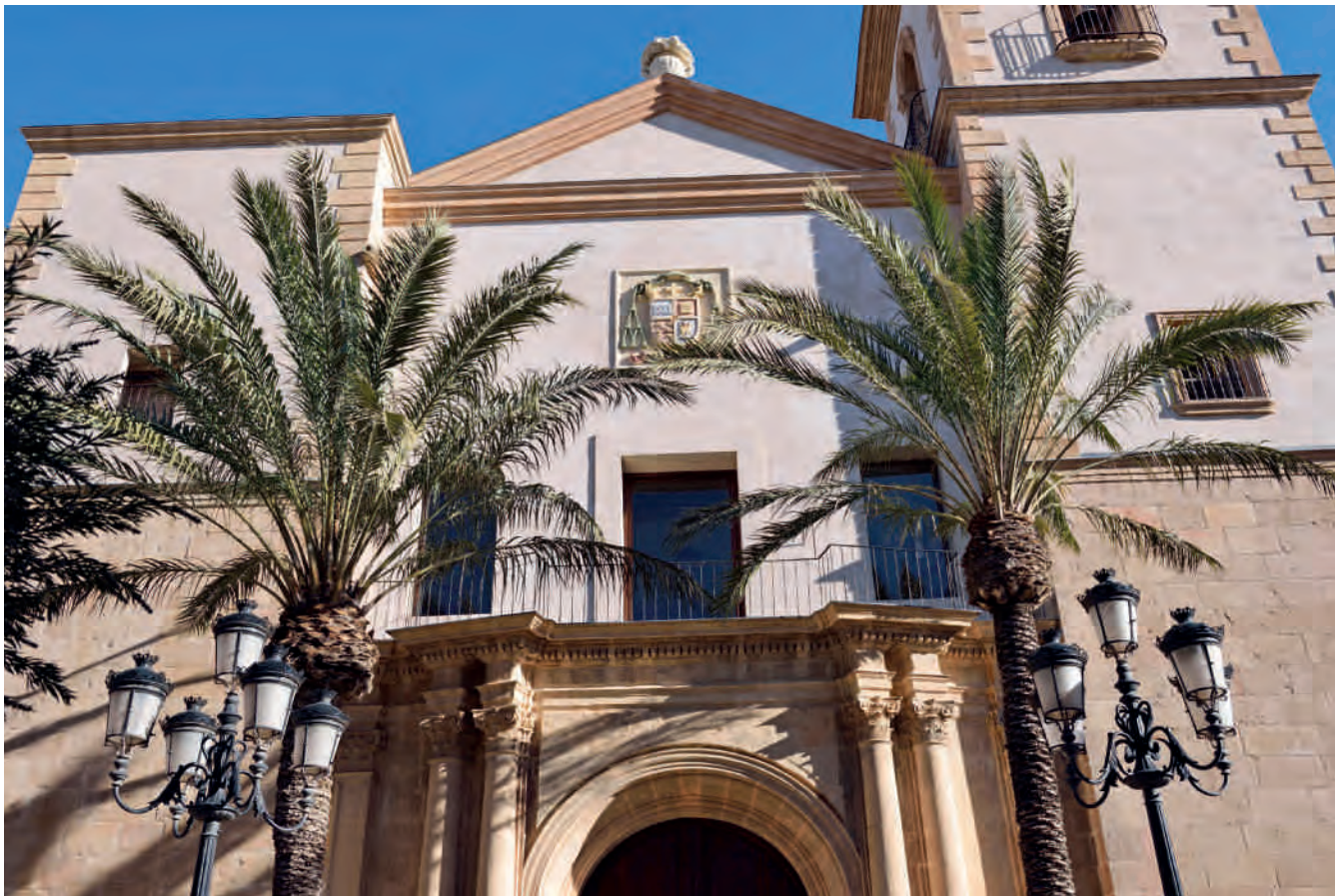
Figura 10. Detalle de la fachada principal, con la recuperación de huecos antiguos, el escudo episcopal y el remate sobre los dos planos inclinados de evacuación de las aguas, así como la recuperación de toda la sillería. Fotografía: Joaquín Zamora.
