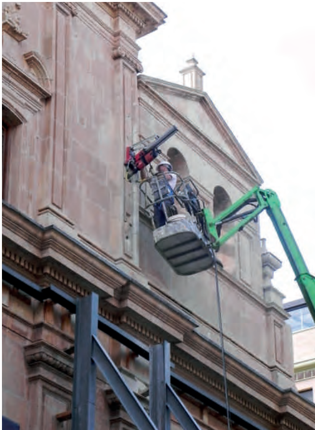
Figura 6. Trabajos para la ejecución de los taladros desde el exterior de la fachada (longitud media, 9 m), para conectarla con los muros perpendiculares a ella. Fotografía: Juan de Dios de la Hoz.
