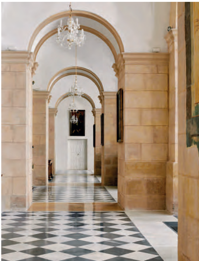
Figura 14A. Imagen con el estado de los paramentos y solados una vez recuperadas las fábricas de sillería y ejecutados los trabajos de pintura y patinado. Fotografía: Joaquín Zamora.
