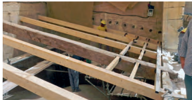
Figura 19. Desmontaje de las estructuras metálicas y losas de hormigón, sustituyéndolas por vigas y viguetas de madera, manteniendo en todos los casos las grandes escuadrías leñosas originales. Fotografías: Juan de Dios de la Hoz.
