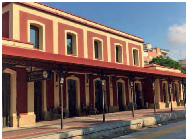
Figuras 13 y 14. La estación de Renfe-Sutullena tras el terremoto y después de su recuperación con la rehabilitación de ADIF. Fotografías: F. J. G. a Carreras.
