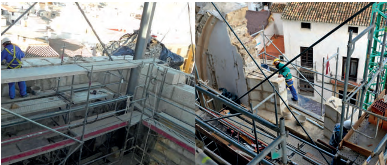
Figuras 12. Trabajos de reconstrucción de los muros laterales del crucero, donde se han utilizado tanto sillares recuperados de entre los escombros, como sillares ejecutados en obra (encofrados) a base de mortero de cal y arena procedente de la piedra triturada. Fotografías: Juan de Dios de la Hoz.
