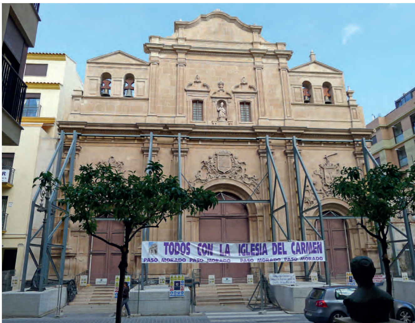
Figura 3. Iglesia del Carmen Estabilización de su fachada principal. Fotografía: SPH. CARM.
