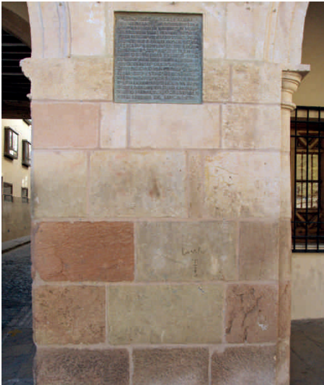
Figura 12. Recomposición de sillares.
