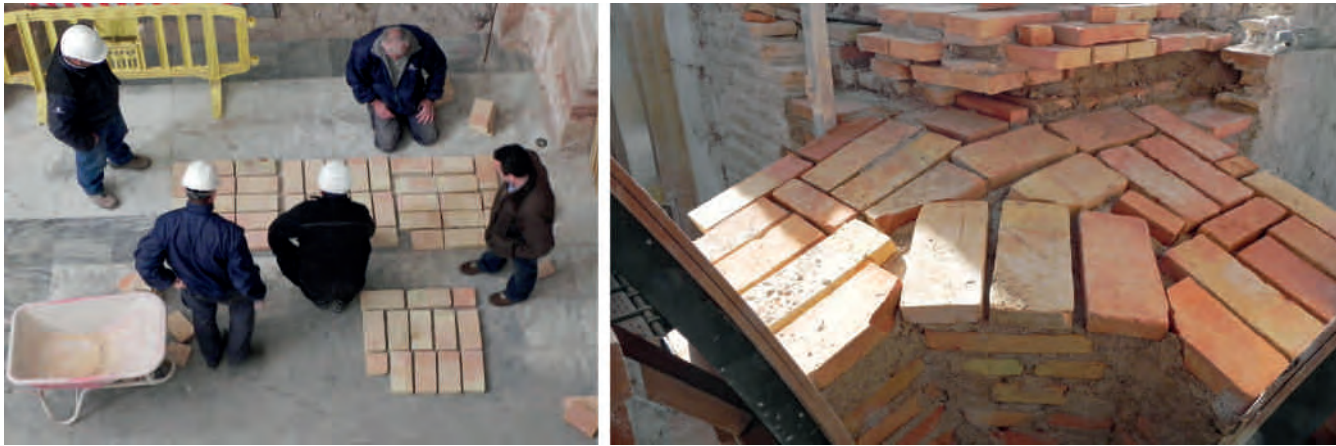
Figuras 13. Replanteo de hiladas en el suelo (izquierda) y del arranque de los arcos formeros del crucero, configurando una de las pechinas (derecha). Fotografías: Juan de Dios de la Hoz.
