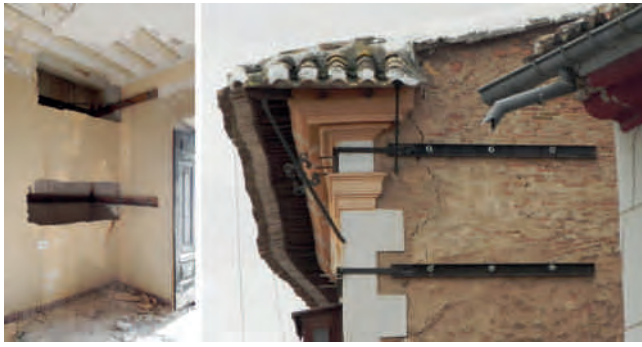
Figura 6. Imágenes por el interior y exterior del edificio, de los refuerzos metálicos colocados en las esquinas, que permitían el tesado de cada barra. Fotografías: Juan de Dios de la Hoz.
