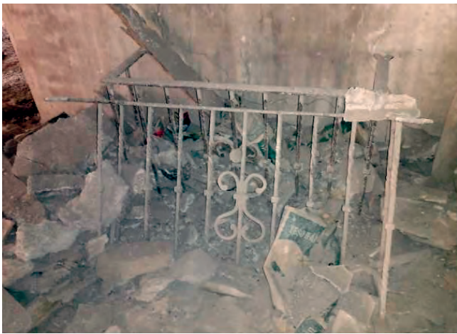
Figura 26. Restos de cerrajería de balcones que pudieran ser los originales, aunque en las fotografías antiguas parecen ser de forja de mayor valor.
