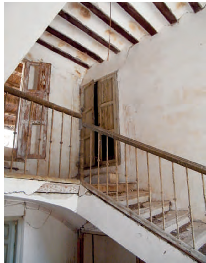
Figura 19. Detalle de escalera en planta segunda.
