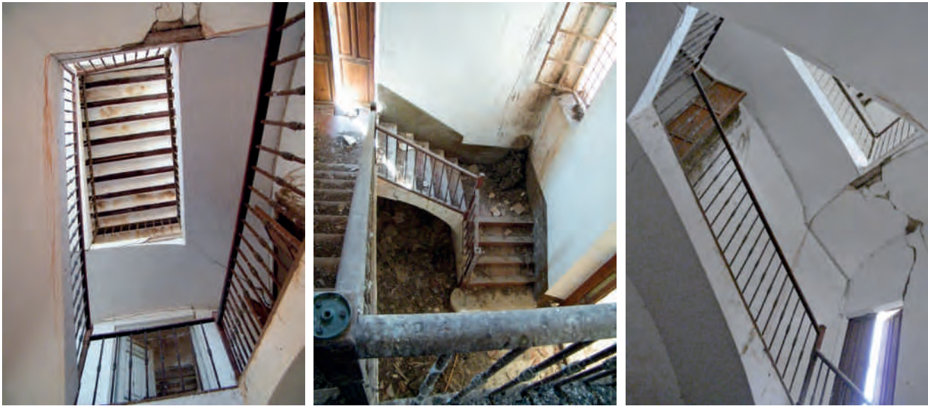
Figuras 4, 5 y 6. Detalles de escalera estado actual.
