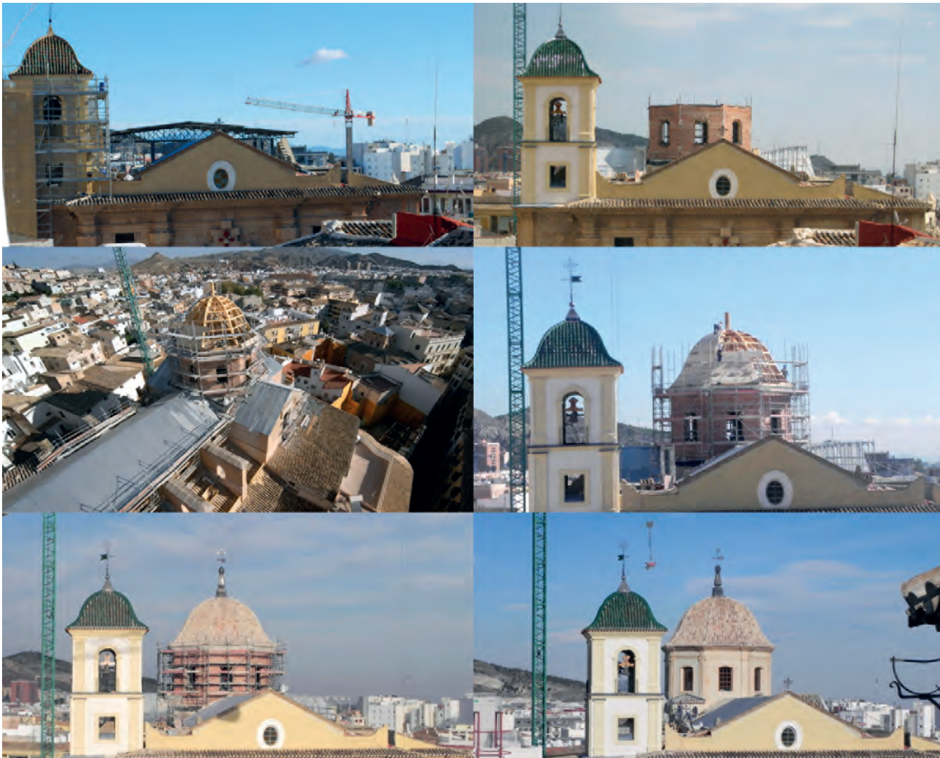
Figuras 16. Proceso de construcción del tambor y estructura de la cúpula, a partir de la retirada de la estructura metálica de protección, ejecución de los arcos y resto de estructura, levantado del tambor, estructura de madera de cubrición, cúpula de madera y remate final con entablado y teja. Fotografías: Juan de Dios de la Hoz.
