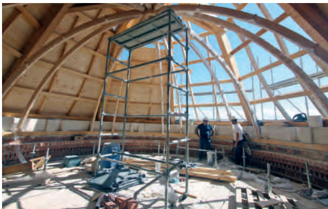
Figuras 18. Estructura de la otra gran armadura, vista por el intradós, correspondiente a la cúpula de madera (tras ellas se ve igualmente el intradós de la de la cubierta). Fotografía: Carmen Martínez Ríos.
