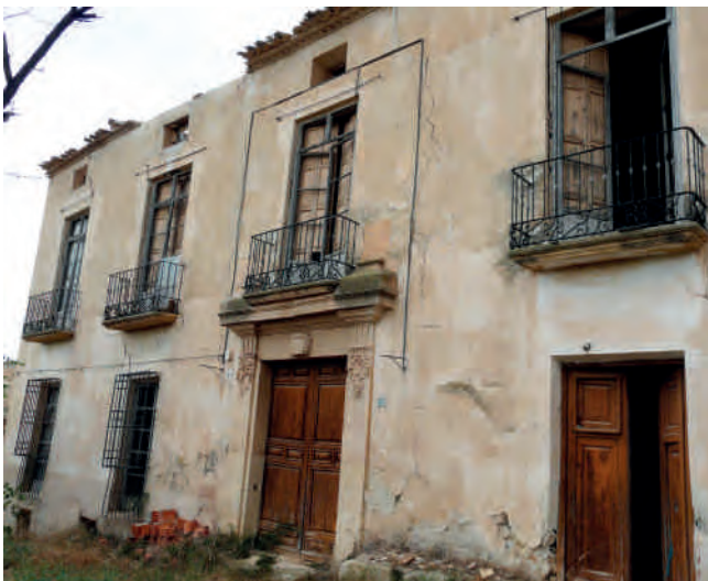
Figura 15. Estado actual de la fachada del inmueble principal.
