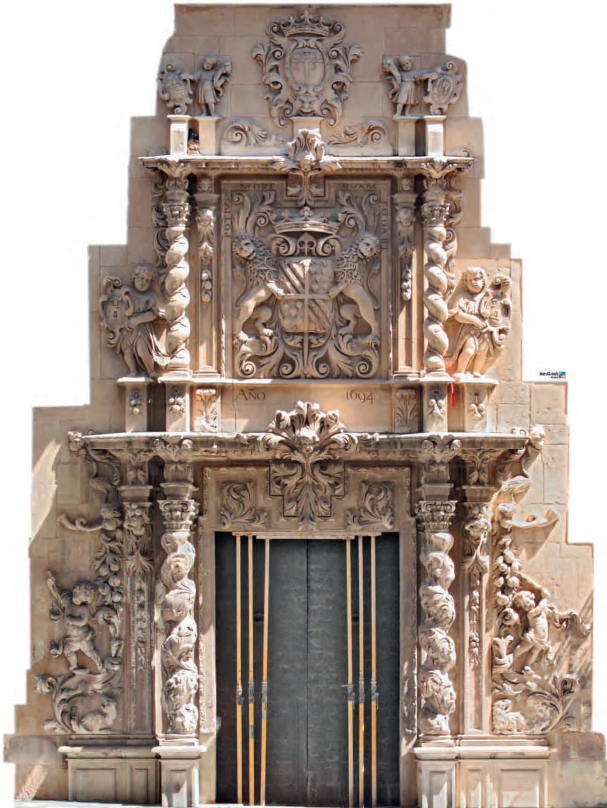
Figura 1. Portada de piedra de la fachada principal.
