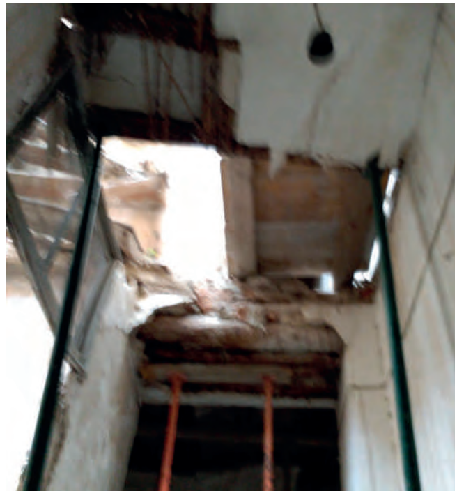
Figura 14. Forjado de estancia almacén desde despensa a escalera de servicio.
