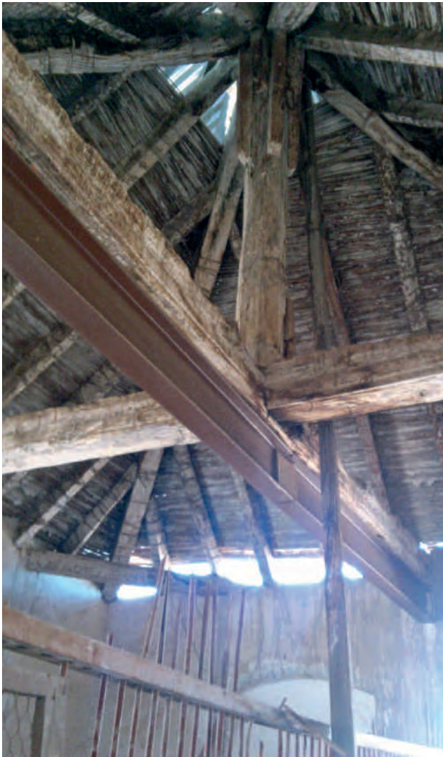
Figura 14. Estructura de torreón original, apeado.
