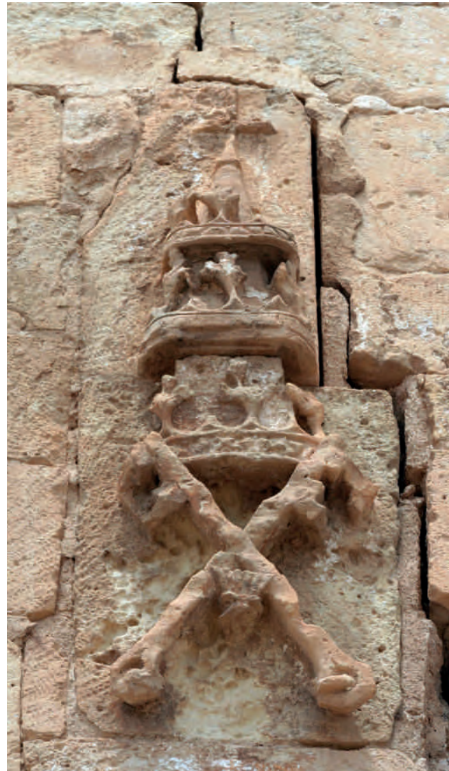
Figura 4. Grieta en portada gótica de la iglesia de San Pedro.
