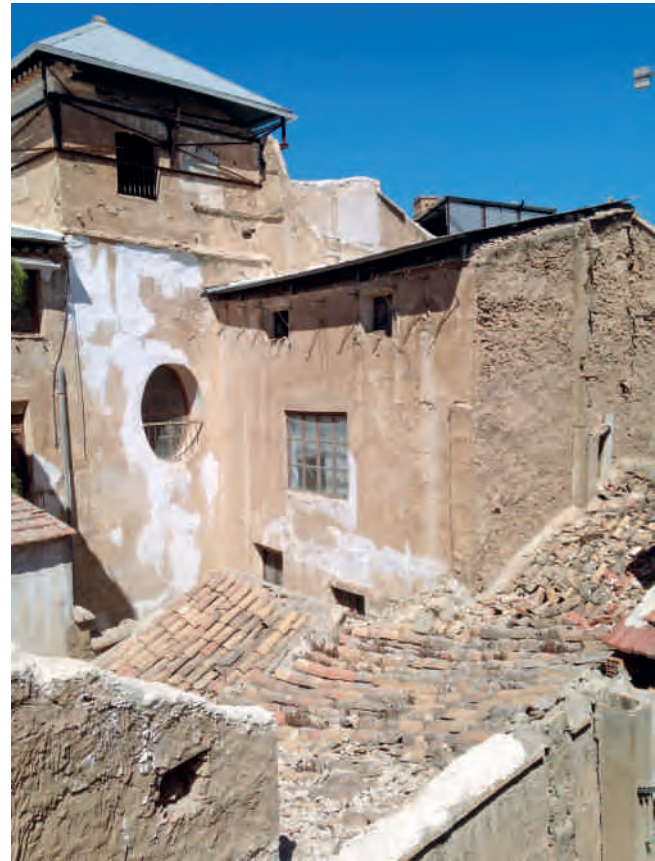
Figura 13. Chapas de protección de torreón y resto de cubiertas que se realizaron como actuación de emergencia.
