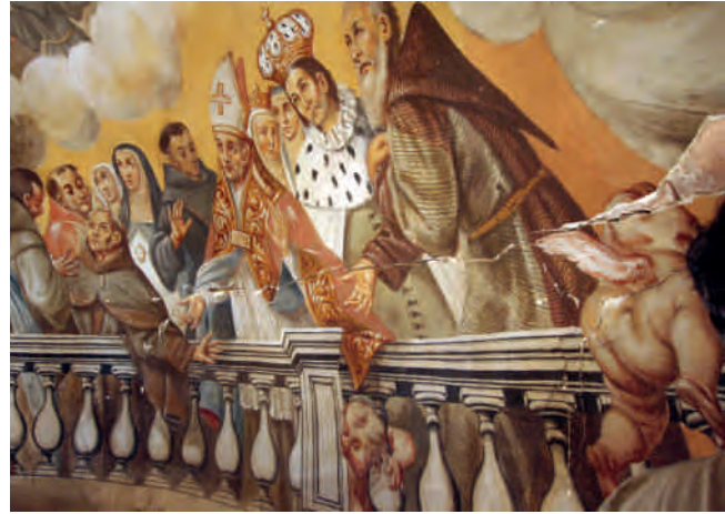
Figura 8. Daños en la cúpula de Virgen de las Huertas.
