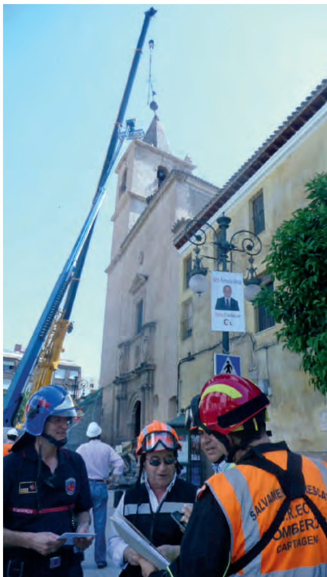
Figura 11. Actuaciones de emergencia en la iglesia de San Francisco.
