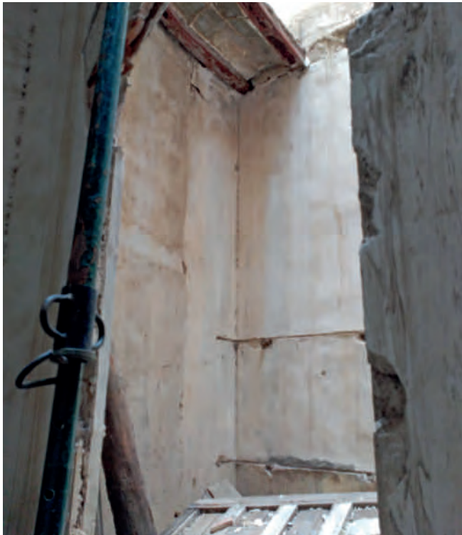
Figura 11. Forjado de estancia de almacén desde despensa a escalera de servicio.
