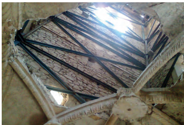
Figura 8. Apeos estructurales del interior de la torre
