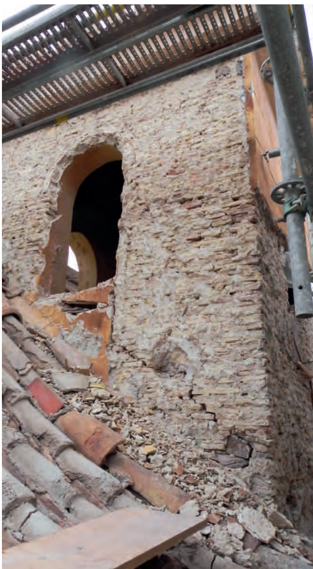
Figura 3. Fotografía: una de las esquinas de la torre, donde se aprecia cómo la misma se fracturó en dos grandes trozos, por la aparición de fisuras inclinadas paralelas a los faldones, aunque afortunadamente no llegó a producirse su desplome. Fotografía: Luis de la Hoz.
