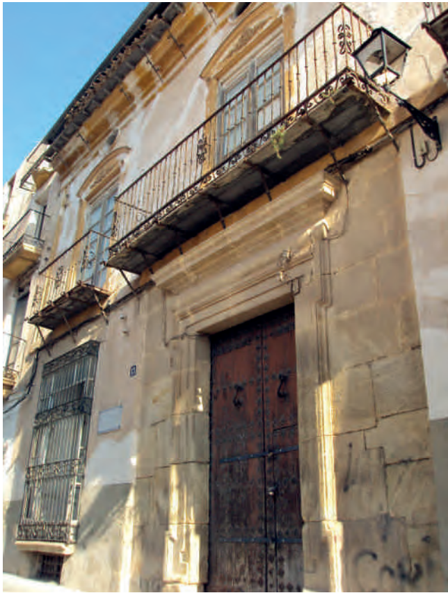
Figura 2. Acceso principal a la calle Selgas.
