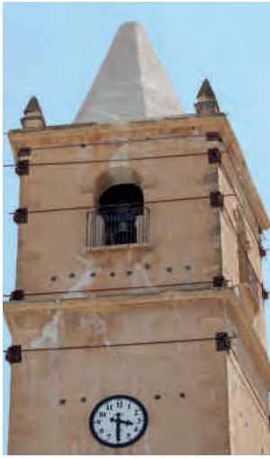
Figura 11. Arriostramiento de la torre de la iglesia de San Francisco.
