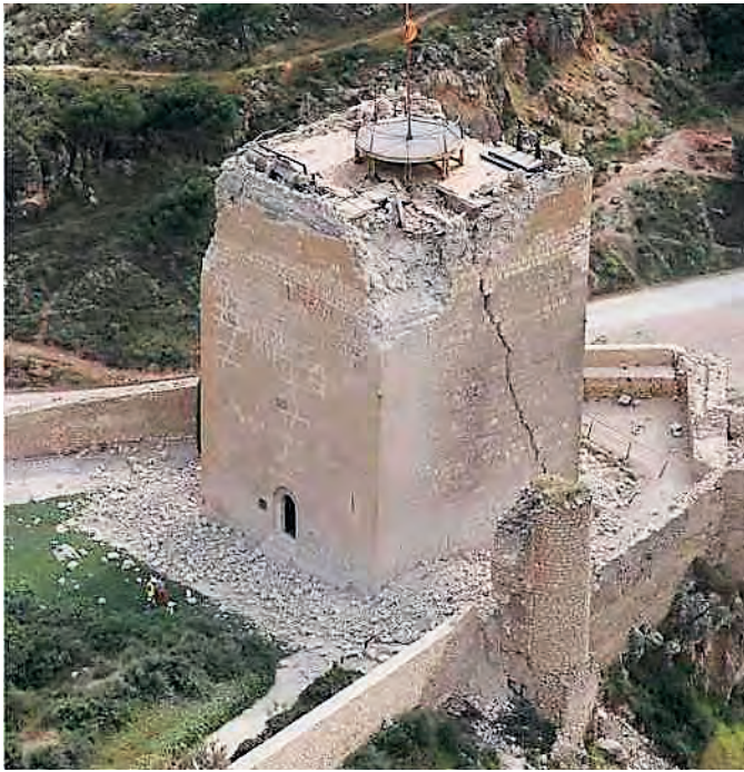
Figuras 12 y 13. Imagen aérea tras el segundo movimiento sísmico y esquema volumétrico donde se evalúan de un modo aproximado las masas desprendidas (250 t) y desplazadas (500 t) por el seísmo.
