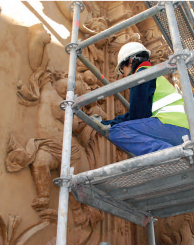
Figura 10. Trabajos de restauración de la portada.
