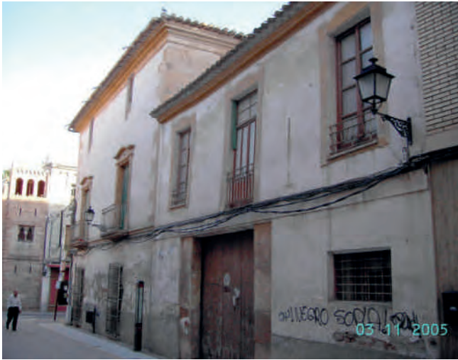
Figura 3. Edificación secundaria con fachada a calle Pío XII.
