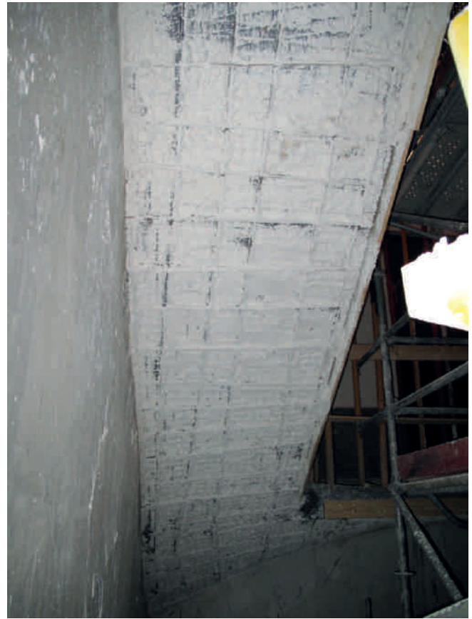
Figura 6. Proyección de hormigón en dos tongadas y en días sucesivos.
