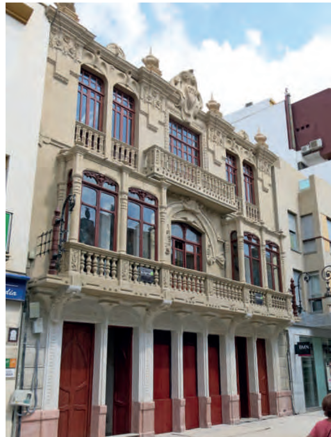
Figura 5. Fachada actual. Después de la intervención.
