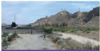
1 y 2. Huertas río arriba. Existe una mota en la margen izquierda, que se encuentra en relativo buen estado y que permite el paseo entre las huertas y el río. Sin embargo dicha mota no está bien conectada para poder llegar a la ciudad por ella. En la margen derecha (2), sin embargo, no existe mota en este tramo.
