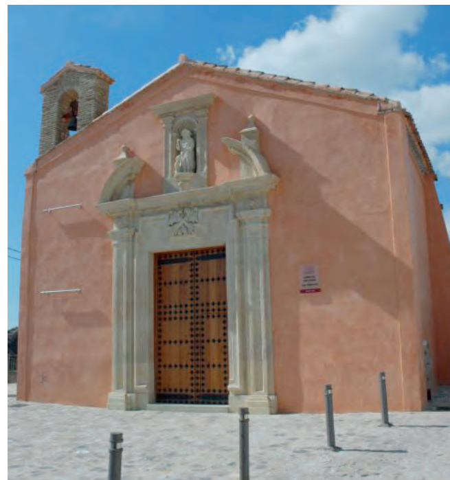
Figura 10. Fachada principal de la ermita de San Roque.
