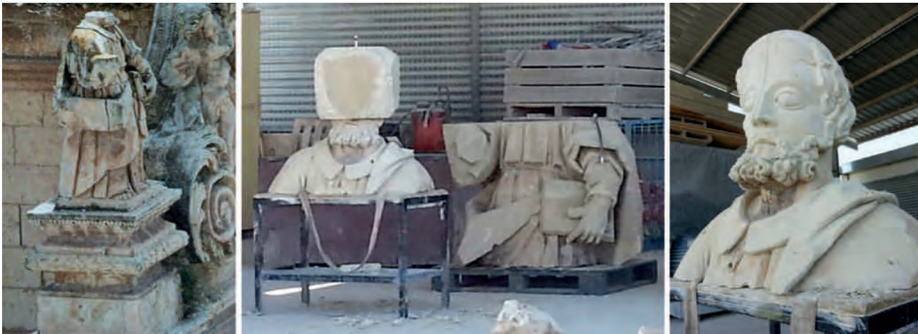
Figura 22. Escultura del lateral del Evangelio de la colegiata, en su estado anterior a las obras y durante las mismas, completando las grandes faltas con sillería de piedra tallada en bajo nivel. Fotografía: Juan de Dios de la Hoz.
