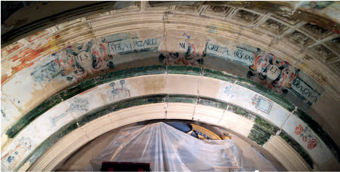
Figura 29. Interior de la capilla de la Virgen del Alcázar, con las catas realizadas sobre los arcos, paramentos, molduras, capiteles y cornisas en las que se aprecian los restos de pintura con leyendas y decoraciones representando atributos de la letania Lauretana, así como tapicerías con motivos geométricos y vegetales, con marmoleados en los elementos arquitectónicos. Fotografía: Juan de Dios de la Hoz.
