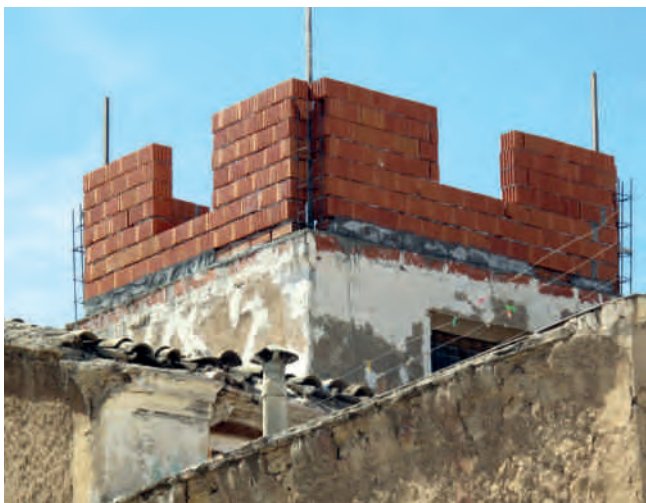
Figura 16. Construcción de nueva fábrica para la torre.
