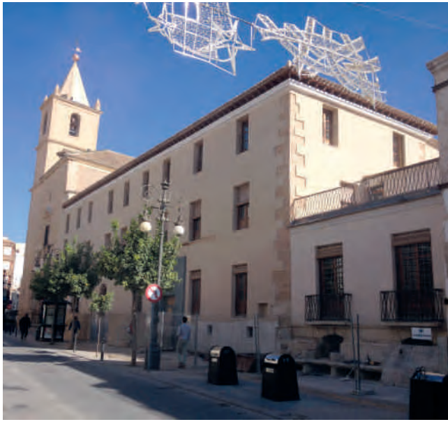
Figura 11. Vista fachada del colegio tras la retirada de andamios.
