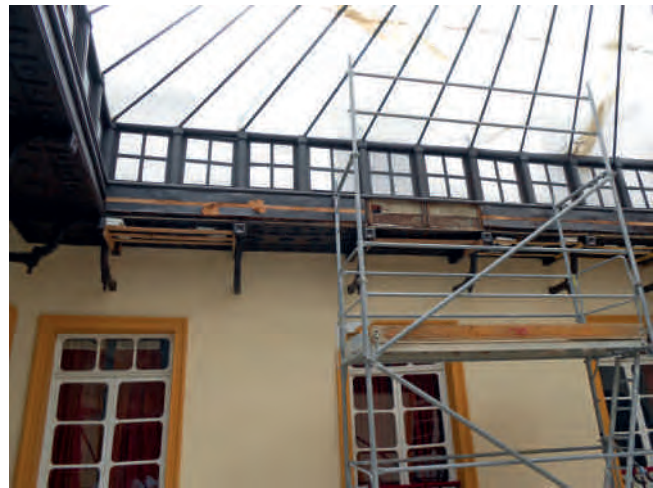
Figura 19. Detalle lucernario del hall de acceso.
