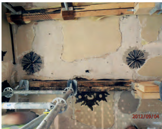
Figura 7. Proceso general de consolidación de bóvedas. Fotografías: JCC.
