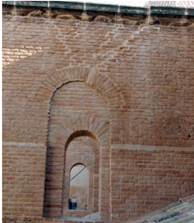
Figuras 20. A la derecha, contrafuertes sobre la nave del Evangelio, en su estado tras los seísmos (izquierda) y una vez reparado y completada su base e interior del hueco central (derecha), para disminuir su vulnerabilidad. Fotografías: Juan de Dios de la Hoz.
