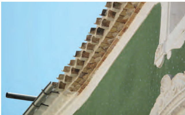
Figura 2. Alero recompuesto siguiendo la misma composición que el original.
