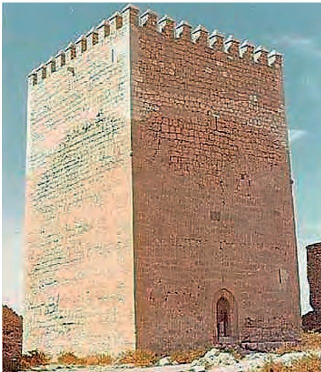
Figuras 10a. La torre una vez acabada su intervención. Fotografía: Pedro San Martín.
