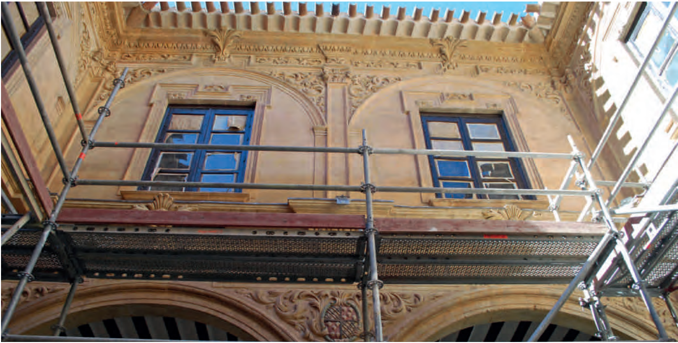
Figura 9. Restauración de las fachadas del patio principal.
