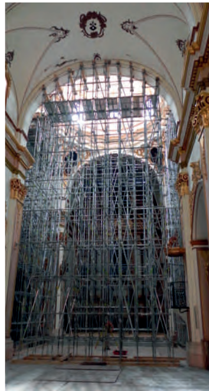
Figura 17 y 18. Detalle de las enormes grietas que provocó el terremoto en las bóvedas del crucero y uno de los grandes andamios colocados para el apeo de los arcos y bóvedas del crucero. Fotografías: Juan de Dios de la Hoz.
