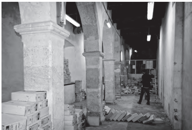
Figura 14. Interior de la planta baja del pósito de Panaderos, estado actual.
