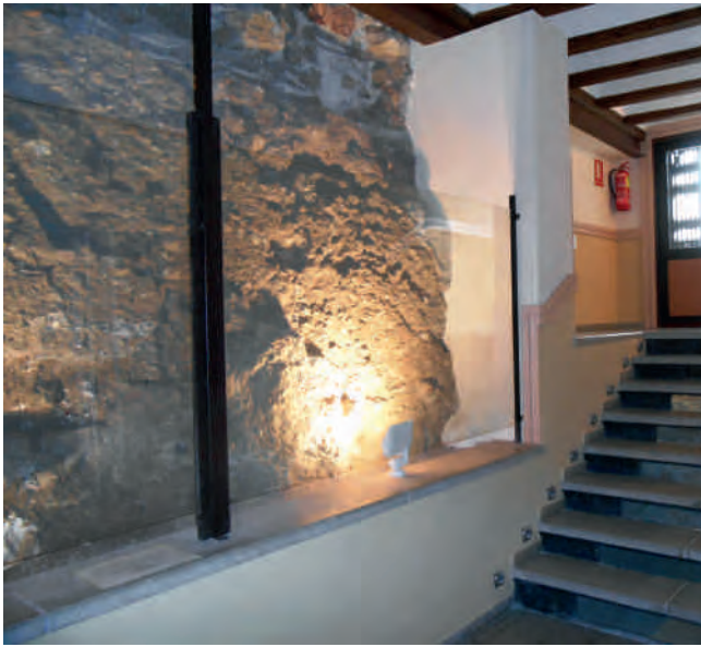
Figura 14. Tramo de la muralla árabe integrado en el acceso al salón de actos.
