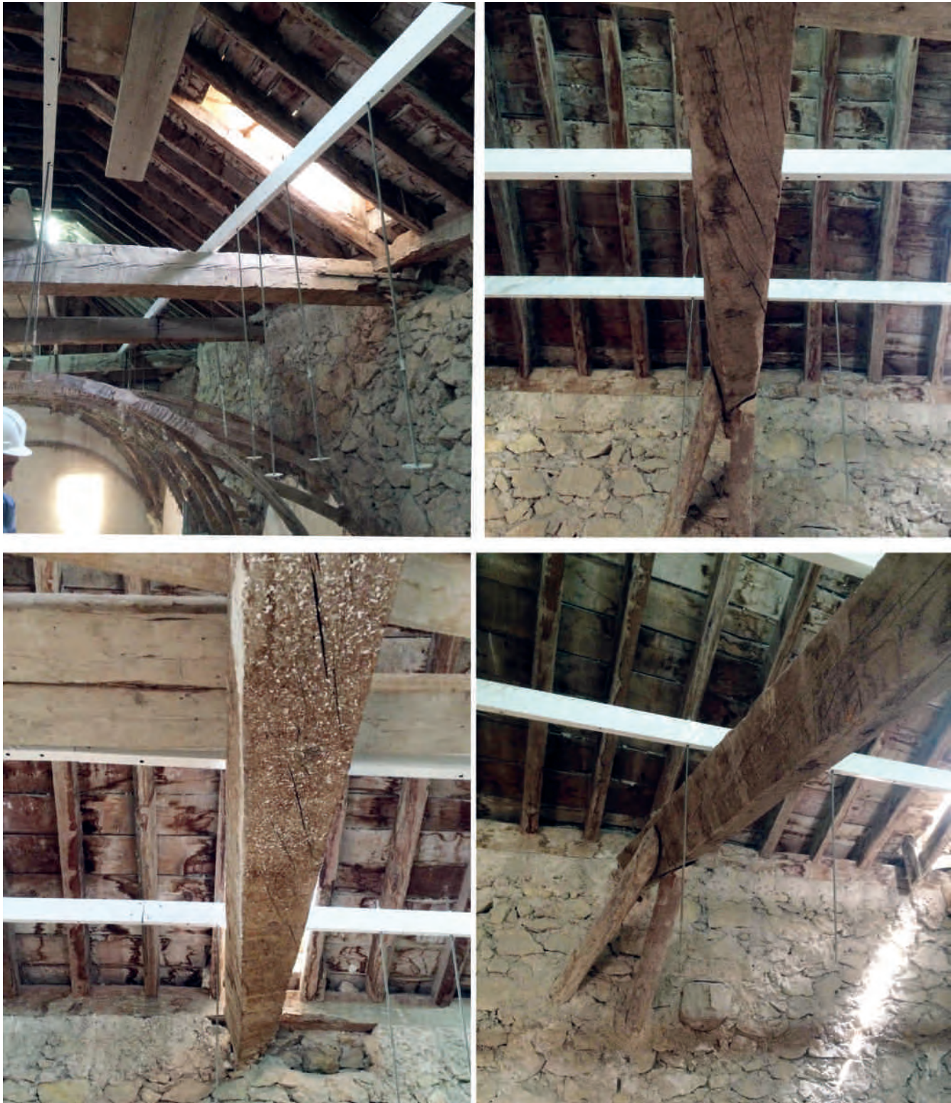
Figura 10. Diversos detalles del trasdós de la bóveda encamionada de la nave central, con grandes pérdidas de material leñoso, así como reparaciones mediante elementos metálicos y de aluminio. Incluso algunos de los tirantes se encontraban en tan mal estado, que prácticamente habían desaparecido, provocando riesgos críticos de desplome. Fotografías: Luis de la Hoz.
