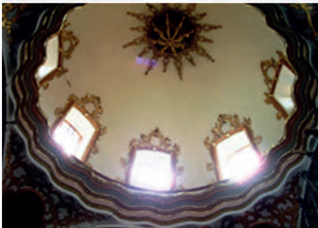
Figura 12. Estado de la iglesia del convento del Carmen antes del terremoto de 2011. Fotografía: Pedro Segado.
