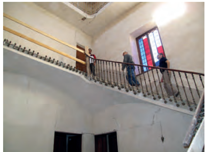
Figura 8. Aspecto final de la escalera ya reforzada y restaurada. Con este sistema se consigue mantener la escalera original que ahora queda sopandada por la lámina de hormigón armado que la soporta que de alguna manera también trabaja en arco.
