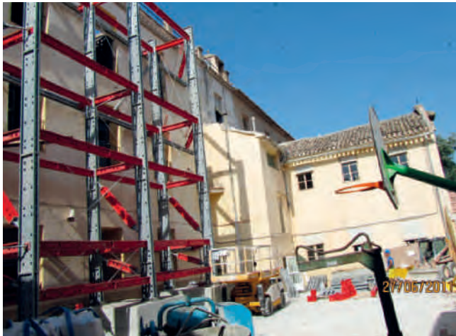
Figura 4. Estabilización de muros en el exterior.
