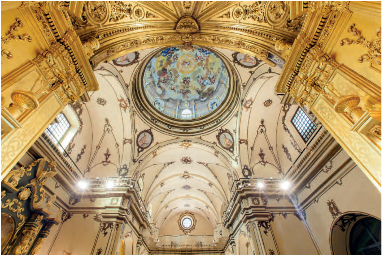
Figura 10. Imagen del interior de la capilla del Rosario tras las obras de restauración. Fotografía: JCC.
