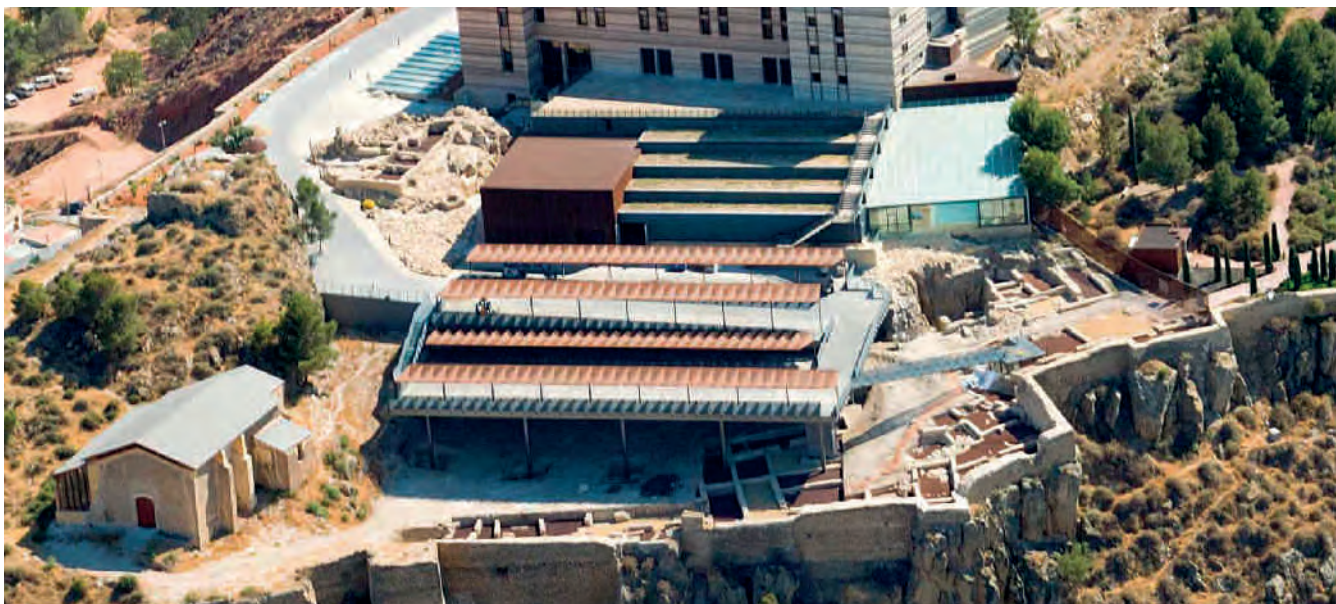
Figura 59. En el centro de la imagen la caja de acero cortén que aloja los restos de la sinagoga.
