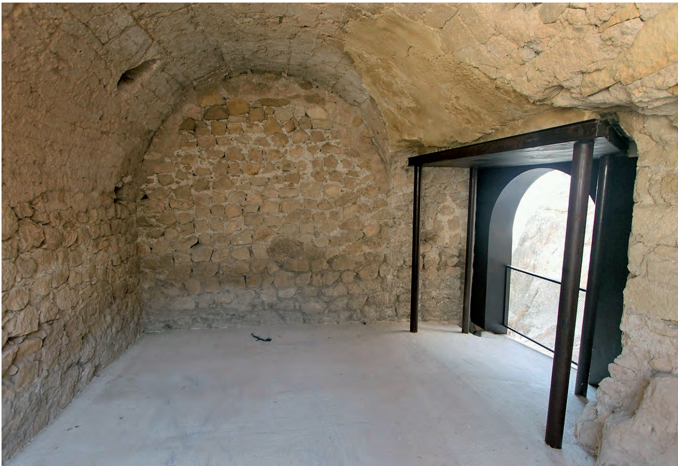
Figura 51. Interior del cubo restaurado con la puerta del Pescado recuperada y convertida en un balcón hacia el valle, al haber desaparecido toda traza del camino que subía por la falda de la montaña hacia ella.
