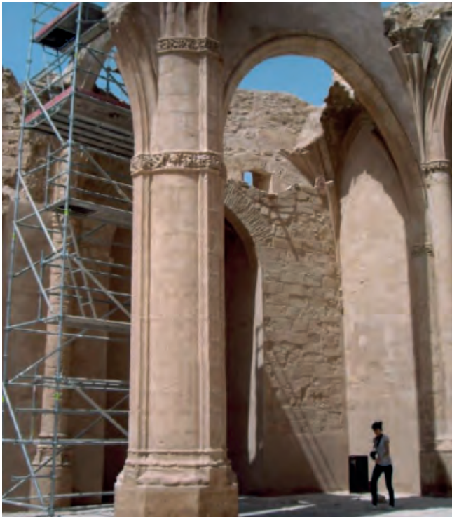
Figura 2. Pilar interior nave central.
