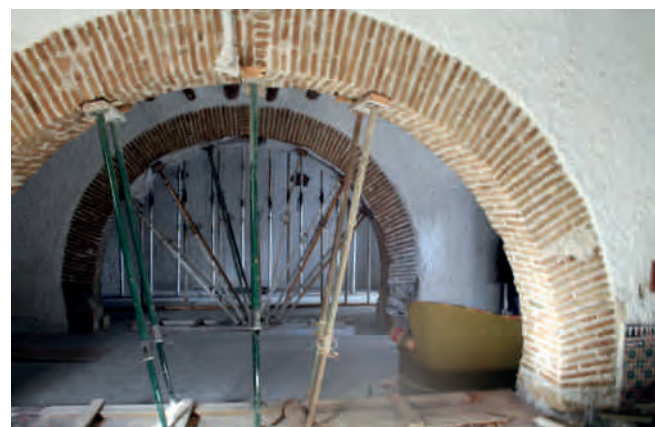
Figura 7. Apeos de arcos interiores de ladrillo.
