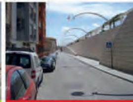
10. Pérgola sobreelevado. Esta gran pérgola maciza en la margen izquierda supone una barrera no sólo visual, sino también física dado que no está a la altura ni de la calle ni del puente de San Cristóbal, con lo cual genera grandes problemas de accesibilidad y un enorme impacto visual.
