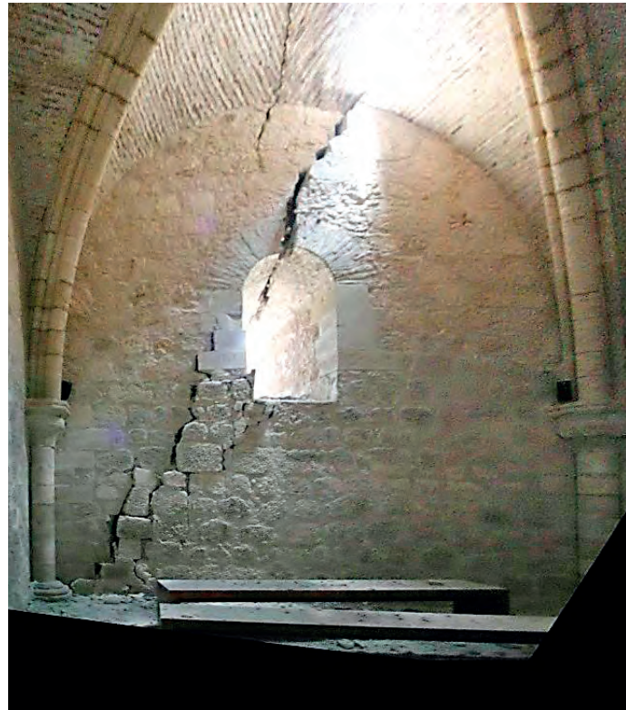
Figuras 14 y 15. En el interior la rotura más ostensible se sitúa en el recinto superior, uniendo las grietas los puntos más débiles de ventanas y hueco de escalera.
