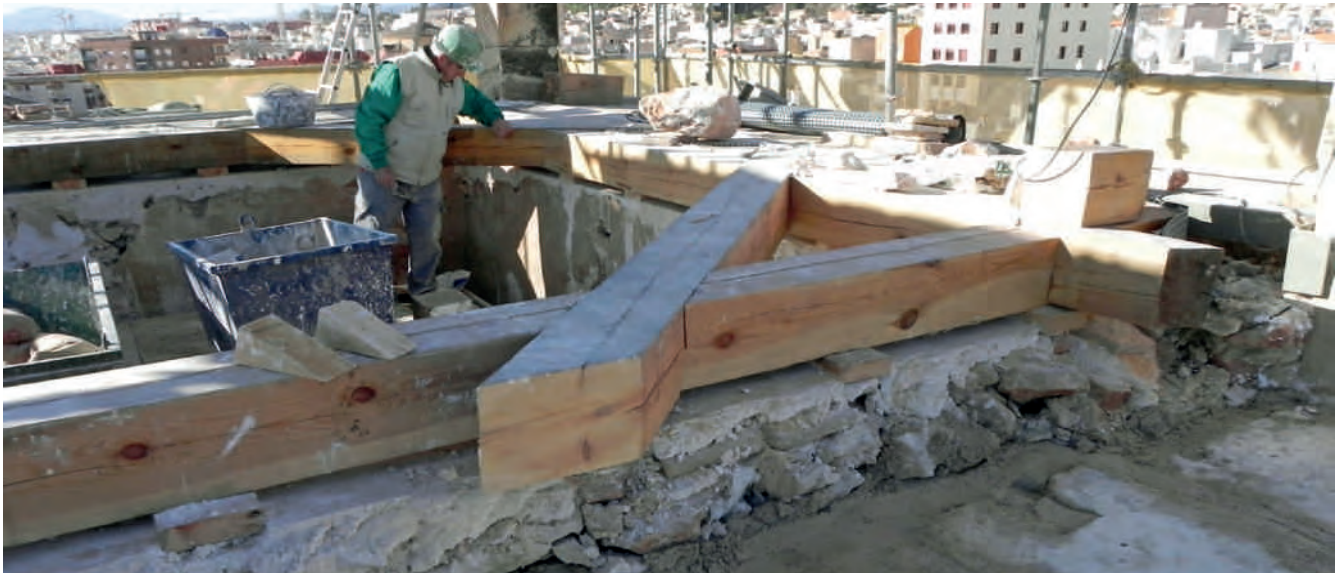
Figura 8. Instalación de los durmientes y cuadrales de madera ensamblados a media madera, como apoyo de la estructura octogonal de remate del chapitel de la torre. Fotografía: Juan de Dios de la Hoz.
