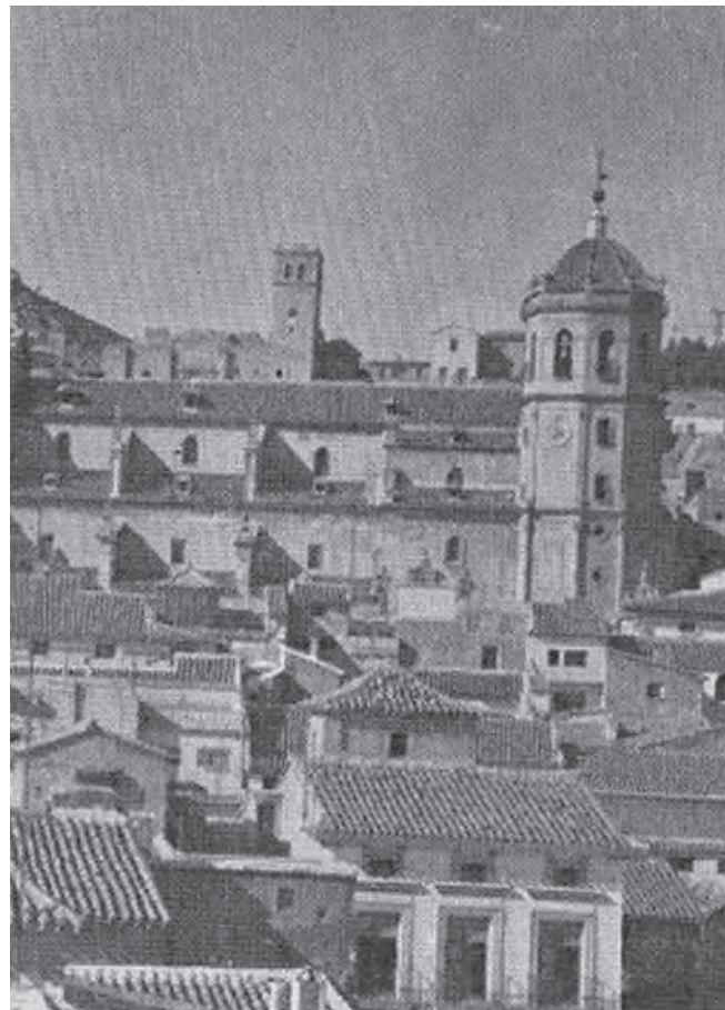
Figura 15. Fotografía: en torno a 1940 correspondiente a la fachada sur de la colegiata. Son importantes varios aspectos de esta foto, pero sobre todo los dos aleros inferiores de las cornisas, que se encuentran cubiertos de teja.
