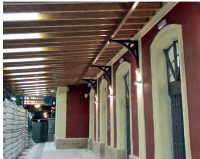
Figura 9. Marquesina de andén reconstruida. Fotografía: F. J. García Carreras.
