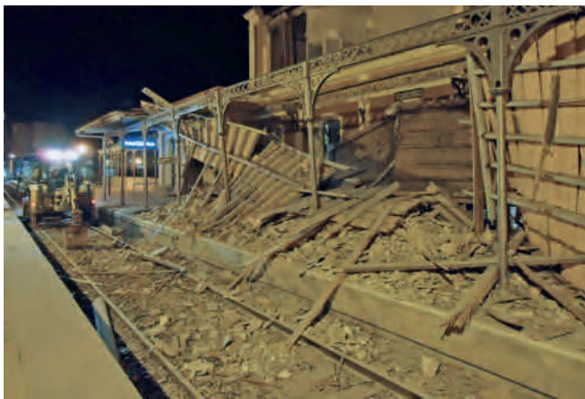
Figura 2. Imagen de la noche del terremoto, con el andén y la vía invadida por el escombros. Fotografía F. J. García Carreras.
