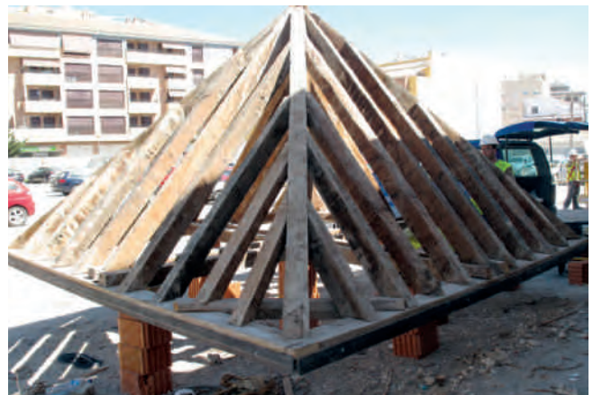
Figura 15. Saneado de la estructura.
