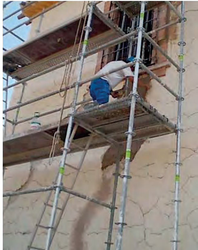
Figuras 30 y 31. Retirada del apeo exterior de la esquina noroeste con grúa móvil y restañado de las grietas (la fachada sigue presentando el craquelado anterior al terremoto, sobre el que no se intervino).
