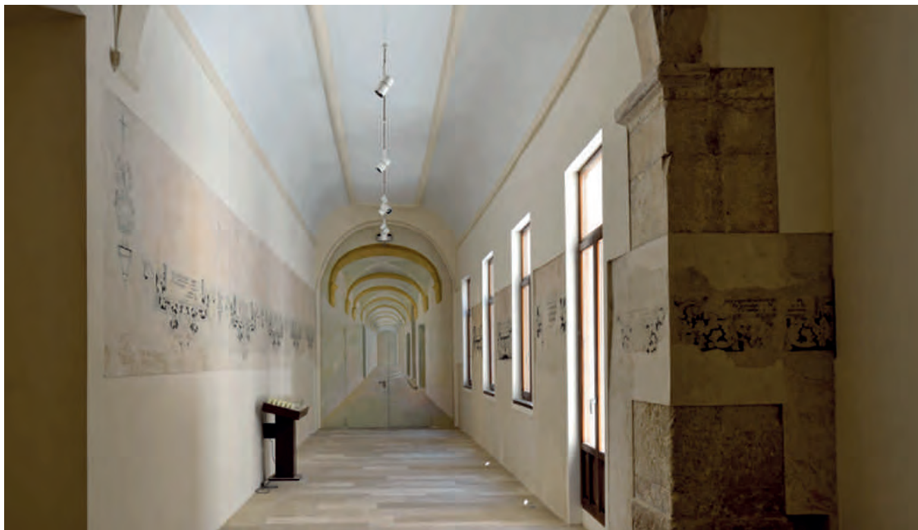
Figura 5. Fotografía del carrerón tras los trabajos de restauración, con las pinturas murales recuperadas a ambos lados y trampantojo al fondo realizado por José Antonio García Bautista. Fotografía: Carmen Martínez Ríos.
