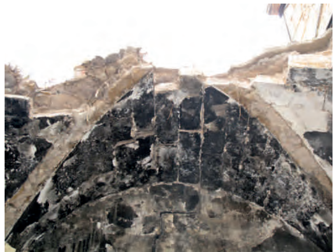
Figura 4. Bóveda de vestíbulo de ingreso a la iglesia parcialmente derruida en más de un 50 %. Imagen tomada el 24 de mayo de 2011. Fotografía: José Manuel Chacón Bulnes.
