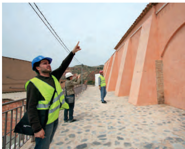
Figuras 13 y 14. Fisuras y grietas en contrafuertes y muros exteriores.
