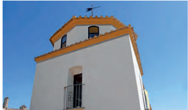
Figura 9. Torreón y tambor de la escalera principal, reparados y zunchados.
