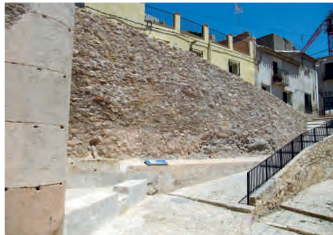
Figuras 7 y 8. Imágenes de la cortina C-26 antes (izquierda) y después (derecha) de la intervención.
