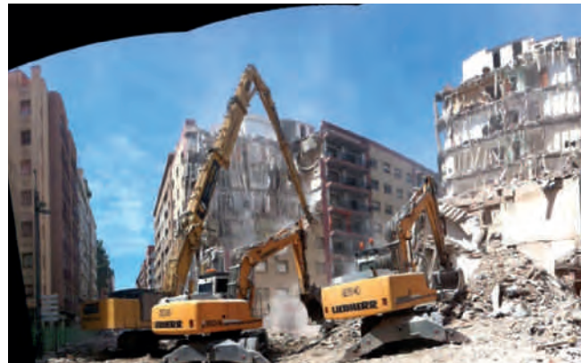
Figura 10. Demolición de la residencia San Mateo.
