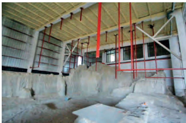
Figura 62. La caja de acero con los restos interiores de la sinagoga protegidos con geotextil. En el momento del seísmo se estaban colocando los tirantes metálicos de los que colgaría la futura estructura de madera.
