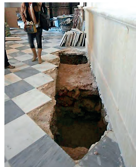
Figuras 48 y 49. Obtención de la posición de la torre desaparecida a partir de proyecciones de las fotografías de 1895 y descubrimiento del cimiento que corrobora su situación y geometría.
