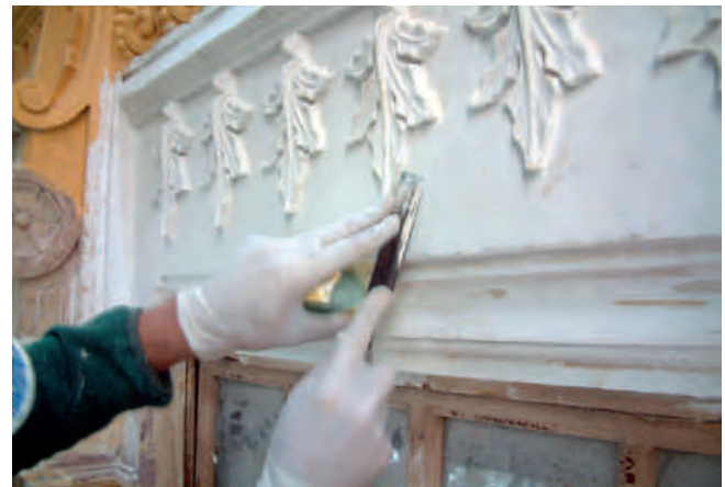
Figura 10. Restauración del dintel de uno de los balcones con hojas de acanto.
