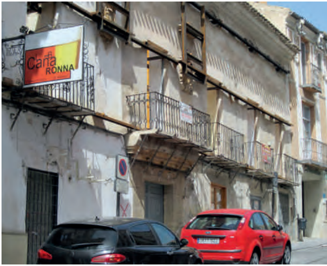
Figura 7. Estado de una edificación tras los trabajos de inspección en un edificio con código rojo y con actuaciones posteriores de derribo y estabilización.
