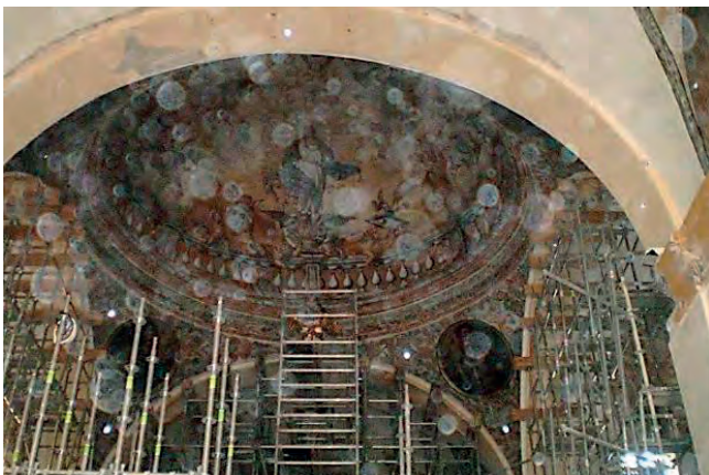
Figuras 25 y 26. Croquis de los cosidos radiales del arco toral y desmontaje de los apeos del crucero.
