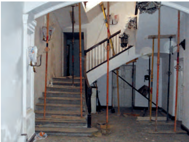
Figura 17. Detalle de la escalera apeada.
