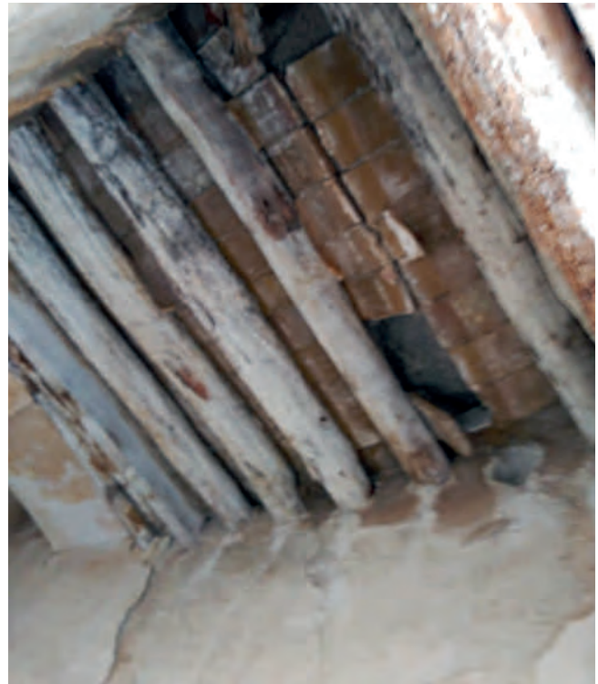
Figura 12. Forjado techo de escalera de acceso a torreón en planta segunda.
