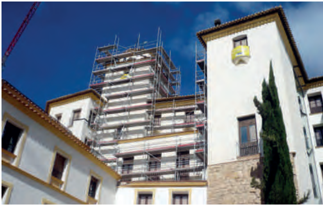
Figura 6. Fachada trasera durante las obras de restauración.
