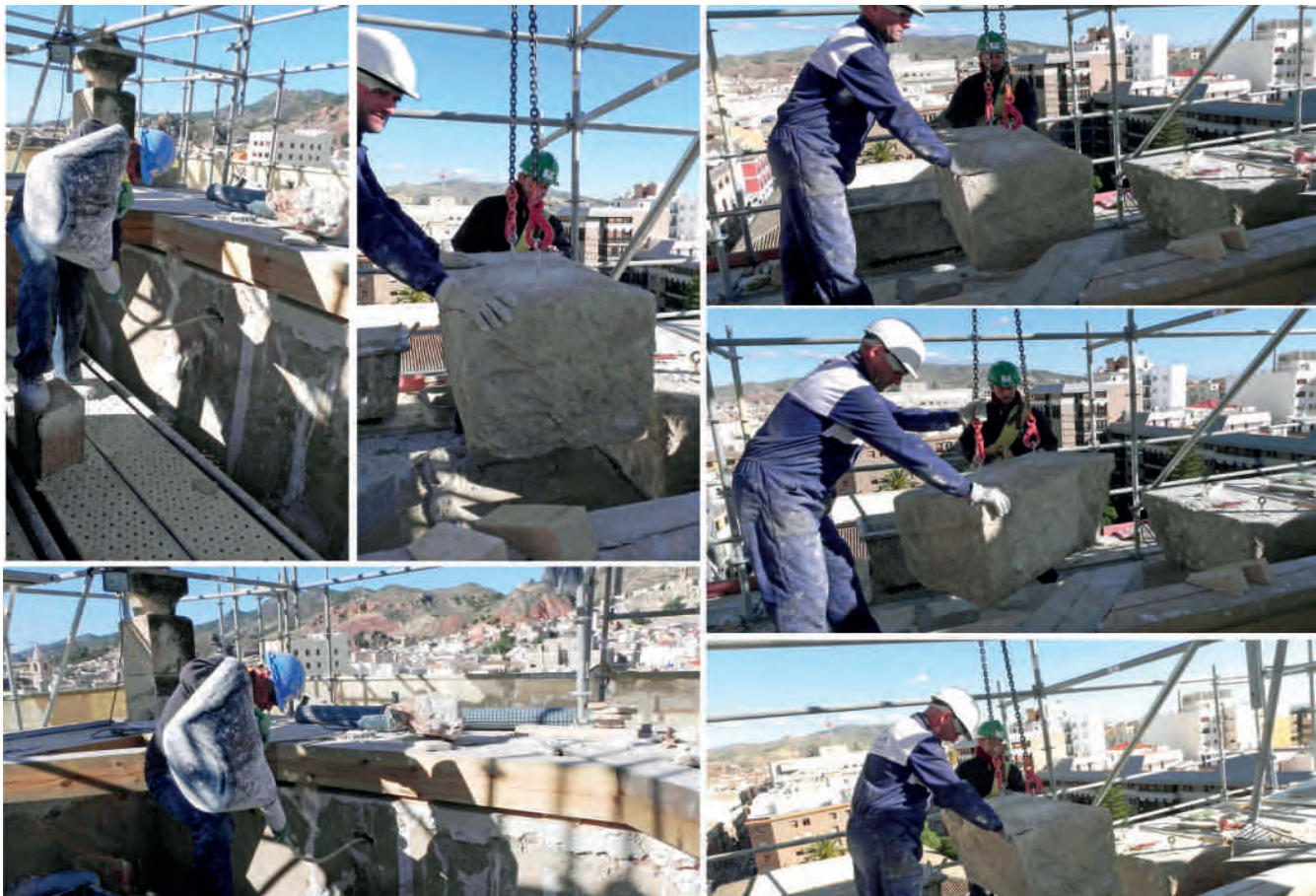
Figura 9. Diversas imágenes de la recolocación de los sillares de la cornisa de la torre, una vez restaurados. Fotografías: Juan de Dios de la Hoz.
