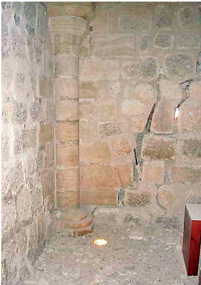
Figuras 16 y 17. Soporte del rincón noroeste de la bóveda superior con un desplazamiento de 15 cm que deja a la basa fuera del fuste y vista de la bóveda superior, de un pie de ladrillo y base de la cubierta, fracturada.
