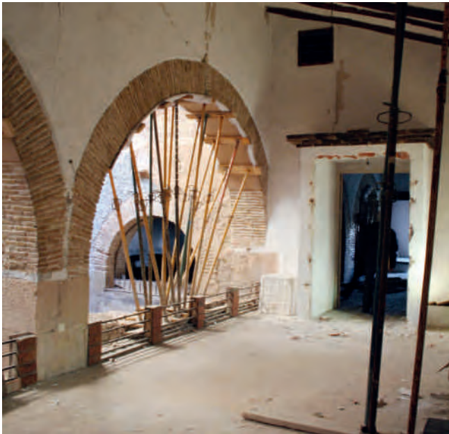
Figura 8. Refuerzo de apeos de arcos de ladrillo planta primera.
