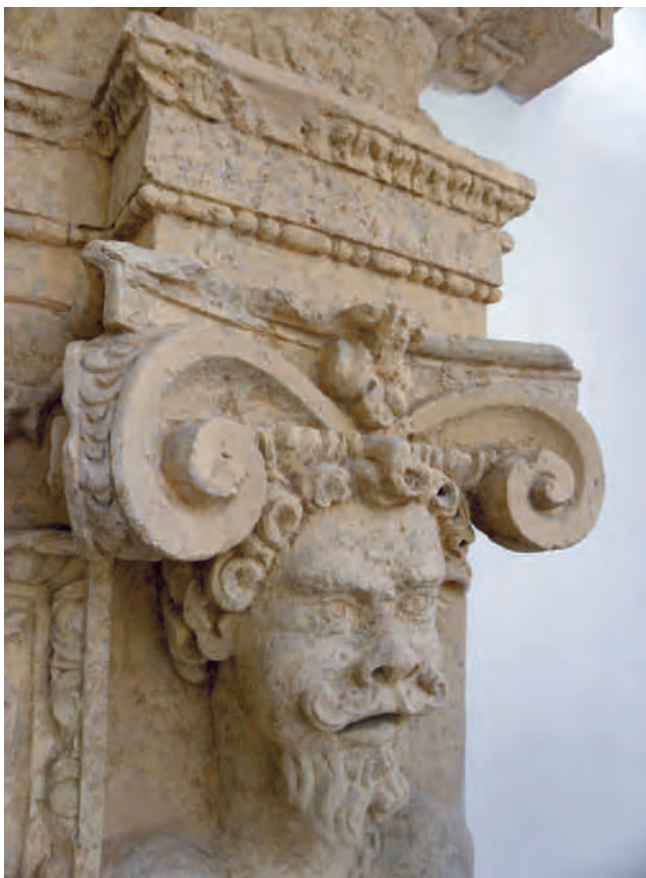
Figura 2. Detalle de la portada del MUAL durante su restauración. Fotografía: Jerónimo Granados.
