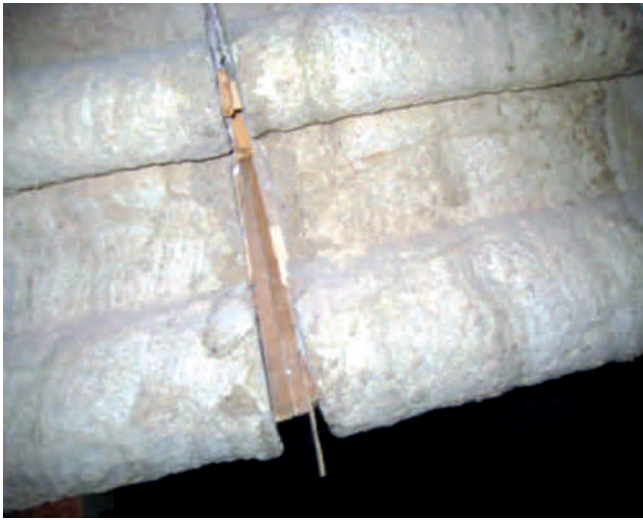
Figura 24. Cuñas de madera introducidas entre dos dovelas para dar continuidad interior tras el cambio de curvatura.
