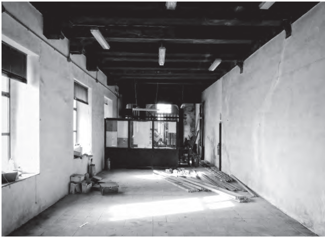
Figura 16. Interior de la planta primera del pósito de Panaderos, estado actual.
