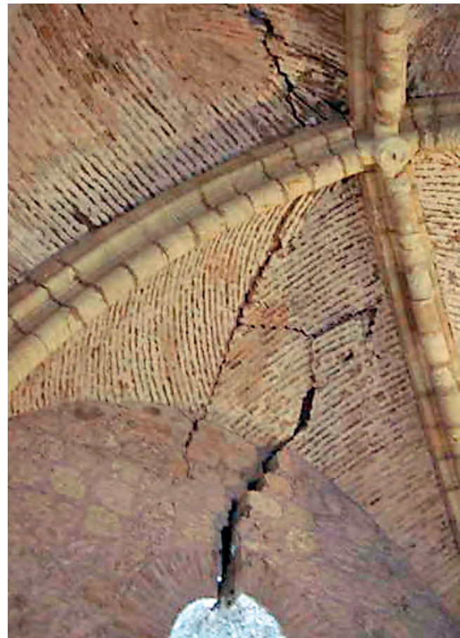
Figuras 16 y 17. Soporte del rincón noroeste de la bóveda superior con un desplazamiento de 15 cm que deja a la basa fuera del fuste y vista de la bóveda superior, de un pie de ladrillo y base de la cubierta, fracturada.
