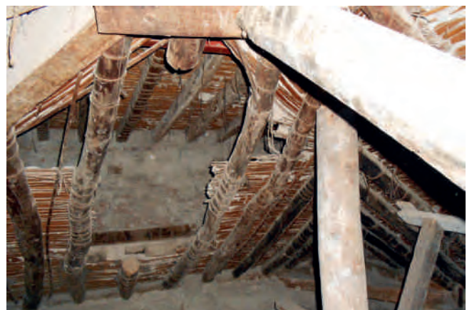
Figura 14. Cubierta del salón de billar, con faldones de cubierta superpuestos.
