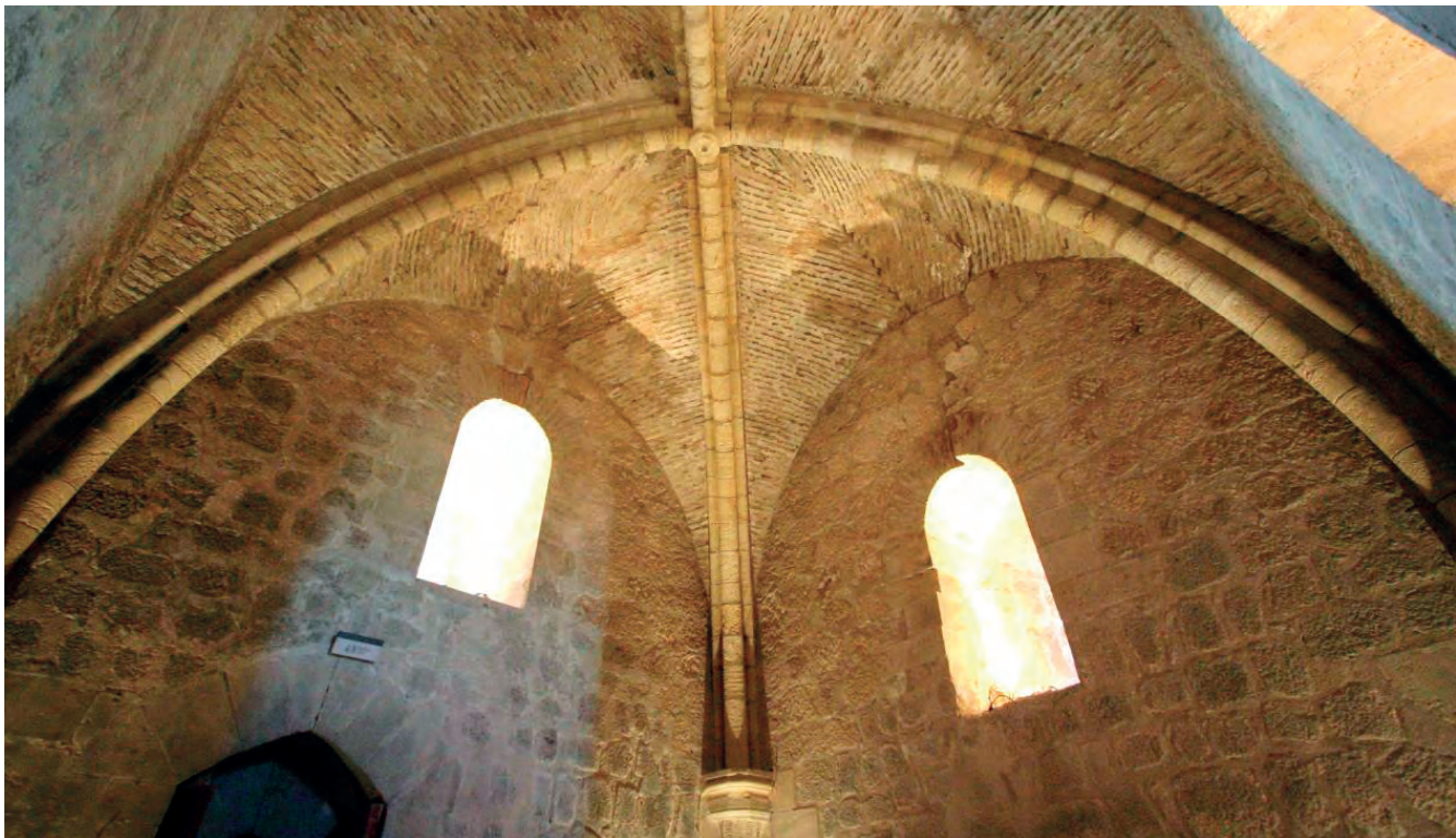
Figura 27. La bóveda superior bajo la terraza una vez restaurada y macizada. Fotografía: Carmen Martínez Ríos.
