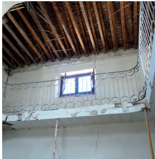
Figura 15 bis. Interior. Pasarela torreón, base de losa de atado.
