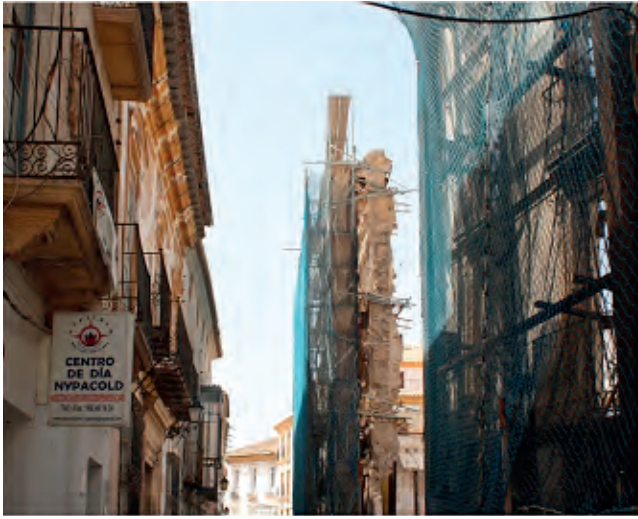
Figuras 7 y 8. Edificaciones demolidas con mantenimiento de fachadas y edificaciones apuntaladas para evitar su derrumbe.
