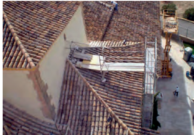
Figura 27. Fotografía: durante los trabajos en esta zona.
