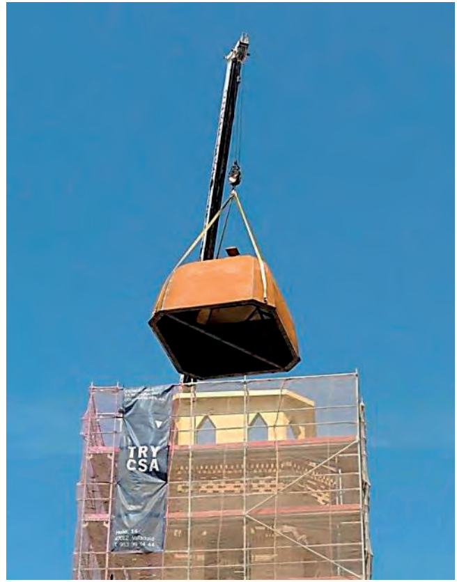
Figuras 41 y 42. Las piezas de acero esmaltado que conforman el tambor y el izado de la cúpula de acero cortén.
