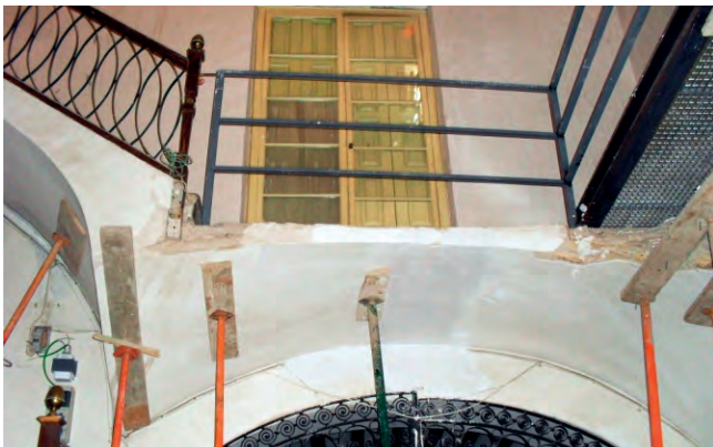
Figura 23. Intervención. Apeo losa escalera.
