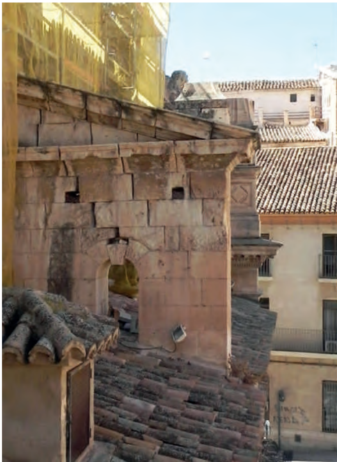
Figuras 5A y 5B. Contrafuerte de la nave inferior en el lateral de la Epístola, con rotura de la clave de su arco, la continuación de la grieta y el desplome de sillares causados por el terremoto, antes y después del mismo. Hemos mantenido el quiebro en el arco como testimonio material del terremoto (en el lateral norte incluso se han dejado presentes grandes descensos de dovelas). Fotografías: Juan de Dios de la Hoz.
