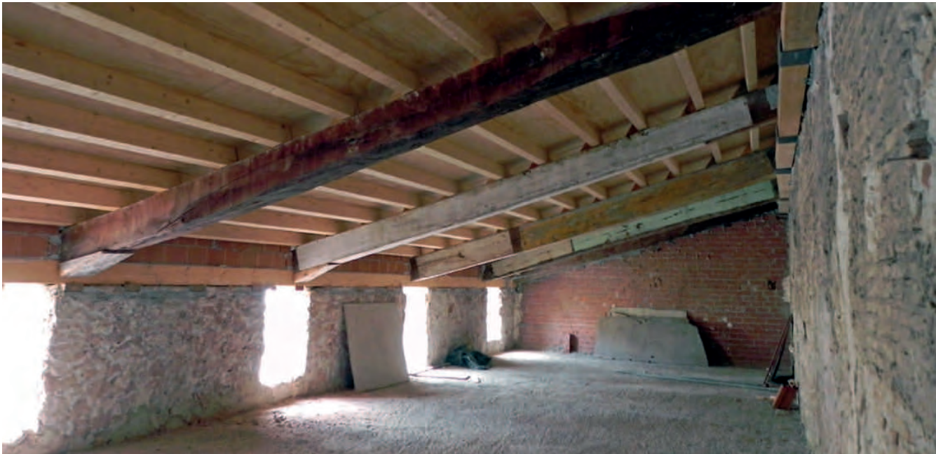
Figura 16. Estado final tras la reparación de la estructura y faldón de la cubierta en el cuerpo sobre la sacristía, manteniendo todas las vigas originales y colocando nuevas correas de madera laminada, tablero, onduline y la teja procedente del desmontaje. Fotografía: Juan de Dios de la Hoz.
