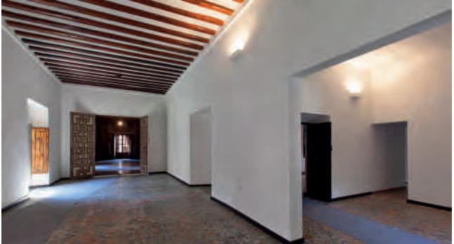
Figura 11. Restauración y rehabilitación de salones principales planta noble.
