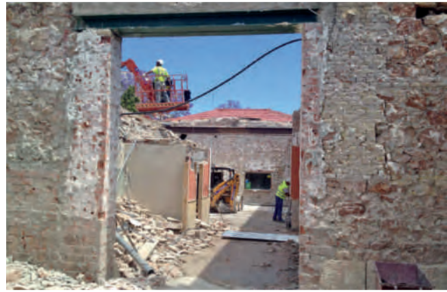
Figura 8. Primeras actuaciones. Reconstrucción y consolidación de muros. Fotografía: F. J. García Carreras.
