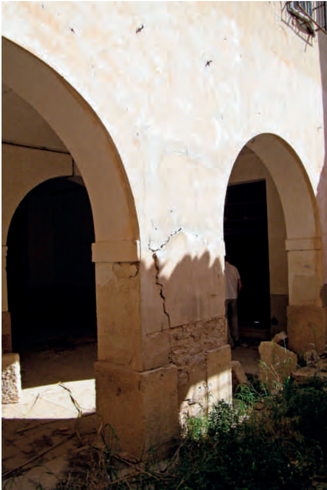
Figura 14. Detalle de las arcadas del patio interior.
