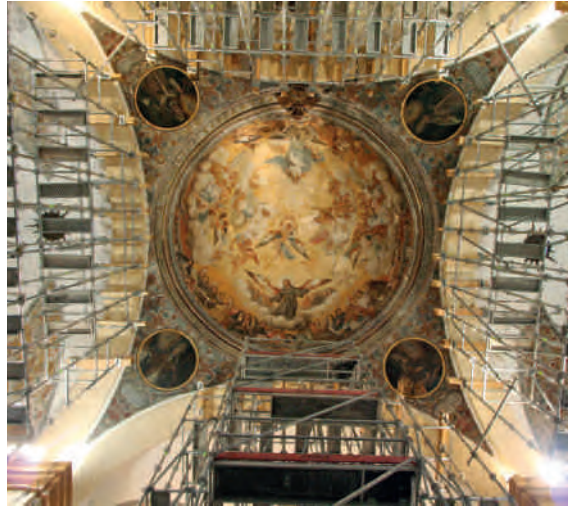
Figura 12. Apeo de los arcos del crucero de la iglesia de Virgen de las Huertas.
