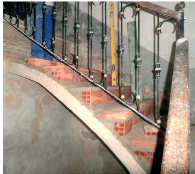
Figuras 35 y 36. Viguetas afectadas por la humedad sobre los nichos de la cripta y reparación de la bóveda y peldaño de la escalera de bajada a la cripta que se había partido con el sismo.
