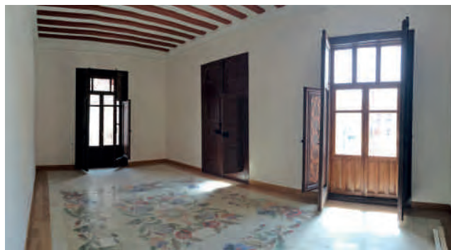
Figura 15. Imagen de una de las salas (planta primera) ya finalizada, donde se aprecia la recuperación de las piezas de baldosa hidráulica en el centro de la misma (la cenefa de madera exterior permite absorber los descuadres, así como las piezas que se rompieron durante el terremoto y los trabajos posteriores), los forjados de vigueta y revoltón ya reparados, así como las carpinterías, incluyendo la pintura esponjada de las contraventanas. Fotografía: Luis de la Hoz.
