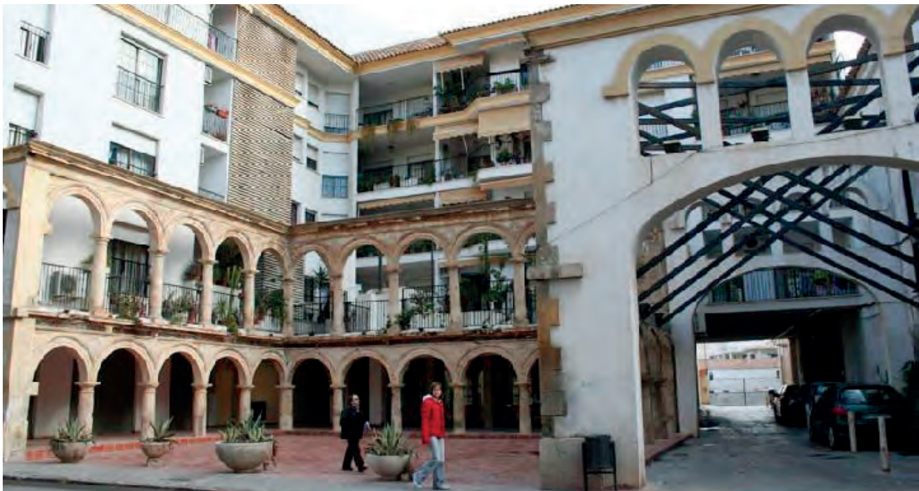
Figura 2. Vista general de las arquerías del claustro, englobadas en una construcción residencial, donde se aprecian las estructuras auxiliares que las soportan. Fotografía: www.regmurcia.com .
