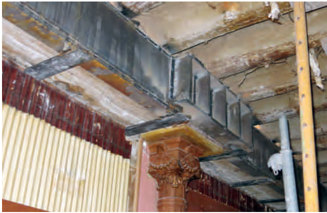
Figura 15. Refuerzo en capiteles de columnas de fundición.
