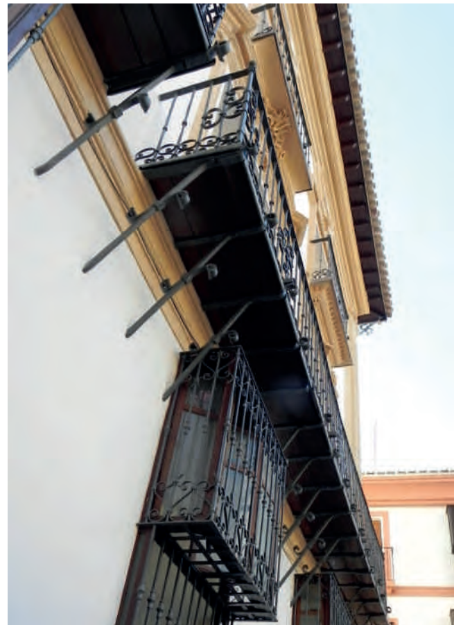
Figura 14. Vista inferior de algunos de los balcones, miradores y ventanas del edificio, una vez recuperadas las fábricas y, sobre todo, las carpinterías y cerrajerías. Fotografía: Juan de Dios de la Hoz.
