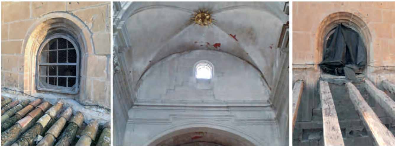
Figura 10. Tres imágenes de la ventana del transepto en el lado norte. A la izquierda, vista desde el exterior, en el centro desde el interior y, a la derecha, un detalle del apoyo de los pares del tejado adyacente, sobre este muro. En todas ellas se aprecia que la ventana ha sido mutilada, reduciendo enormemente su dimensión, al elevar la pendiente del faldón y cercenar el alfeizar y las jambas de piedra. Fotografías: Juan de Dios de la Hoz.
