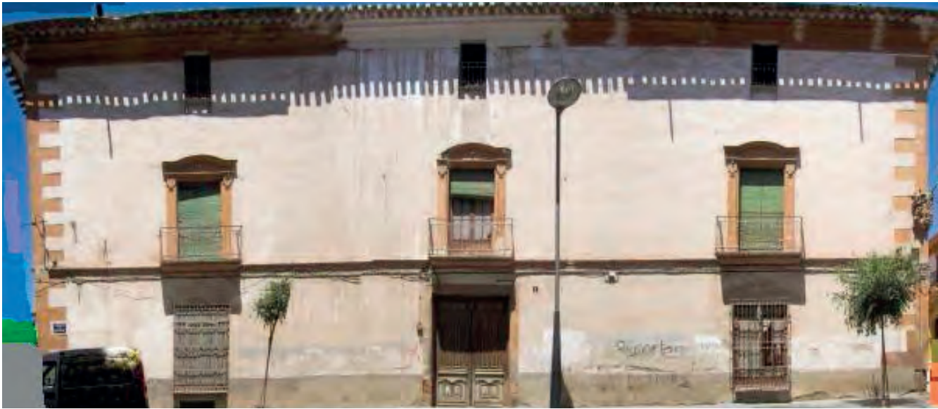
Figura 13. Fachada a calle Lope Gisbert. (Baños).
