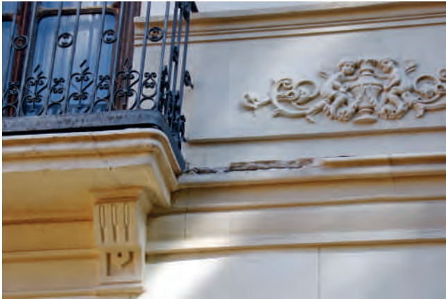
Figura 13 y 14. Daños en molduras y grietas en fachadas.
