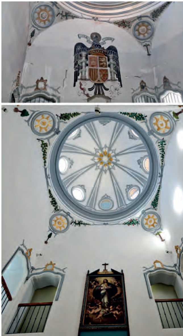
Figura 4. Escalera principal con el escudo nacional colocado en 1939 (arriba, fotografía del estado previo: Juan de Dios de la Hoz) y tras los trabajos de recuperación, con el lienzo de la Inmaculada presidiendo el hueco de la hornacina central (debajo, fotografía de Joaquín Zamora).
