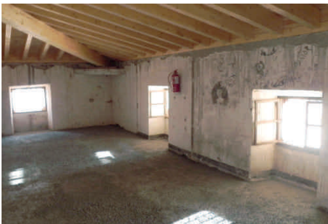
Figura 9. Vista del intradós de los faldones de la nueva estructura de cubierta de madera laminada. En la esquina se aprecia uno de los pocos cuadrales que pudieron mantenerse, pues fue necesaria la renovación casi completa de limas, durmientes y pares. Fotografía: Juan de Dios de la Hoz.
