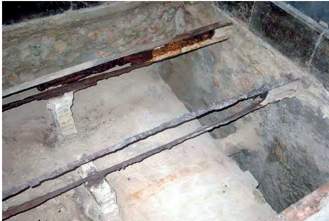
Figuras 35 y 36. Viguetas afectadas por la humedad sobre los nichos de la cripta y reparación de la bóveda y peldaño de la escalera de bajada a la cripta que se había partido con el sismo.
