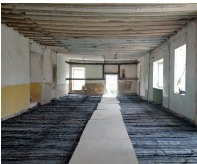
Figura 9. Refuerzo de forjados existentes.
