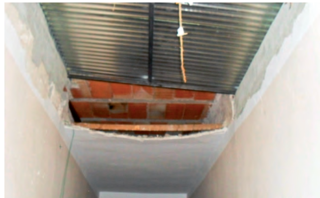
Figura 24. Intervención para evitar afecciones por fenómenos meteorológicos. Chapa de cubierta.
