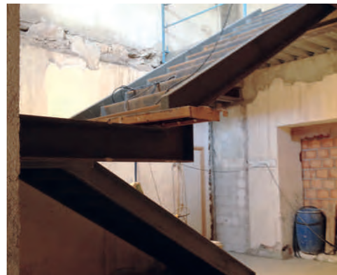
Figura 10. Ejecución de escalera de comunicación interior.
