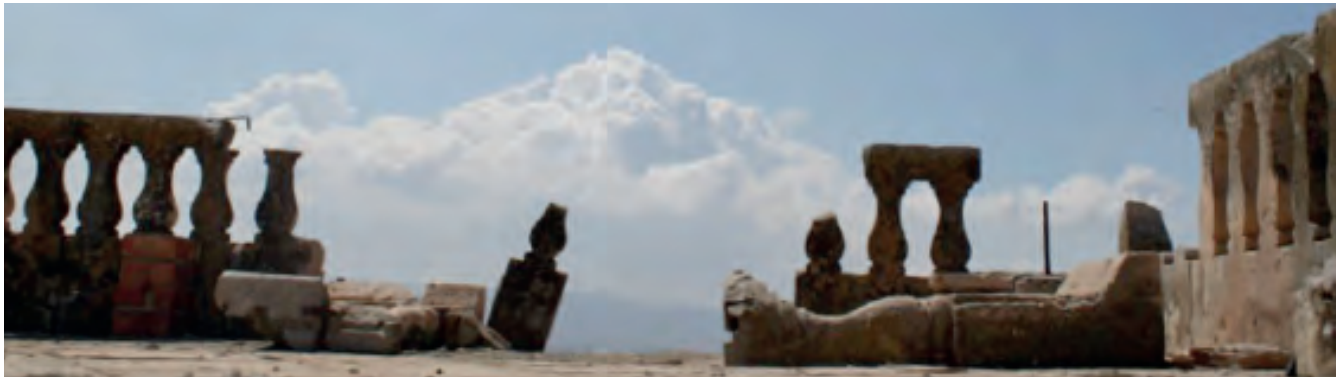
Figura 4. La balastrada del campanario.
