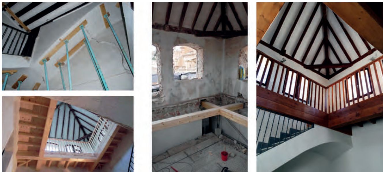
Figura 10. Secuencia de imágenes con diversos trabajos ejecutados en el torreón hasta devolver su función primitiva como lucera de la escalera del edificio, eliminando el forjado espurio intermedio y manteniendo (restaurándola), la estructura de pares y limas de la cubierta. Fotografías: Juan de Dios de la Hoz.
