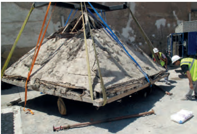
Figura 14. Puesta a tierra de la estructura de cubrición.
