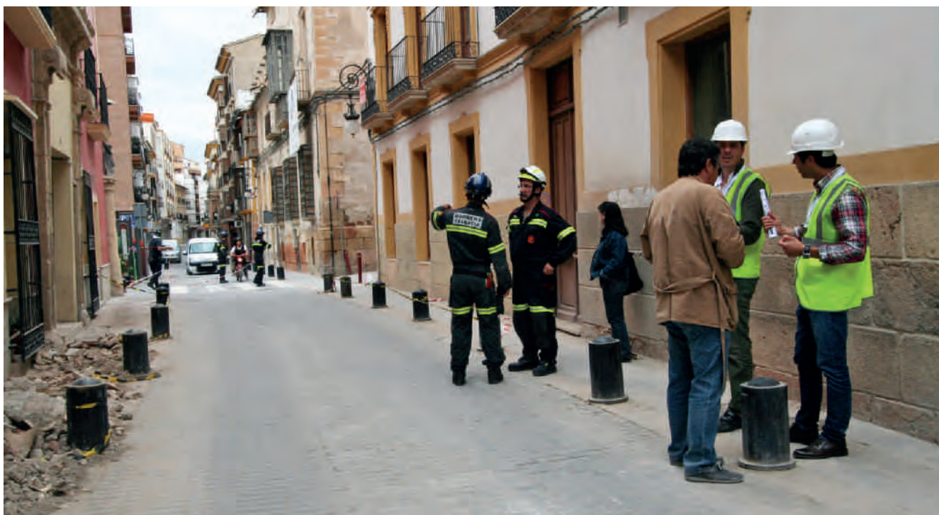
Figura 6. Equipos de inspección de la edificación durante sus actuaciones en calle Corredera.
