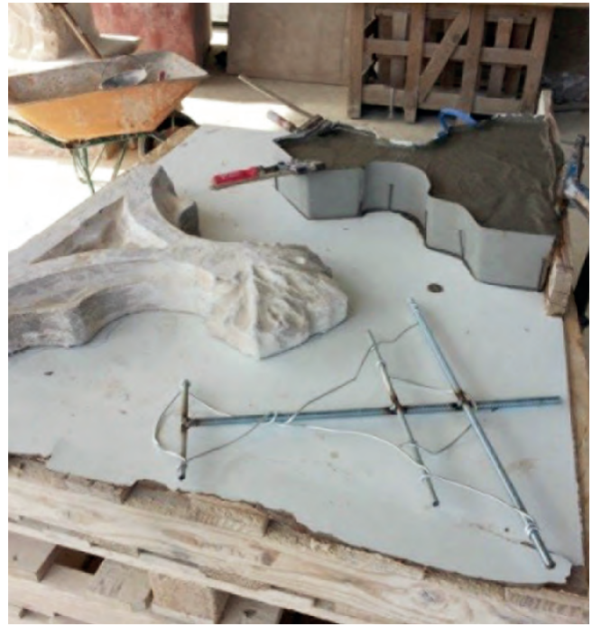
Figura 5. Detalle de las piezas en la clave de la puerta del panteón, así como algunas de las varillas de fibra colocadas para unir las entre sí. Fotografía: Reyes Molina
