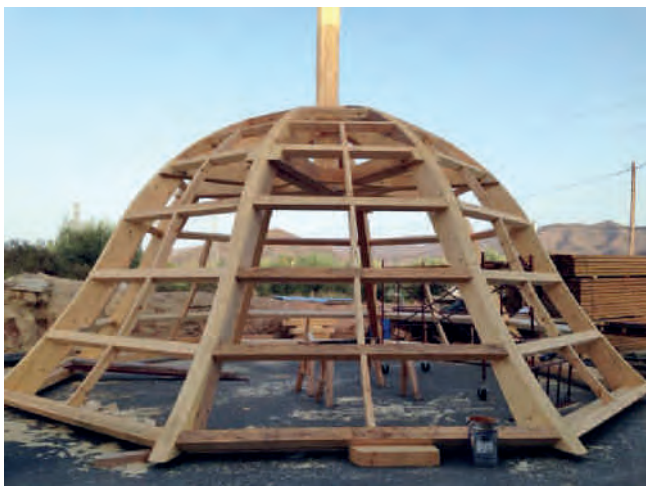
Figuras 17. Estructura de madera correspondiente a la armadura de sujeción de la cubierta, con un durmiente octogonal, pares curvos, correas, parecillos, así como un reloj de nudillos horizontales capaces de sujetar el vástago para la colocación de la bola, veleta y cruz superiores. Fotografía: Juan de Dios de la Hoz.
