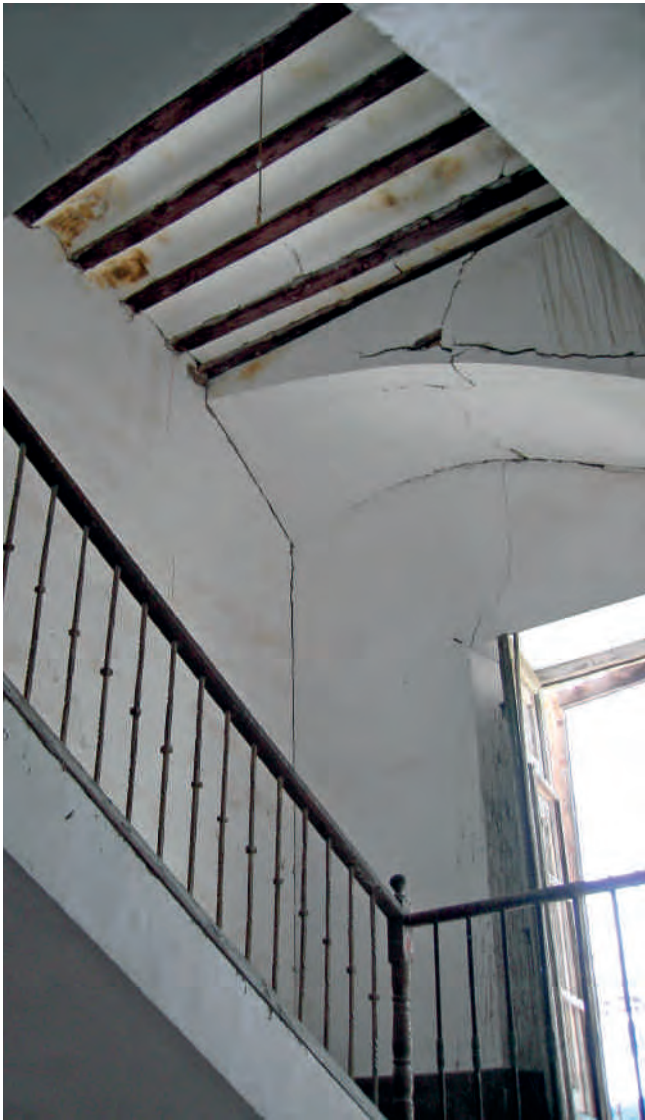
Figura 20. Detalle de escalera principal en planta primera.
