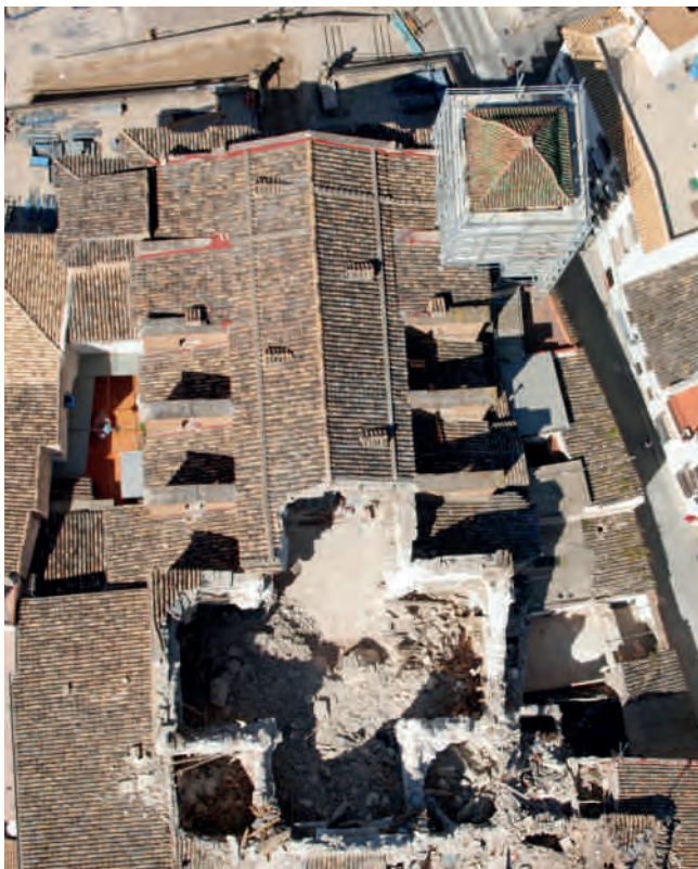
Figuras 4 y 5. Vista desde el sotocoro con la destrucción del crucero y el consiguiente amontonamiento de escombros, casi hasta la altura de los capiteles. Juan de Dios de la Hoz. Vista aérea (prácticamente en la vertical del crucero) con su derrumbe completo, así como las dos capillas laterales y el primer tramo de la nave central. Ginés Méndez, Lorquimur.
