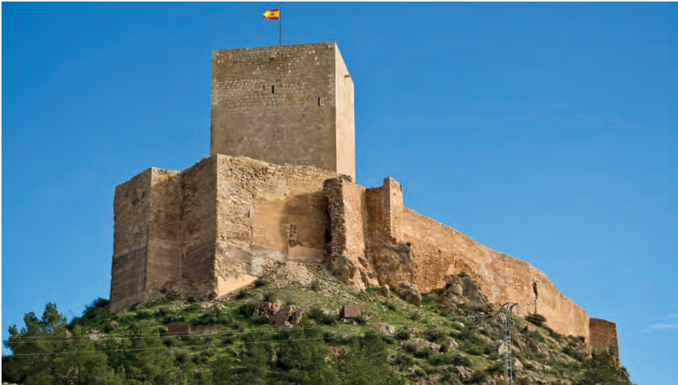
Figura 4. Torre del Espolón, del castillo de Lorca, tras las obras de consolidación. Fotografía: José Luis Municio.
