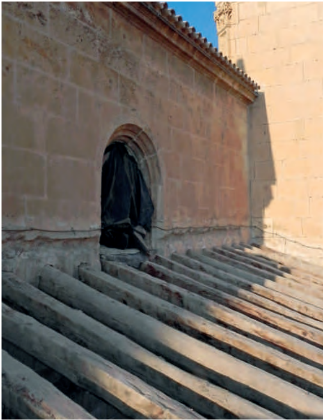
Figura 12. Imágenes correspondientes a la cubierta del transepto sur, antes de las obras (izquierda) y durante los trabajos (derecha). Se ha reducido la pendiente del faldón hasta introducir los palos en los antiguos mechinales en el muro, dejando libre completamente la ventana. Gracias a ello se recupera la dimensión completa (queda reflejado en la fachada, el nivel que alcanzaban los faldones, mutilando las jambas y lo hemos resaltado en línea de puntos sobre la imagen). Fotografías: Juan de Dios de la Hoz.
