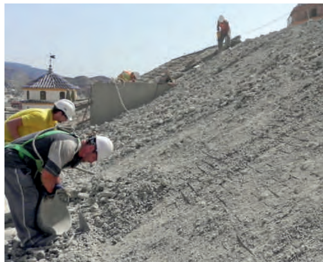
Figura 4. Retirada de la losa de hormigón sobre la cubierta de la nave central de San Patricio. Fotografía: Juan de Dios de la Hoz.
