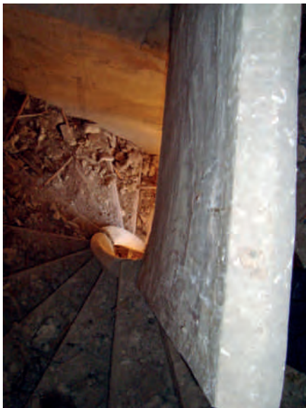
Figura 19. Escalera de caracol de acceso al torreón con rotura de su nabo central.
