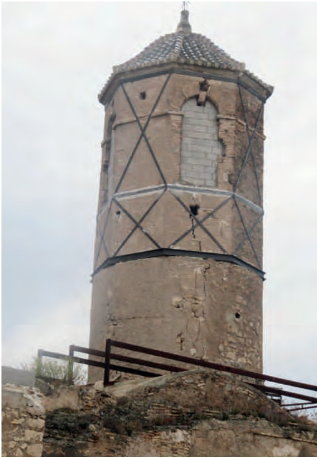
Figura 5. Vista de la torre campanario, una vez realizados los refuerzos de emergencia.
