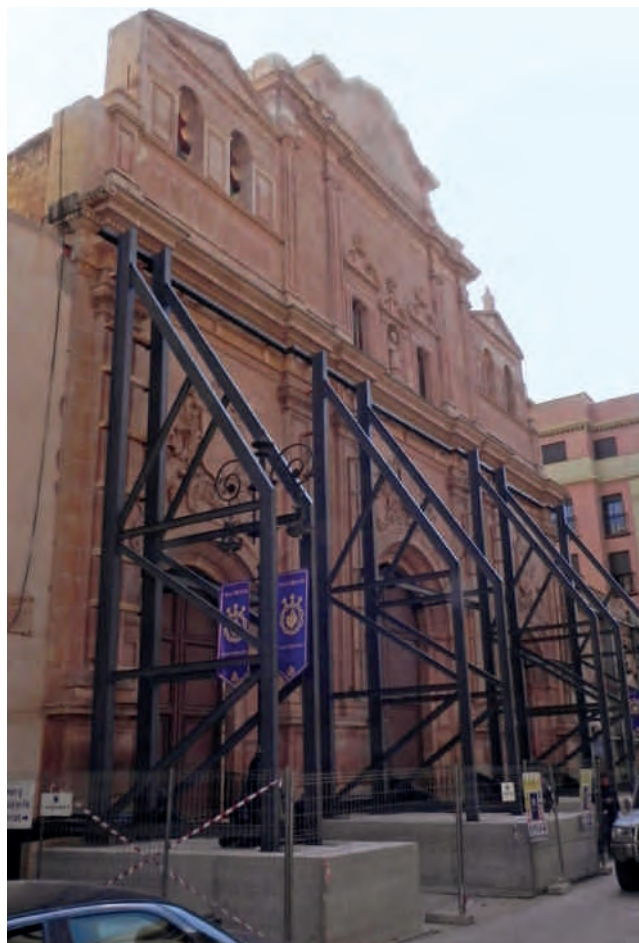
Figura 4. Apeo colocado en la fachada de la iglesia del Carmen para estabilizarla e impedir los movimientos de vuelco hacia la calle Nogalte. Fotografía: Juan de Dios de la Hoz.
