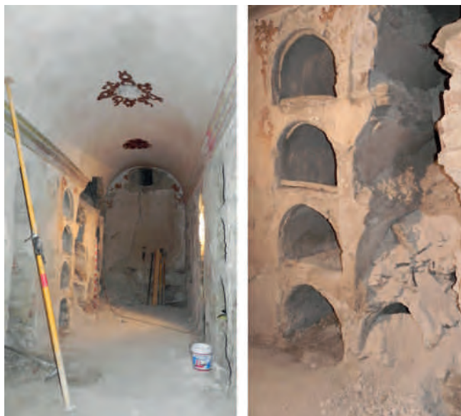
Figuras 7. Cripta bajo la sacristía de la iglesia de Santiago y detalle de una de las filas de nichos, completamente destruida en sus paramentos y desplomadas sus bóvedas, cayendo todo el material y restos sobre la inferior. Fotografía: Juan de Dios de la Hoz.
