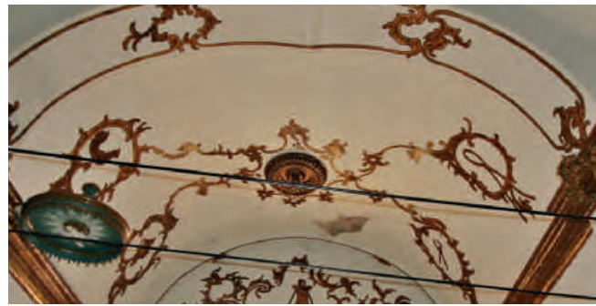
Figura 5. Aspecto que presentaba la bóveda tras producirse su rotura por la clave.
