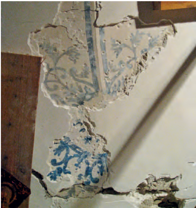
Figura 12. Desprendimiento del yeso que mostró la existencia de motivos geométricos en los techos de la escalera y estado final de uno de ellos, correspondiente a la planta baja. Fotografías: Juan de Dios de la Hoz.
