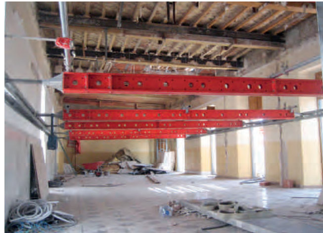
Figura 3. Estabilización de muros en el interior.
