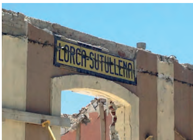
Figura 5. Detalles de la construcción original. Fotografía: F. J. García Carreras.
