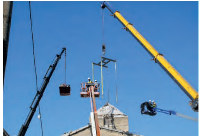
Figura 11. Desmontado de la estructura de madera a cuatro aguas. Se realizó con cuatro grúas y plataformas.
