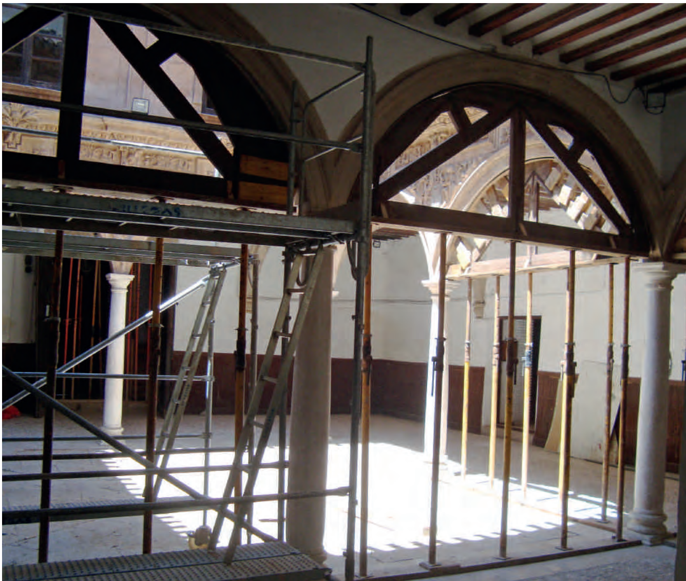
Figura 4. Obras de emergencia de apeos de los arcos en el patio del palacio.
