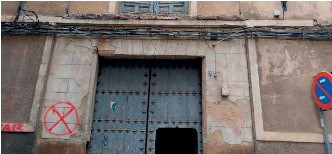
Figura 22. Detalle de fachada principal con restos de la existencia de las balconadas.
