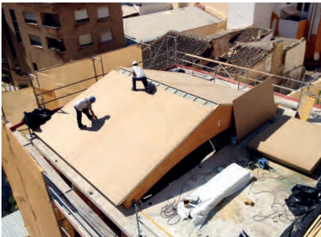
Figura 7. Tablero de cubierta anexo Gota de Leche.
