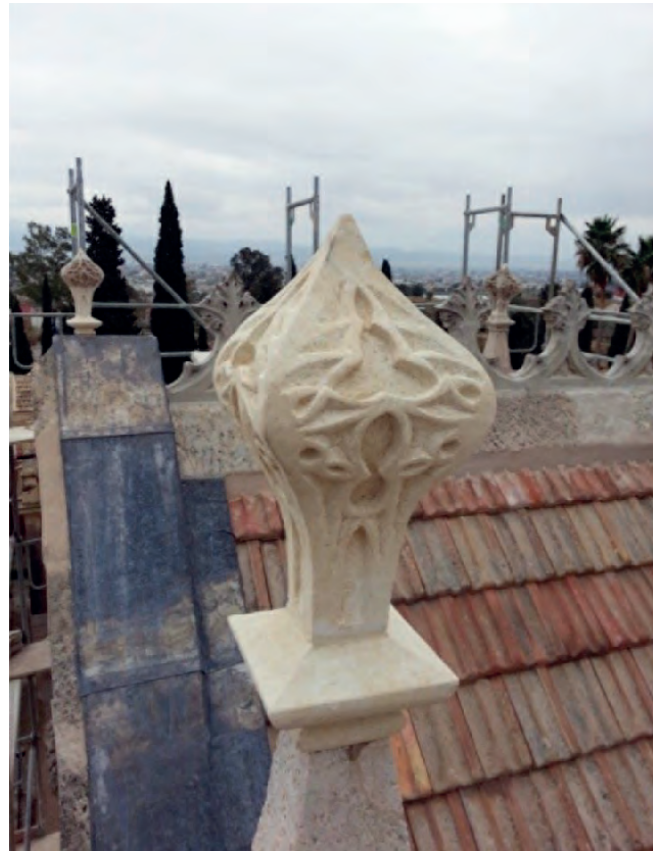
Figura 6. Detalles de la recuperación de las piezas ornamentales de la crestería. Fotografías: Reyes Molina.
