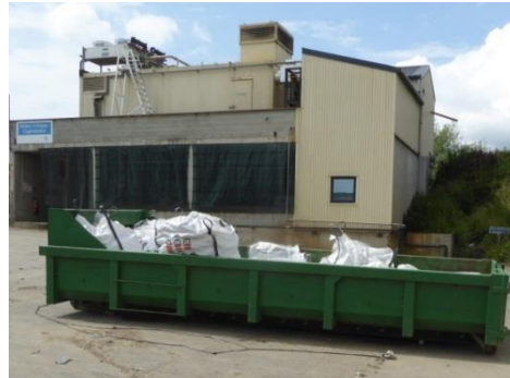
Contenedor de residuos de amianto. Fuente: A2Conseils sprl
