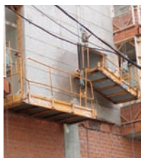
Trabajos con andamios (colgantes, apoyados, sobre mástil, etc)
