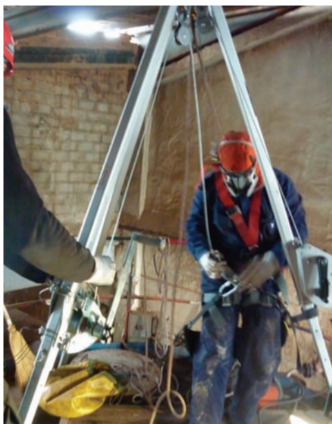
Imagen dcha. Acceso en profundidad mediante el uso de tripode como anclaje
