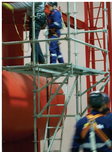
Imagen izqda. Mantenimiento de instalaciones industriales mediante el uso de andamios
