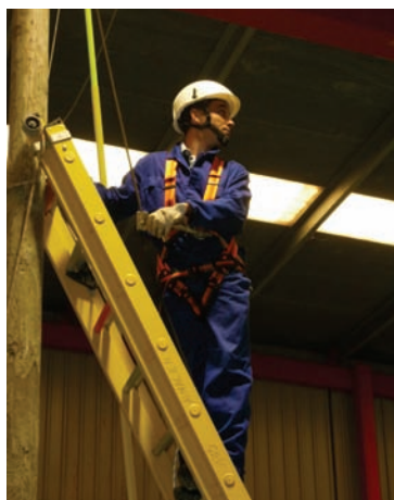
Imagen izqda. Trabajos en andamios apoyados o colgantes
