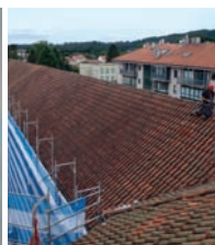
Trabajos en forjados y en cubiertas
