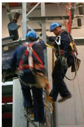
Imagen izqda. Rescate en un apoyo eléctrico
