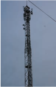
Imagen dcha. Detalle de la escalera instalada por el interior de la estructura de celosía de la torre
