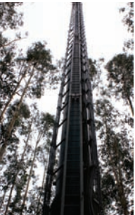
Imagen dcha. Detalle de la escalera instalada por el interior de la estructura de celosía de la torre
